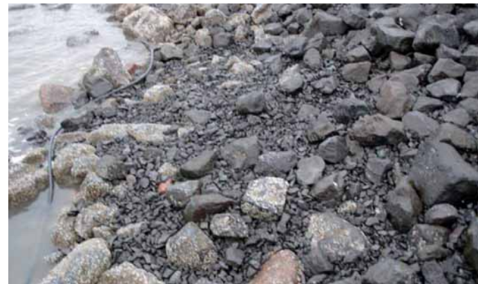
Freiliegende Schotterschicht westlich Glameyer Stack, Quelle: BAW
