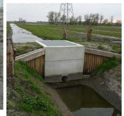
Abbildung 2-4: Regelungsbauwerk zur Steuerung der Vernässung im Maßnahmensgebiet Hetlingen/Giesensand am 14.04.2008. Die erste Wintervernässung des Jahres 2007/2008 auf der flach eingestauten Parzelle haben nur wenige Pflanzen überstanden. Aber bereits am 28.07.2008 hatte sich ein überflutungstoleranter Straußgras-Flutrasen entwickelt (kleines Bild oben).
