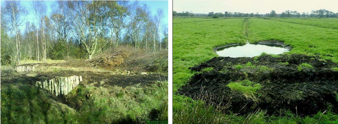
Abbildung 2-8: Grabenverbau am Krugsdammgraben (links) und Grüppenverschluss mit Aufweitung (rechts), Oktober 2007, Fotos Wolfgang Kähler, WSA Hamburg.
