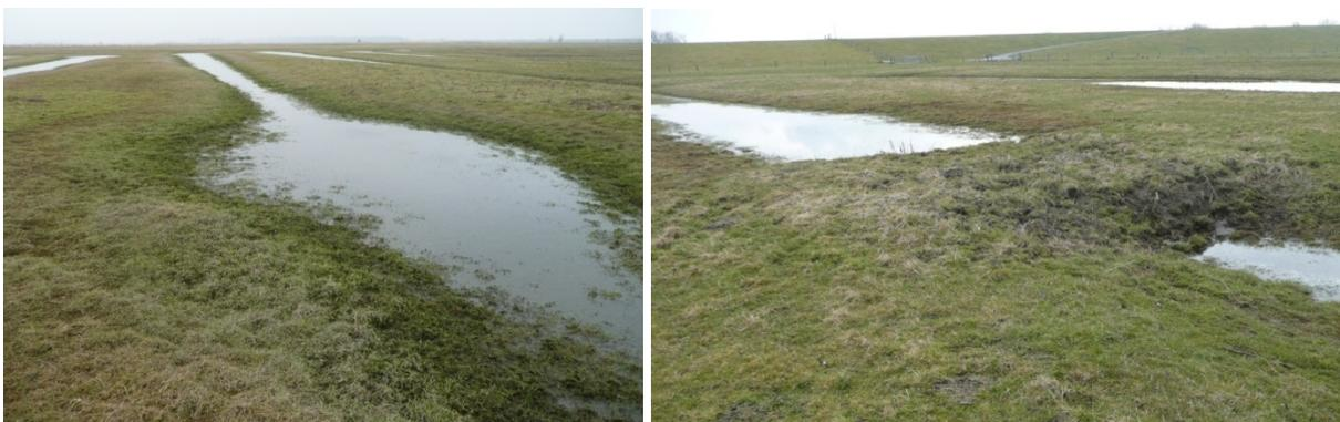
Abbildung 2-5: Maßnahmen zur Vernässung: Links Grüppenaufweitung (Hullen, 15.03.2011), rechts Erddamm zum Abdämmen einer Grüppe (Belum, 14.03.2011).
