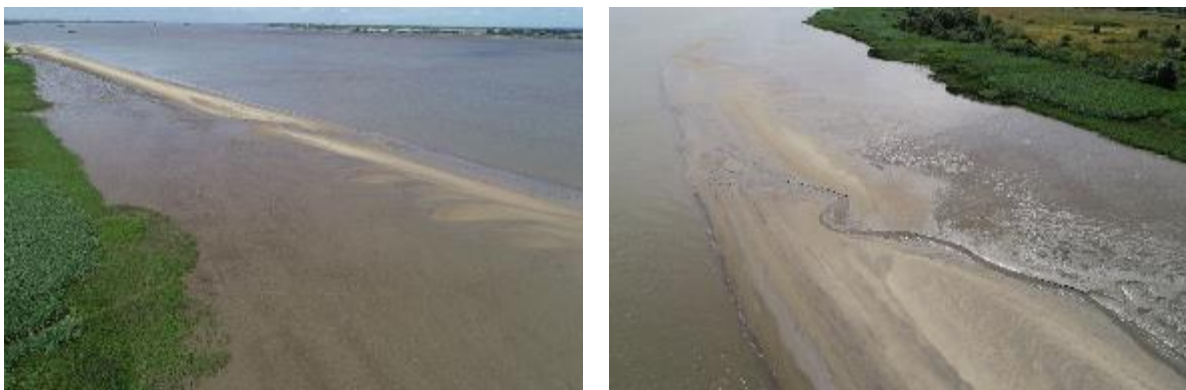
Abbildung 20: Vorgelagerte Sandbank in Schwarztonnensand, Aufnahme 7.7.2020 (links, Blick nach Westen, rechts Blick nach Osten)
