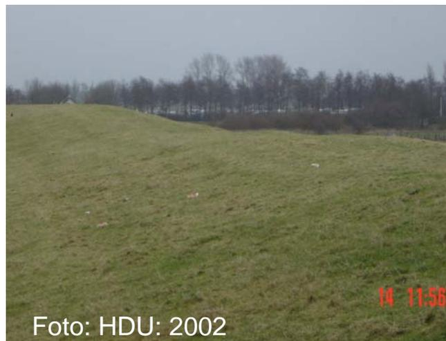
**Bild 1 Deichsetzungen des Deiches im Altenbrucher Bogen (Foto: Hadelner Deich- und Uferverband, 2002)**
