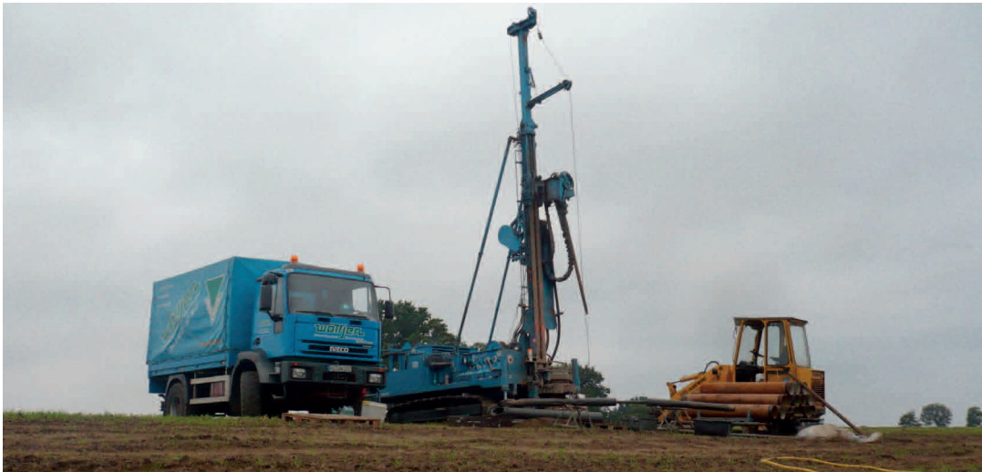
Abb. 4: Einrichtung einer Grundwassermessstelle
