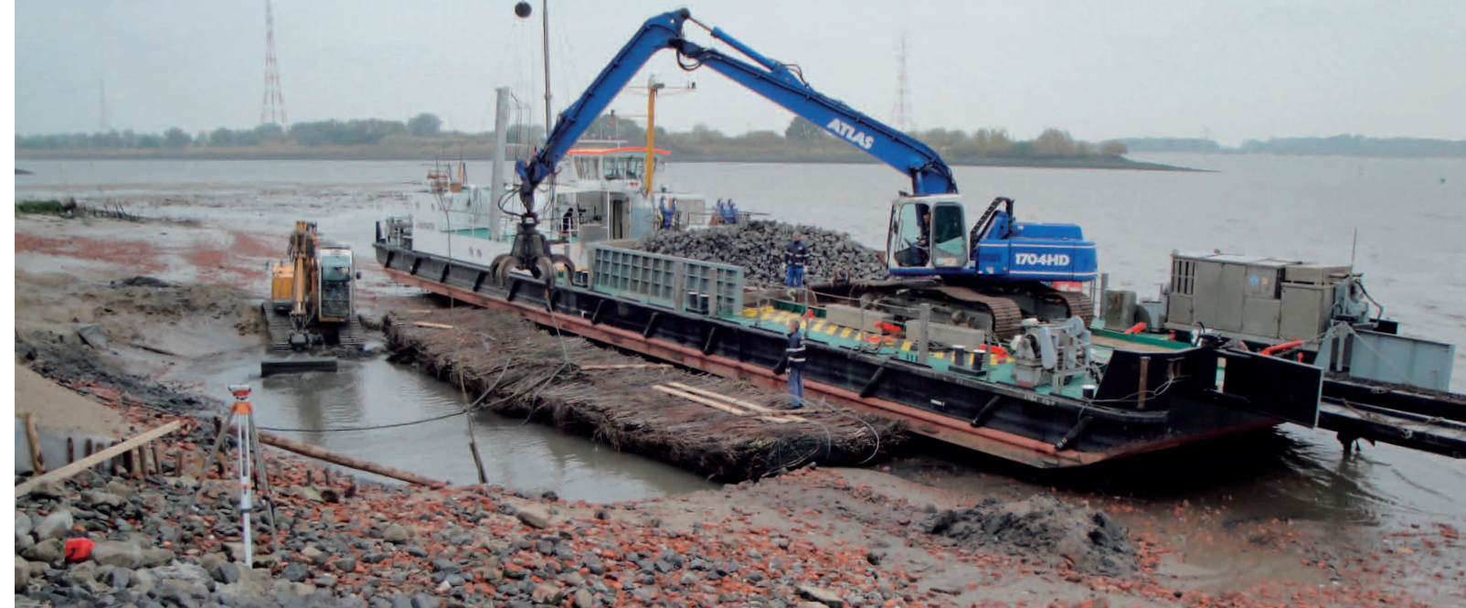
Abb. 4: Aufbau des Deckwerks Mojenhörn
