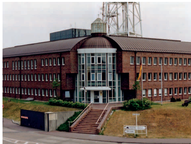
Abb. 2: Dienstgebäude WSA Cuxhaven
