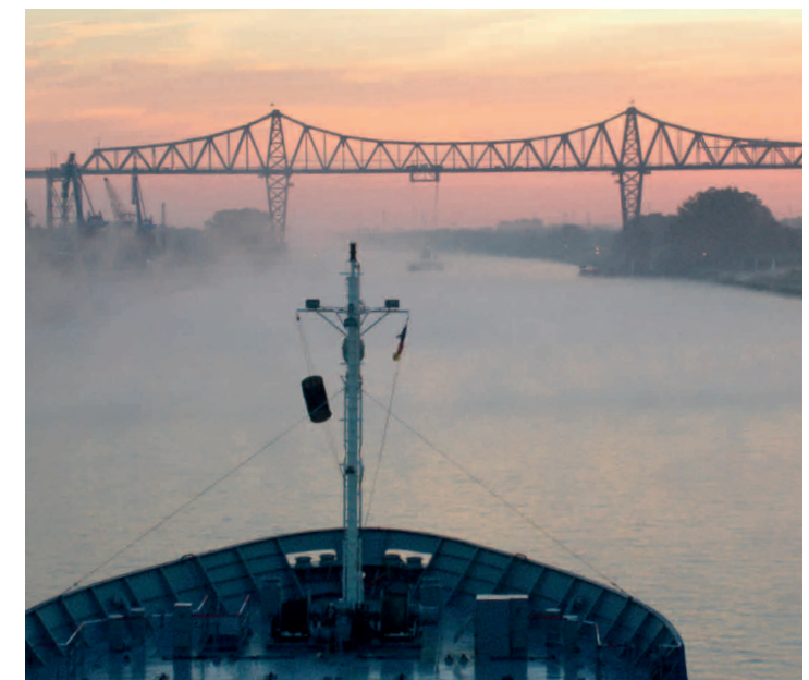
Abb. 5: Blick auf die Rendsburger Eisenbahnhochbrücke
