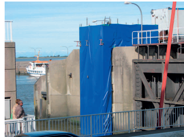
Abb. 3: Gerüst/Einhausung Wendesäule
