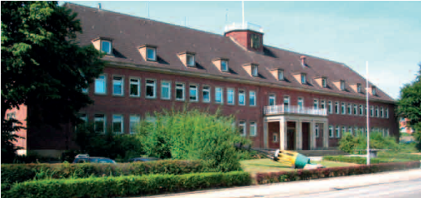
Abb. 1: Dienstgebäude der WSD-Nord
