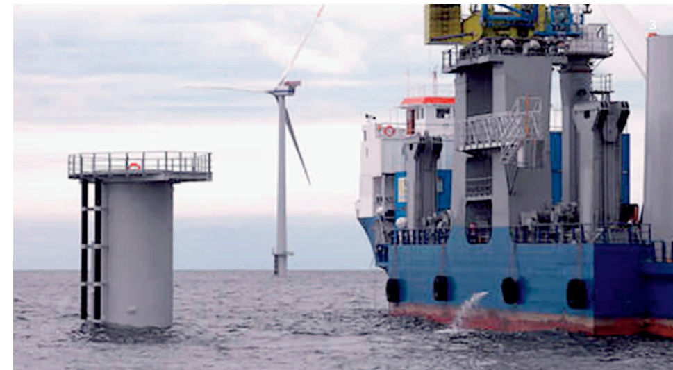
Abb. 1: Plattform für eine Offshore-Anlage © Vestas Central Europe
