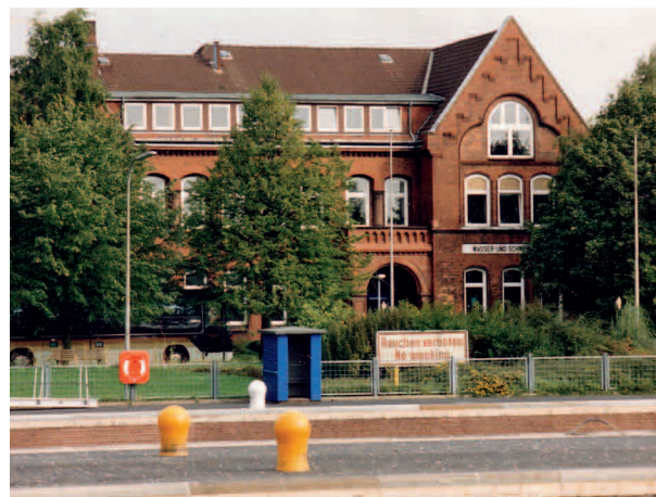
Abb. 2: Dienstgebäude WSA Kiel-Holtenau
