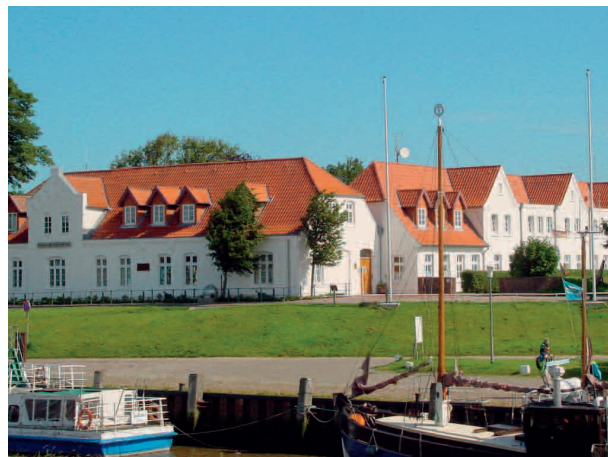
Abb. 1: Dienstgebäude WSA Tönning
