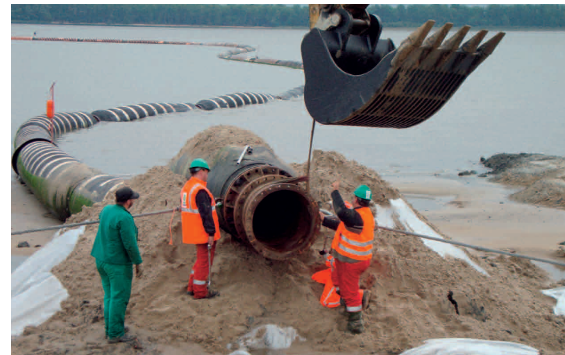
Abb. 2: Schwimmrohrleitung der Vorspülung Grauerort
