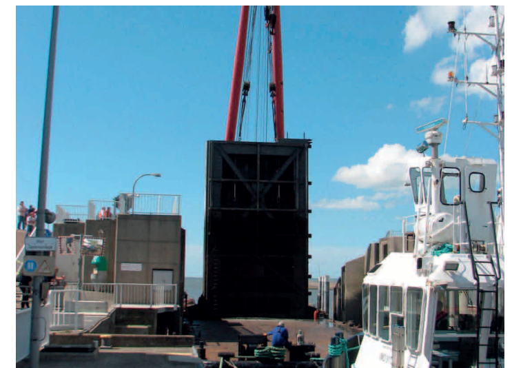
Abb. 4: Sanierte Gleitschiene/Schütze (oben)
