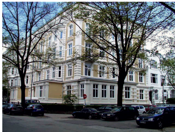
Abb. 1: Dienstgebäude WSA Hamburg
