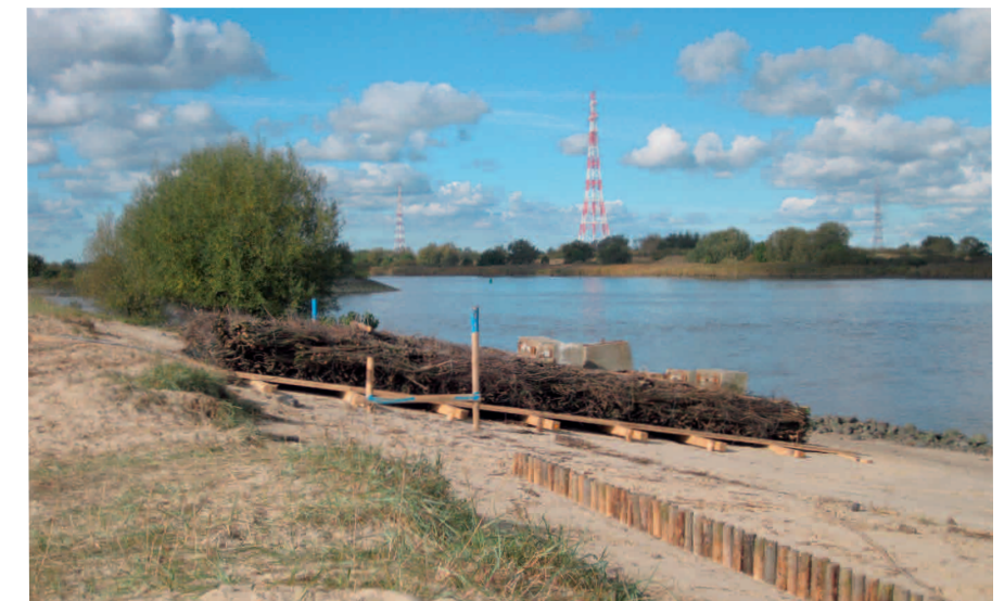
Abb. 5: Faschinenfußsicherung und Helling am Deckwerk Mojenhörn
