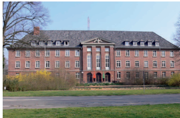
Dienstgebäude WSA Lübeck
