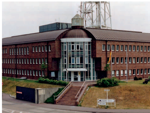
Abb.2: Dienstgebäude WSA Cuxhaven
