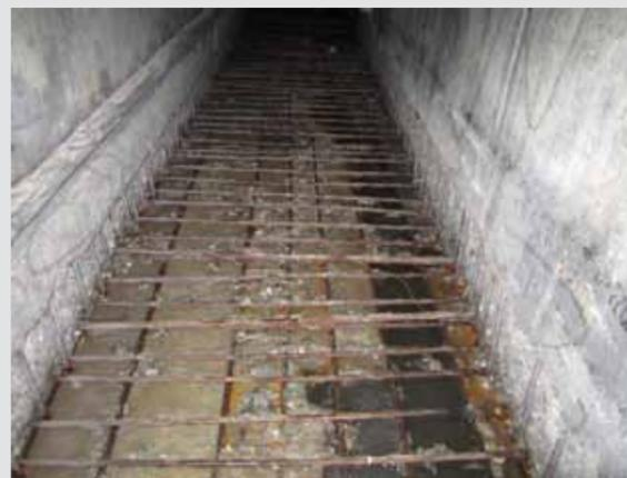
Abb. 2: Sohle Betriebsgang nach dem Höchstdruckwasserstrahlen
