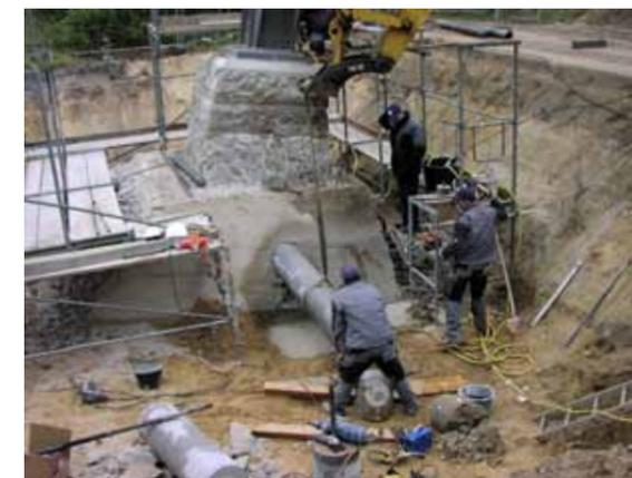
Abb. 3: Horizontalbohrung zum Einbau des neuen Verteilungsträgers
