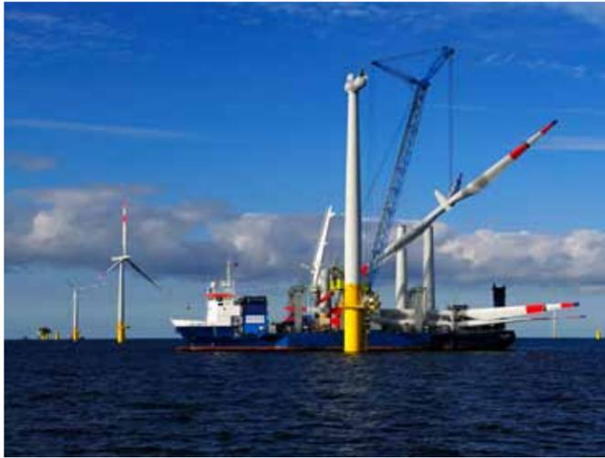
Abb. 4: Montage der Rotorblätter im Windpark Baltic 1 (Quelle: EnBW)
