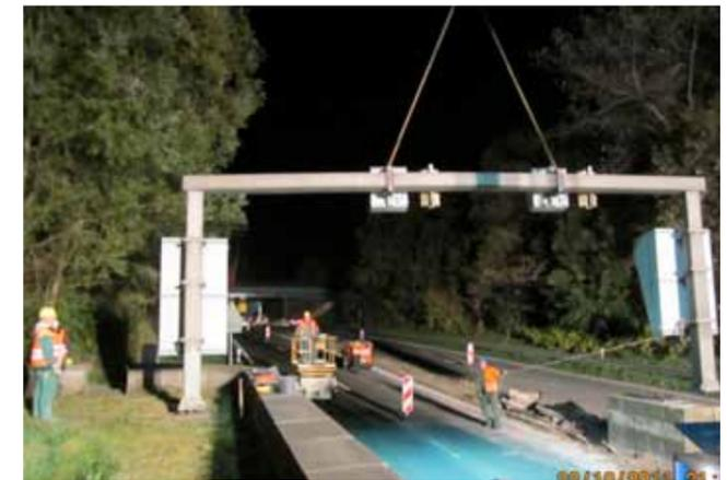
Abb. 3: Rückbau alte Verkehrszeichenbrücke
