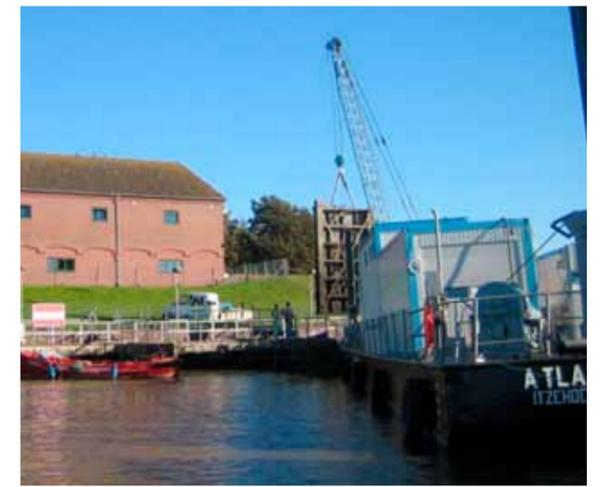
Abb. 4: Ausbau der Stemmtore, Wehrfeld 5, Unterwasser
