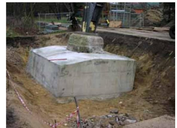
Abb. 4: Verstärktes Fundament Achse 54 Nord – West vor dem Verfüllen
