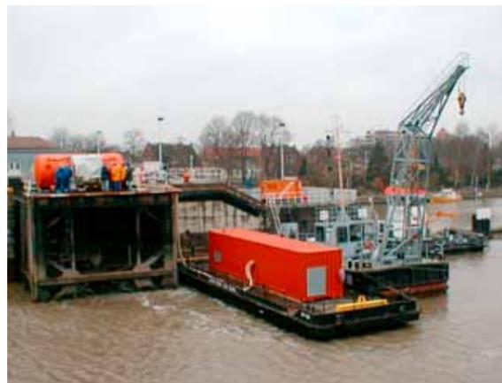
Abb. 1: Einsatz der Druckluftschleuse für Trockentaucher auf einem Schiebetor
