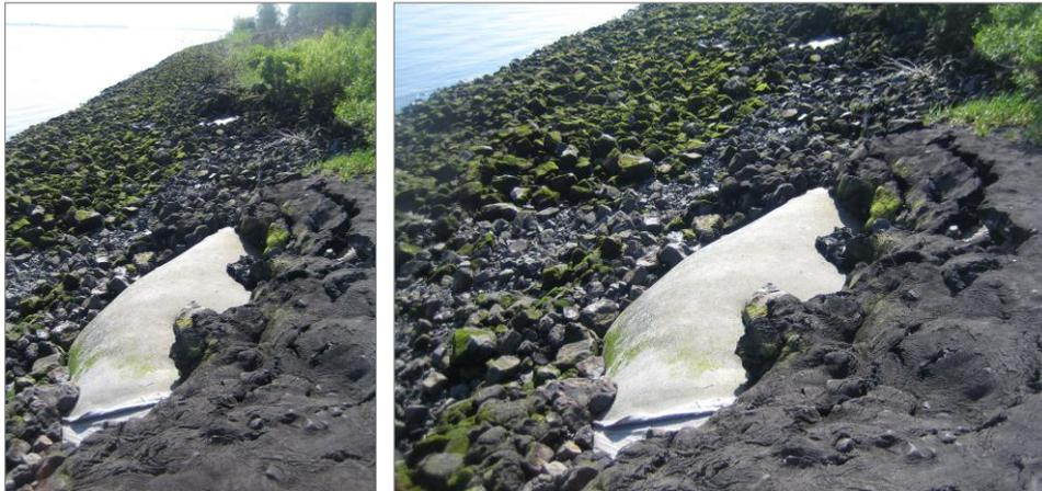
Abbildung 1-2: Schadensbild des fahrwasserseitigen Deckwerkes der Elbinsel Lühesand (Ortsbesichtigung am 05.05.2011)
