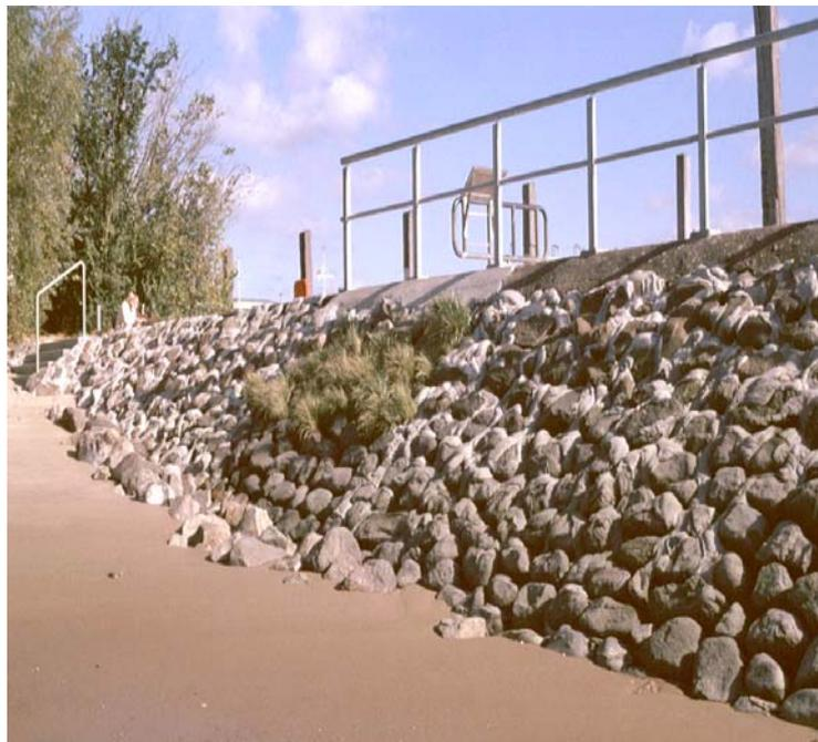
**Abbildung 4.1-2: Verklammerte Ufersicherung am Anleger Kollmar, bei Elbe-km 668, rechts. An einer weniger verklammerten Stelle hat sich die Wibelschmiele angesiedelt.**
