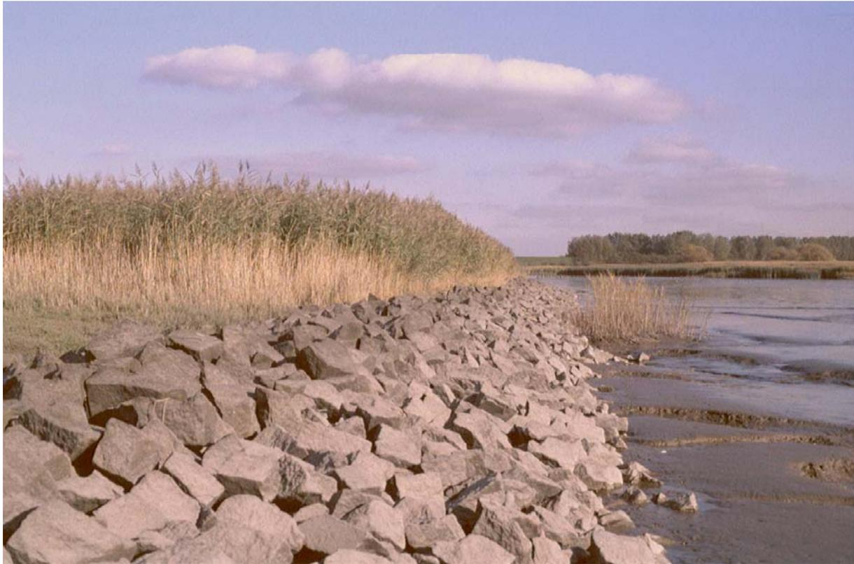
**Abbildung 5.2-8: Uferdeckwerk als wasserseitige Begrenzung eines Schilf-Röhrichts (Uferdeckwerk bei Eschschallen, Elbe-km 664)**
