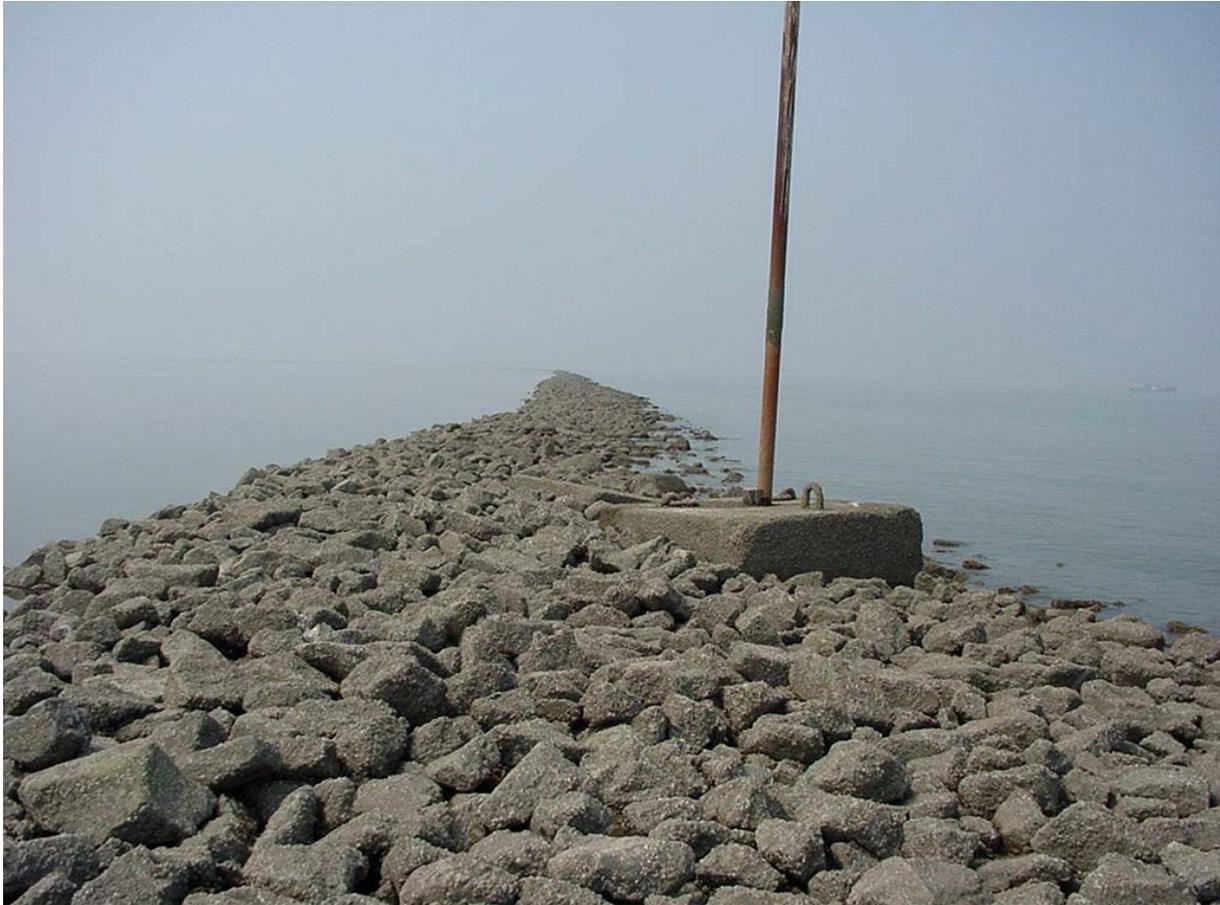
**Abbildung 3.1-12: Leitwerk im Bereich der Außenelbe (bei etwa Thw)**
