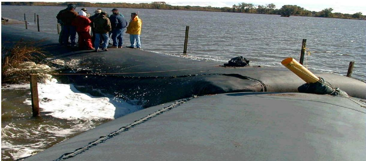
**Abbildung 3.2-5: Geotextile Container als Randsicherung einer Insel im Grass Lake, Illinois, (Quelle:<http://www.auf.uni-rostock.de/lbaw/lb/mitarbeiter/Cantre/geotextile%20Schl%E4uche.html>)**
