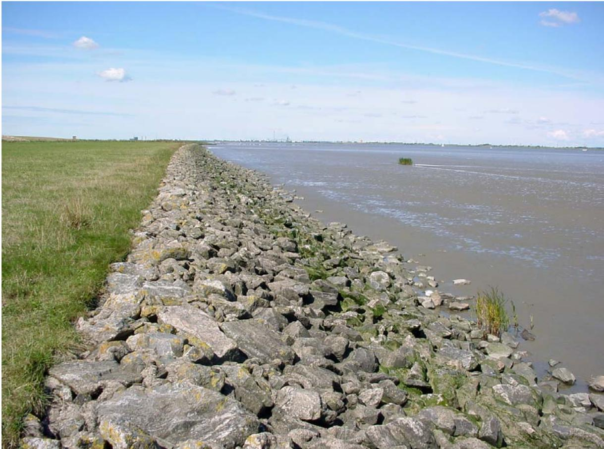
**Abbildung 4.1-1: Vegetationsloses Deckwerk mit Steinschüttung im Bereich Nordkehdingen (ca. Elbe-km 685)**
