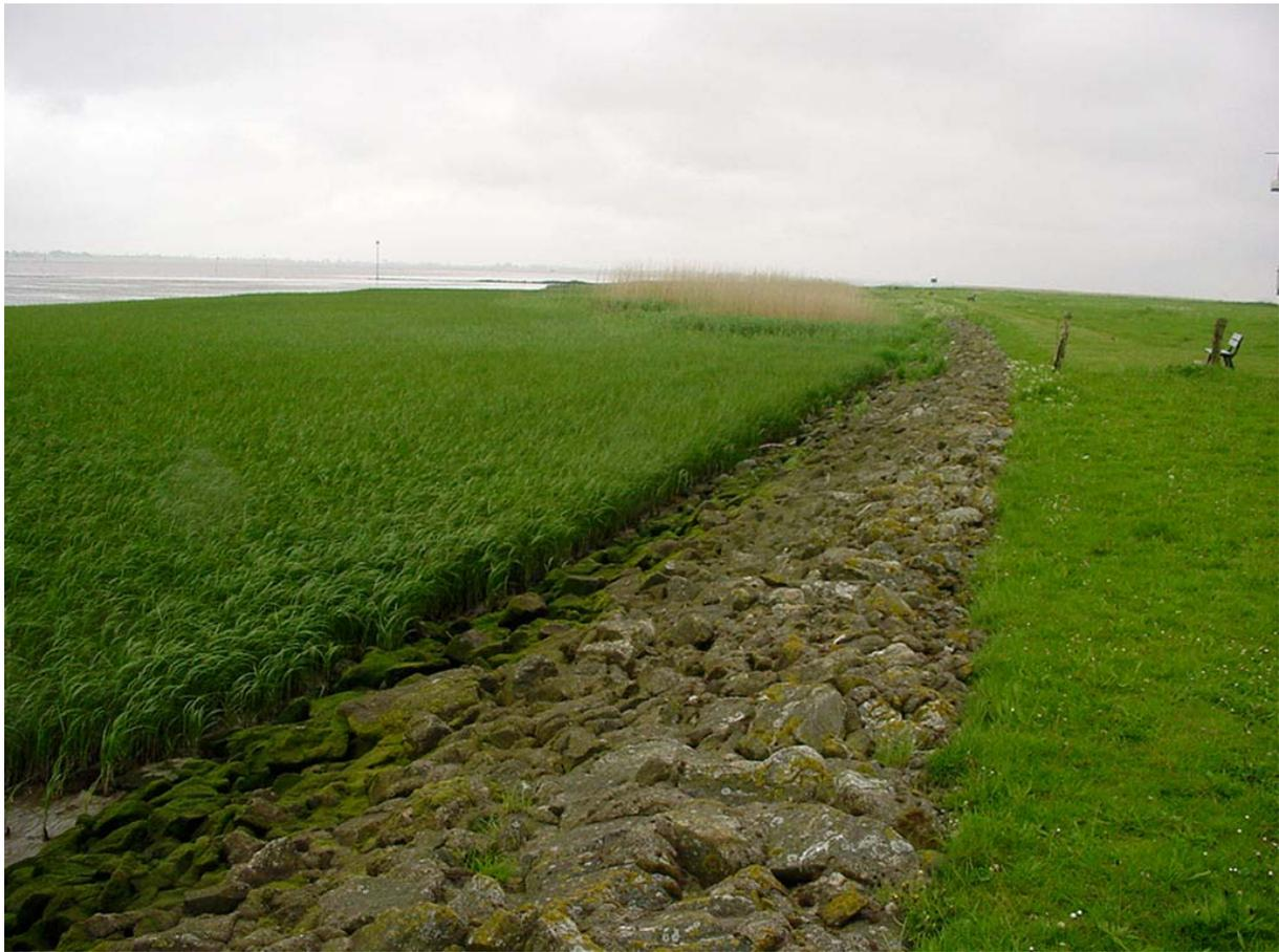
**Abbildung 5.2-7: Uferdeckwerk als landseitige Begrenzung eines Strandsimsen-Röhrichts (Nordkehdingen, ca. Elbe-km 683)**
