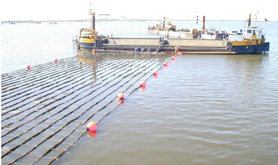
Abbildung 3-5: Sinkstückverlegung
