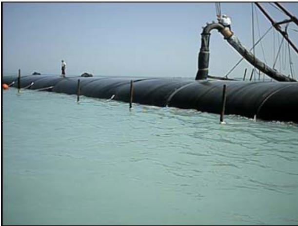
Abbildung 3-17: Geotextile Schläuche (Quelle [22])
