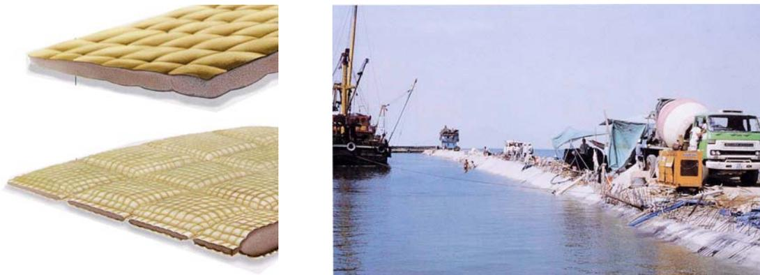
Abbildung 3-13: Geotextile Matten (Quelle [19])
