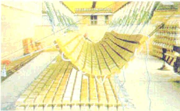
Abbildung 3-14: Betonsteinpflaster auf Geotextilien (Quelle [20])
