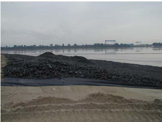
Abbildung 3-12: Einlagige Abdeckung (Geotextil nur als Trennlage)
