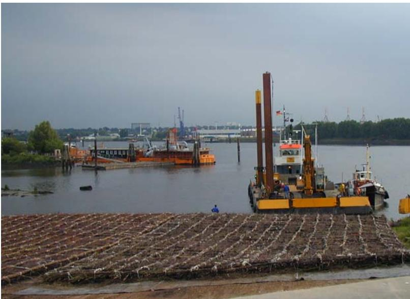
Abbildung 3-7: Sinkstück mit Buschwerk
