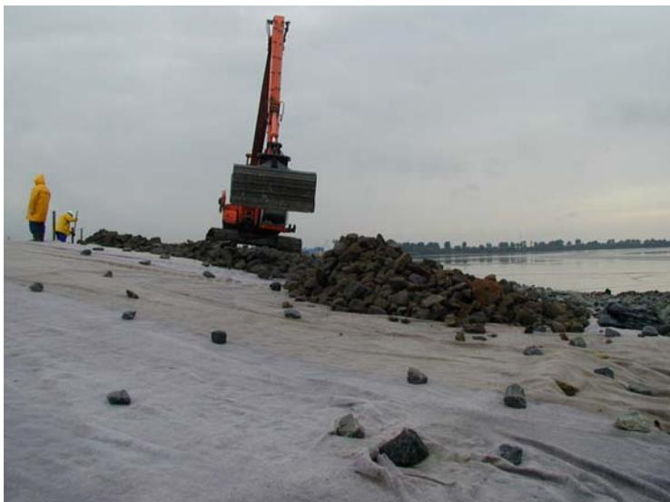
Abbildung 3-8: Deckschicht Wasserbausteine auf Geotextil
