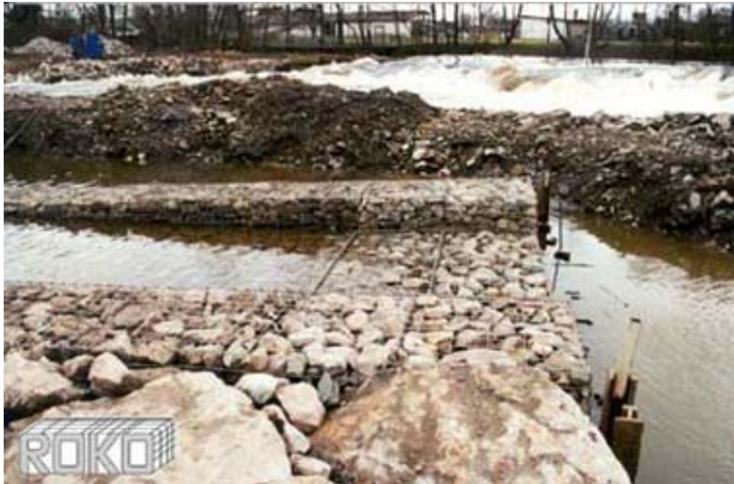
Abbildung 3-19: Gabionen als Sohlsicherung (Quelle [23])
