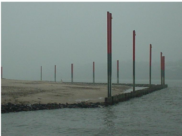
Abbildung 3-20: Spundwand als Sicherung einer Aufspülung (Quelle [24])
