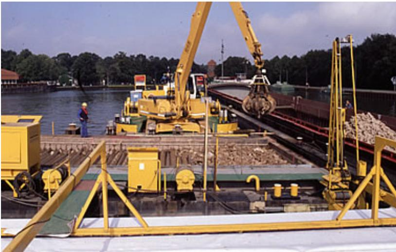
Abbildung 3-6: Geotextilverlegung ohne Faschinen (Quelle [18])
