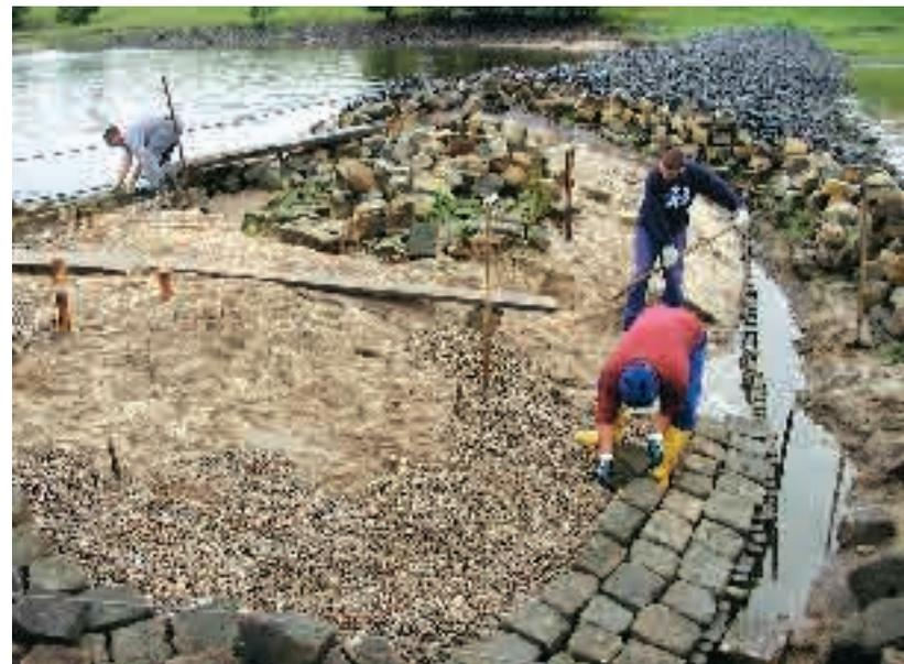
Instandsetzung einer zerstörten Buhne
