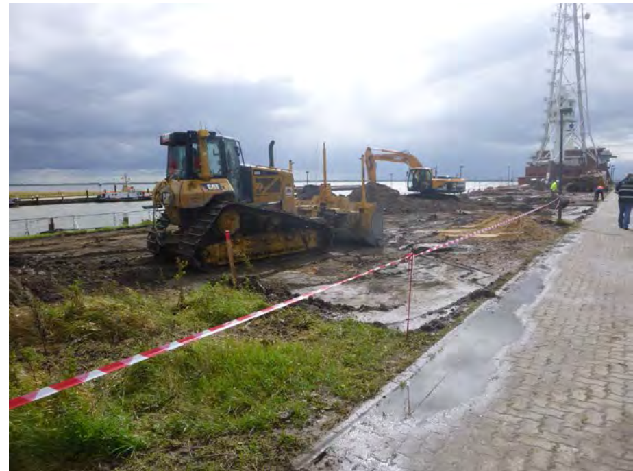
Abb. 12 Der Oberboden wird abgeschoben.
