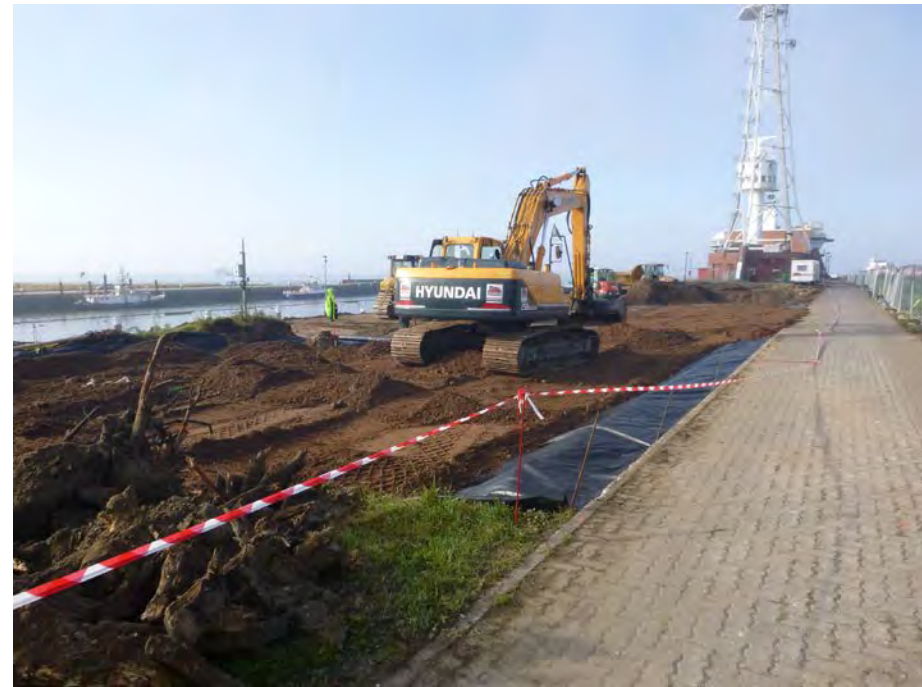
Abb. 16 ... der Unterbau aus sandigem Boden aufgefüllt ...
