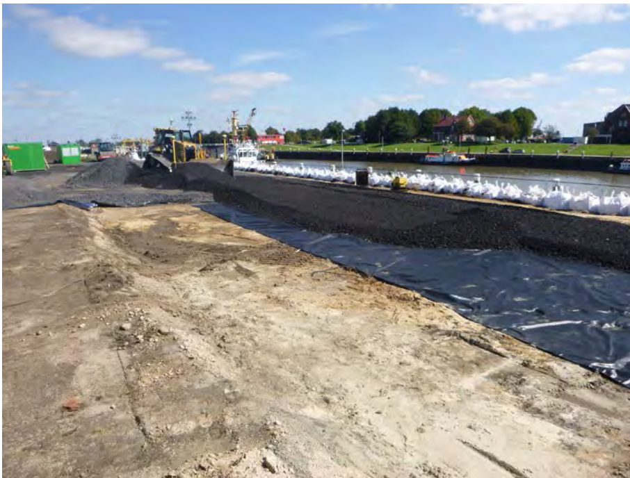
Abb. 17 ... und aufgeschottert.
