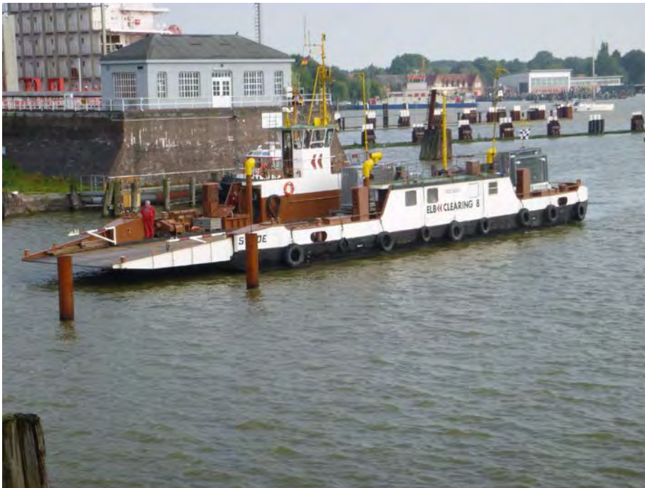
Abb. 1 Nach der Baufeldübergabe erfolgen die ersten Transporte. Geräte und Baumaterialien werden per Fähre angeliefert.
