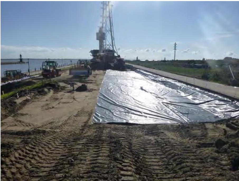
Abb. 15 Auf dem Planum wird ein Trennvlies aufgelegt, ...
