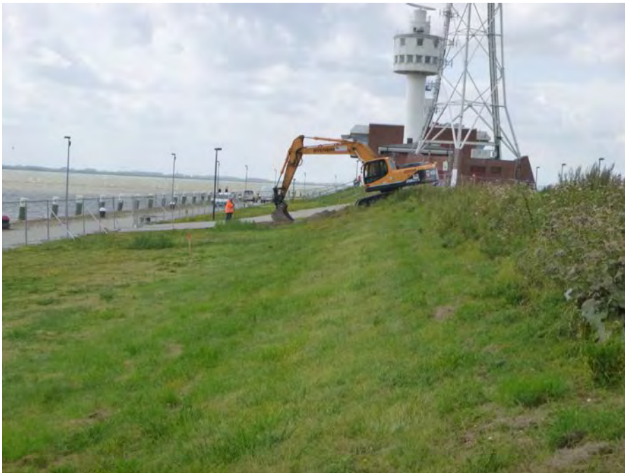
Abb. 5 und 6 Zur Herrichtung der Flächen für die Pfahlprobebelastungen werden Suchschürfe zur Ortung und Sicherung von einzelnen Leitungen und Leitungstrassen ausgeführt.
