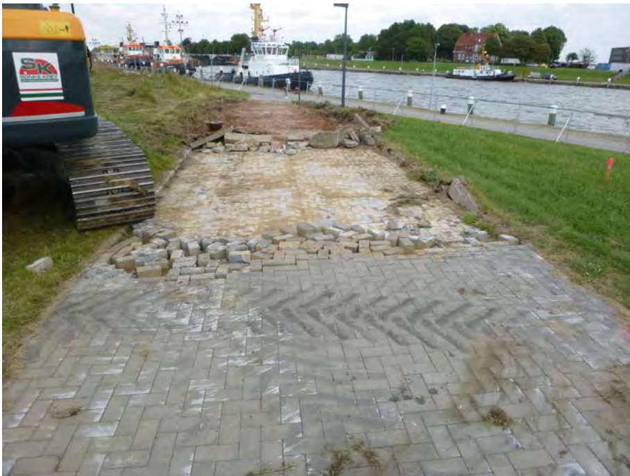
Abb. 9 Die Rampe von der Nordkaje zur VKZ-Elbe muss der Probefläche für die Düsenstrahlpfähle weichen und wird aufgenommen ...
