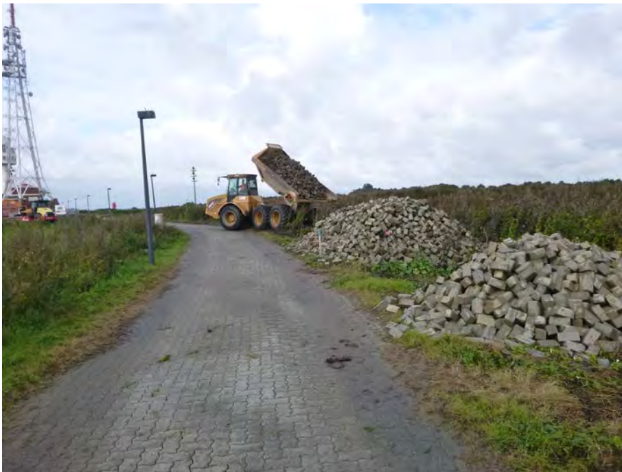
Abb. 11 Die aufgenommenen Pflastersteine werden separat gelagert.
