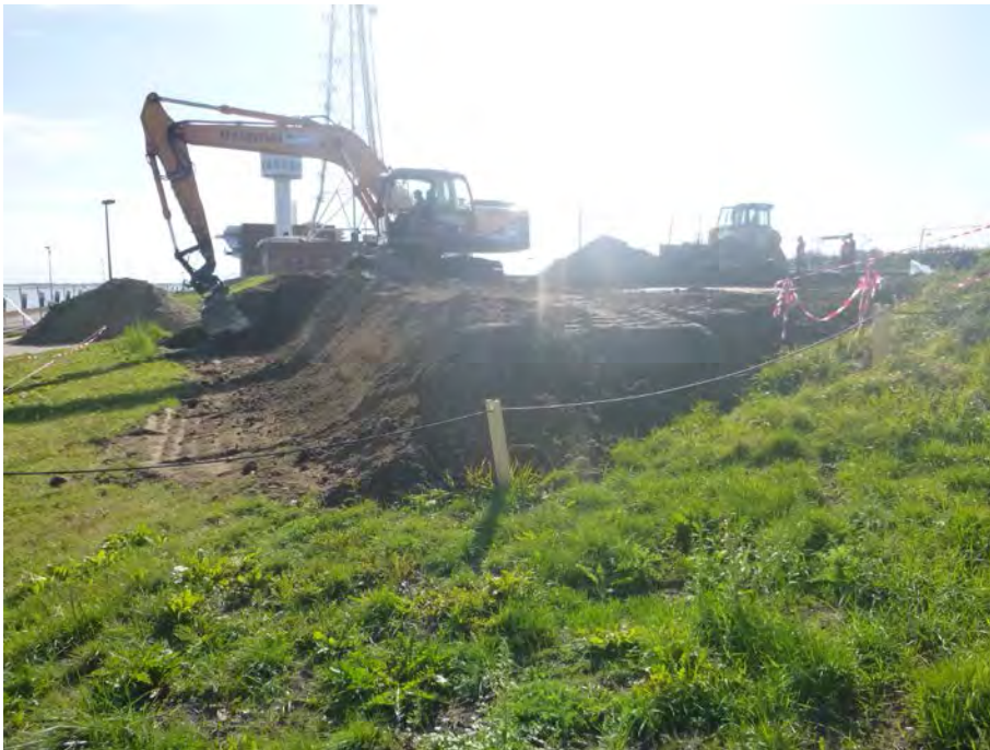
Abb. 13 Die Arbeitsebene der Probefläche Ost wird profiliert ...
