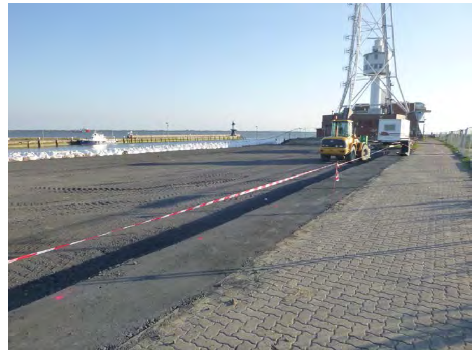
Abb. 18 Endgültiges Planum der Pfahlprobefläche Ost ist hergerichtet.
