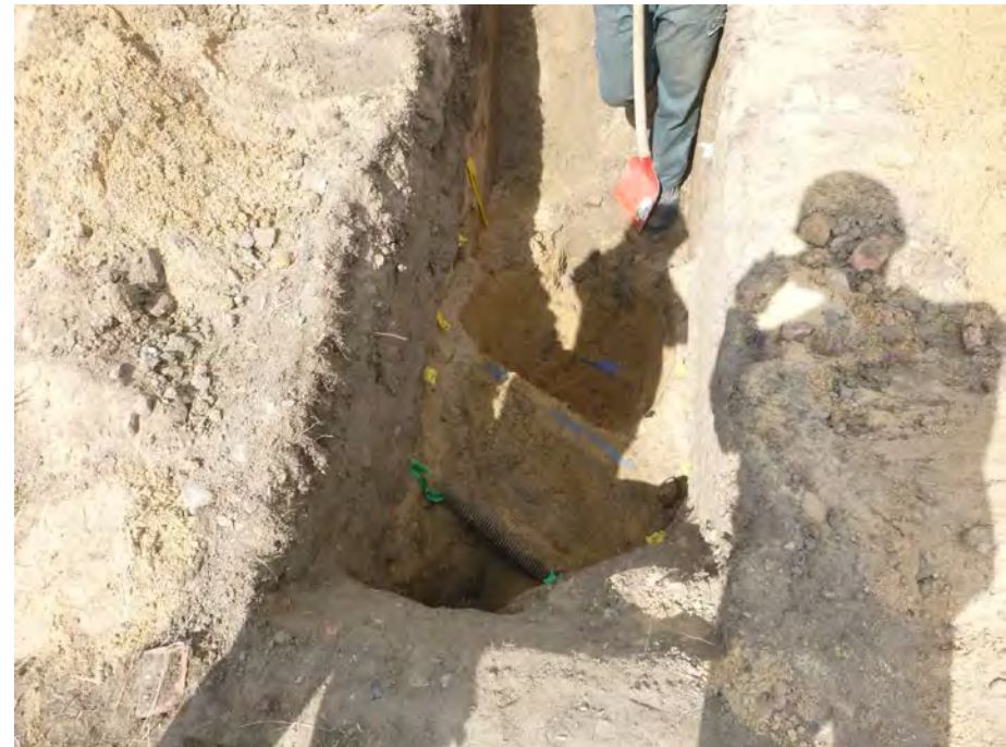
Abb. 7 und 8 Aktive Leitungen werden vermessen und gesichert.
