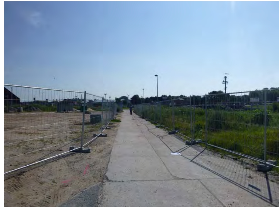
Abb. 2 Die Baufelder werden umfangreich erschlossen und gesichert.
