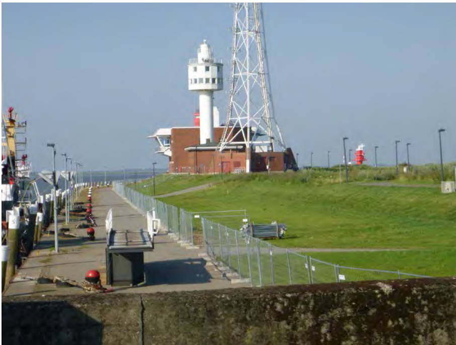
Abb. 3 Bauzaun entlang der Nordkaje, im Baufeld, west- und östlich der VKZ-Elbe, werden als nächstes Pfahlprobeflächen für Probelastungen an Düsenstrahlpfählen und die Beprobung an deren Düskörpern hergerichtet.
