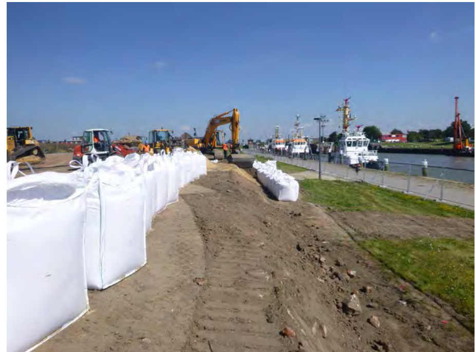
Abb. 14 ... und mit einem temporären Hochwasserschutz gesichert.
