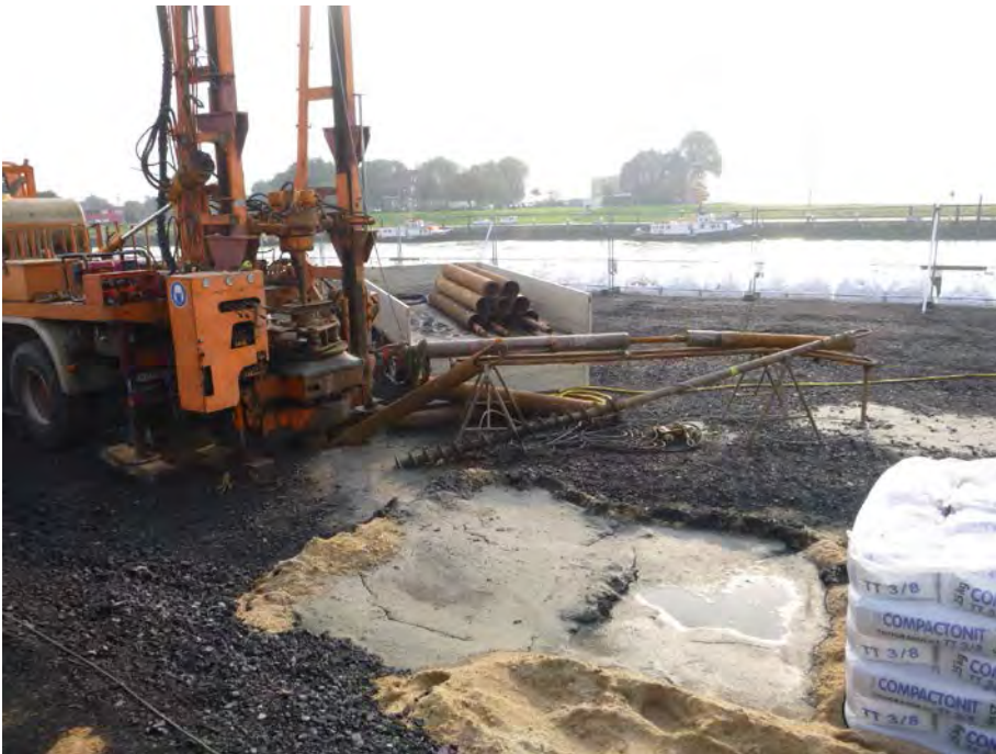
Abb. 26 Der Bereich der Pfahlprobeflächen wird durch Bohrungen überprüft.
