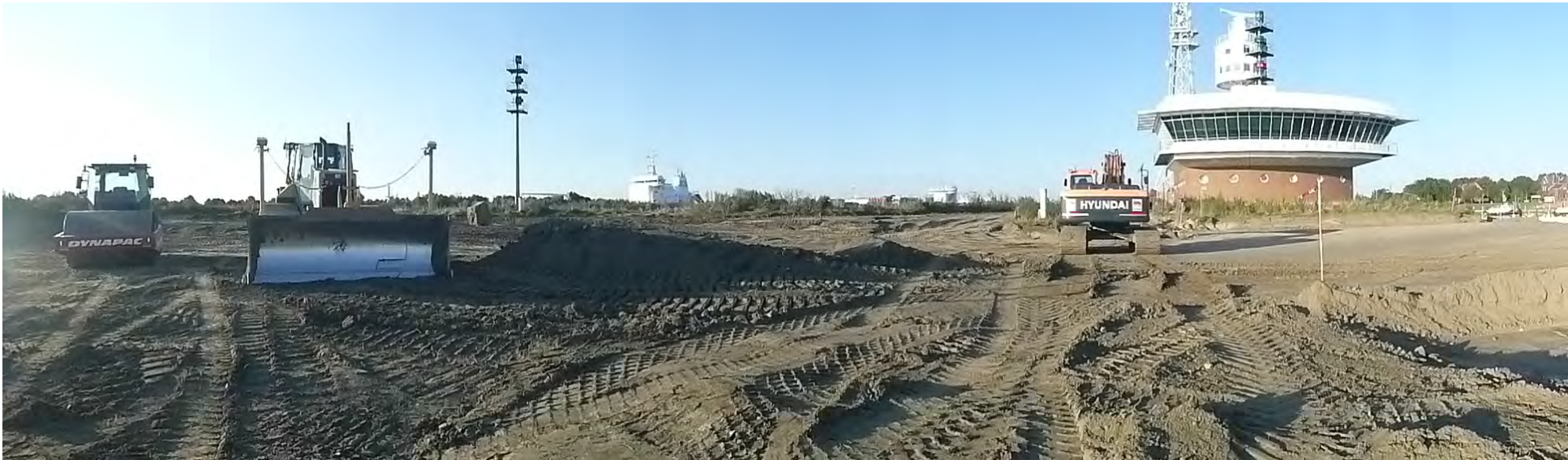
Abb. 19 Auch elbseitig der VKZ-Elbe finden umfangreiche Erdarbeiten statt. Hier entsteht die Pfahlprobefläche West für die Düsenstrahlpfähle, sowie ein Schlammbecken und eine Bereitstellungsfläche für Oberboden der Schleuseninsel.
