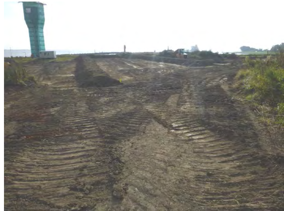
Abb. 21 Diese Profilierung dient als Schlammbecken, in dem Aushubmassen des Teiches, nördlich der VKZ-Elbe, gelagert und entwässert werden.
