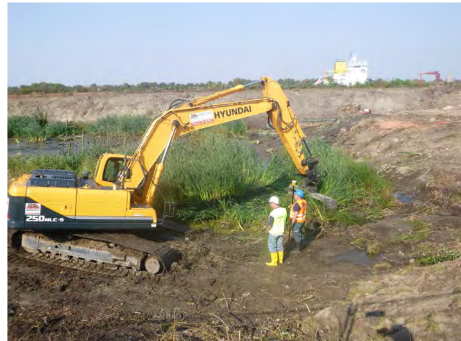
Abb. 23 Mit der Schlammräumung wird begonnen.
