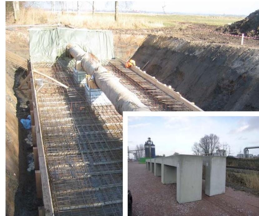
**Abb. 14** Dazu wird eine Bodenplatte betoniert, auf der später U-Profile als Betonfertigteile zum Schutz der Leitung montiert werden.
