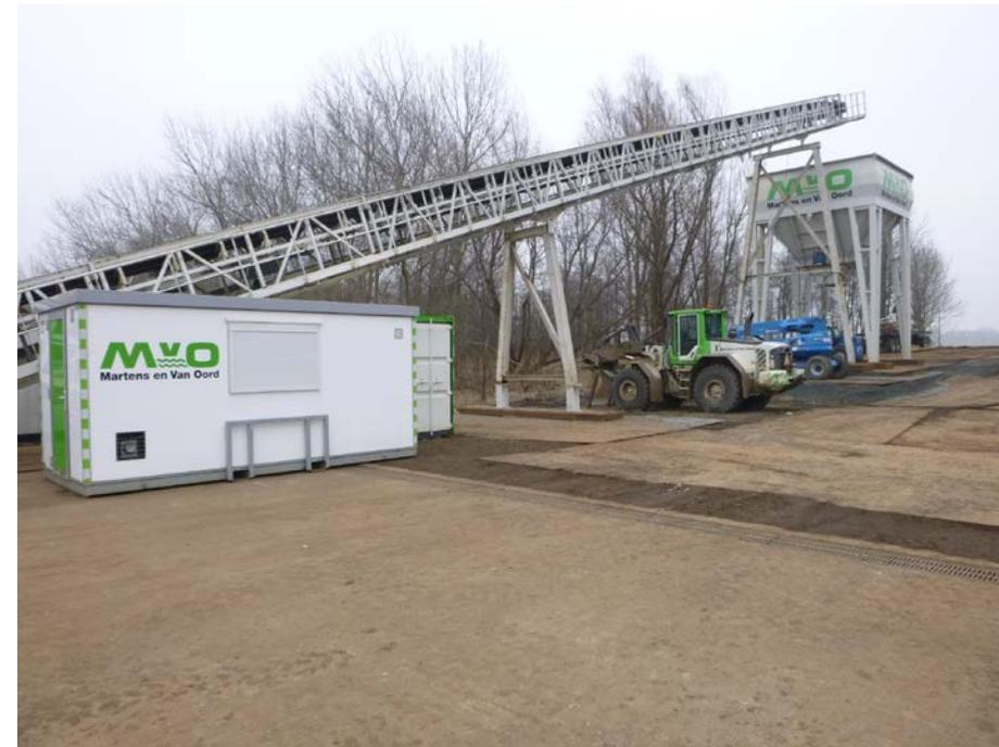
**Abb. 16** Diese Förderanlage dient dem Umschlag von Sand, der über den Wasserweg antransportiert wird. Der Sand wird zunächst für die Herstellung einer Infrastruktur aus Baustraßen, Drainschicht etc. benötigt.
