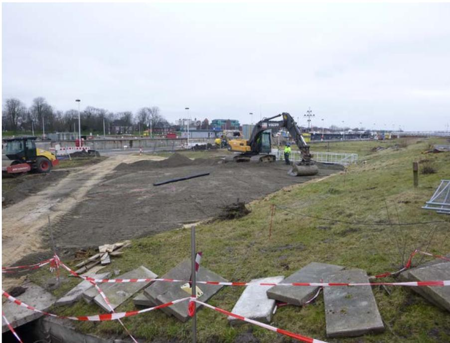
**Abb. 9** Zwischen den Torkammern 5 und 6 wird eine Fläche für eine Wasserbehandlungsanlage (WBA) hergerichtet. Während der gesamten Bauzeit ist es notwendig, verunreinigtes Wasser aufzubereiten.
