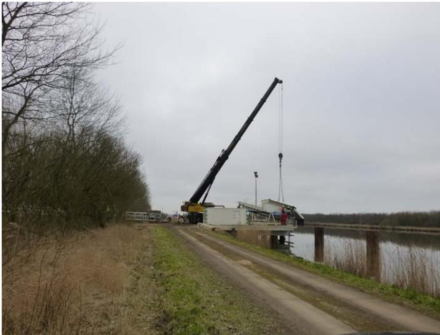
**Abb. 15** Am Anleger Dyhrrsenmoor wird eine Förderanlage zum Beschicken des Bodenlagers aufgebaut.
