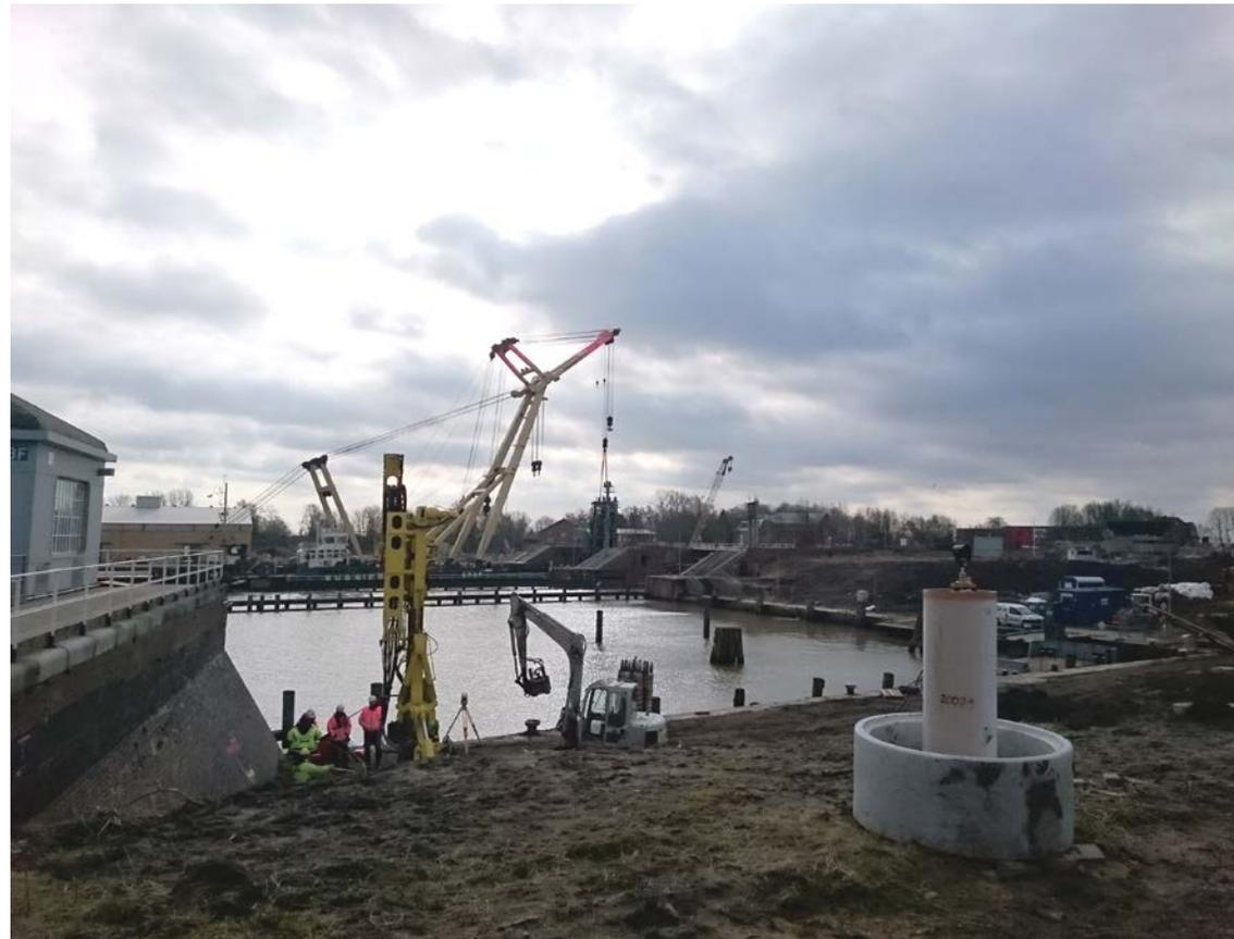
**Abb. 11** Die genaue Lage einer alten Holzspundwand der Großen Schleuse an der Torkammer 6 wird mittels Tastbohrungen erkundet.
