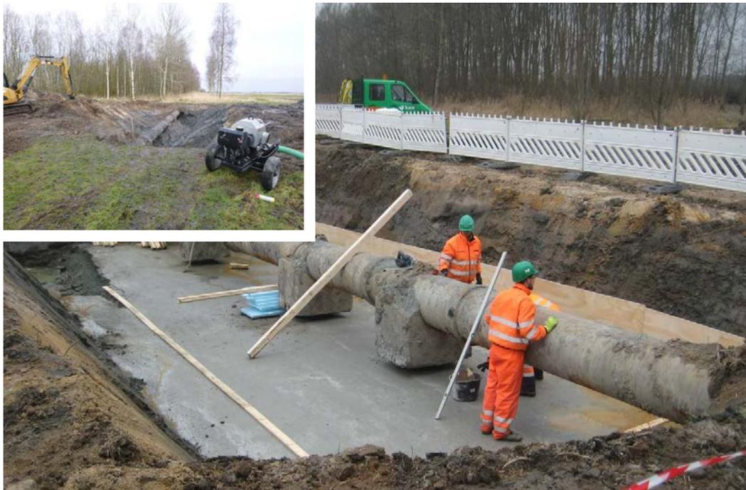
**Abb. 13** Im Bereich des Windschutzstreifens verläuft parallel zum NOK eine auf Stahlbetonpfählen tiefgegründete Wasserversorgungsleitung unter der Erde. Zum Schutz dieser Leitung werden für die kreuzenden Baustraßen Überfahrten hergestellt.
