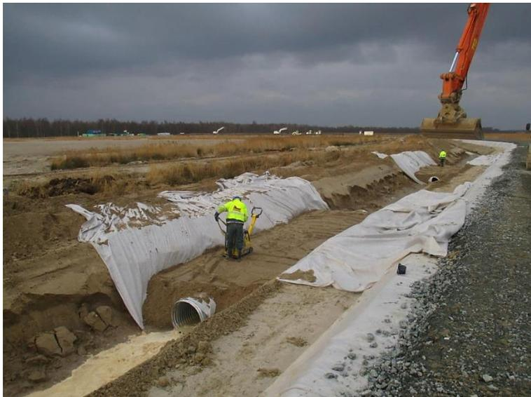
Um das Bodenlager befahren zu können, wird hier in einem umlaufenden Entwässerungsgraben eine Überfahrt-Möglichkeit geschaffen. Damit der Entwässerungsgraben in seiner Funktion nicht beeinträchtigt wird, werden an den Überfahrten Rohrdurchlässe eingebaut.
