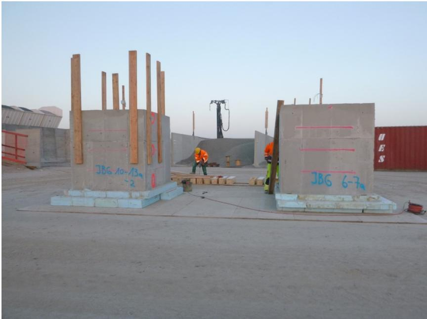
Für die verschiedenen Bauteile der Baumaßnahme werden unterschiedliche Betonrezepturen benötigt. Sie müssen auf ihre Festigkeitseigenschaften überprüft werden. Dafür werden solche massigen Betonblöcke erstellt.
