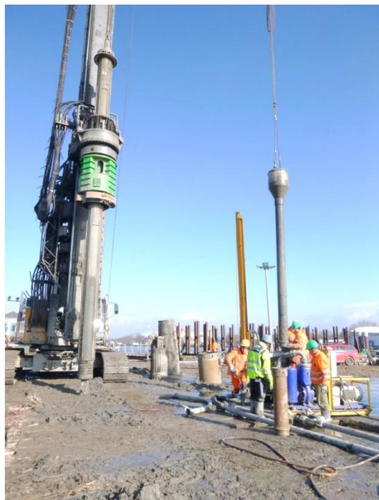
Hinter der nördlichen Kammerwand wurden Bohrpfähle eingebracht. Sie dienen als Gründung für die Abschirmplatte aus Stahlbeton. Dafür wurden zunächst bis zu 30 Meter tiefe verrohrte Bohrungen in den Boden eingebracht. Unter einer Stützung mittels Bentonitsuspension wird der Fuß aufgeweitet. Dann werden Bewehrungskörbe eingestellt und der Bohrpfehl im Kontraktorverfahren ausbetoniert.
