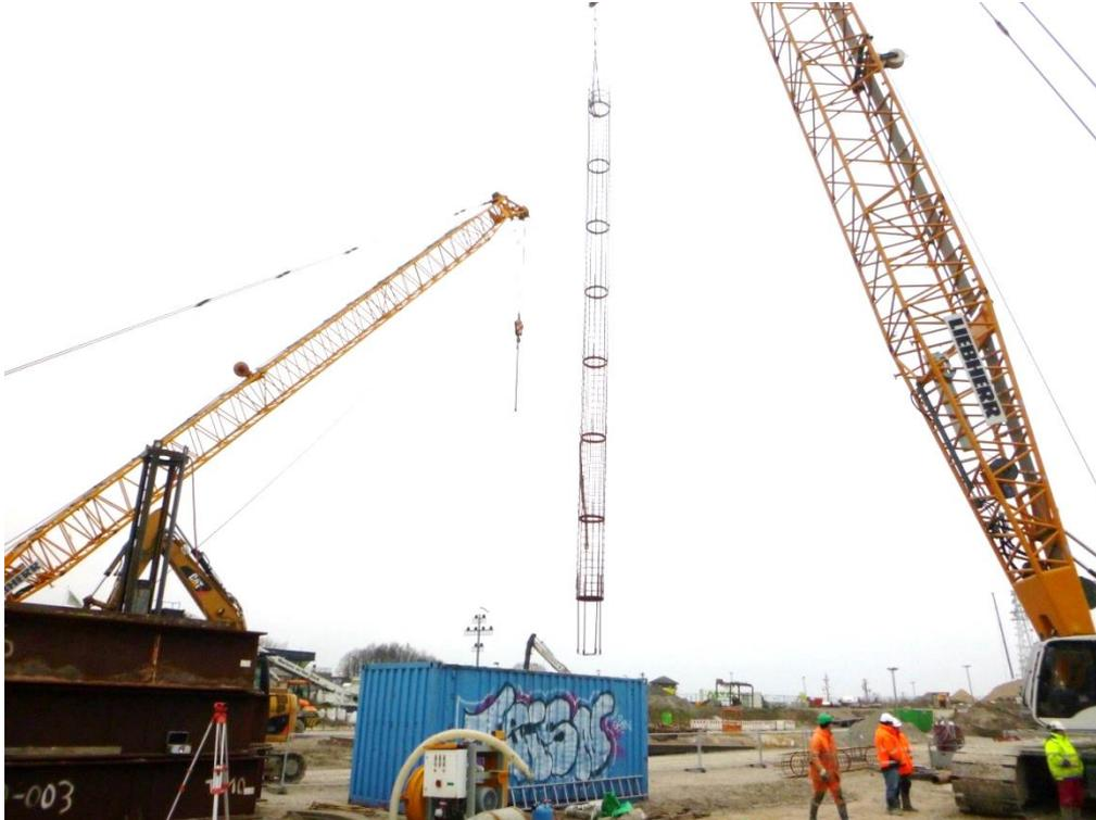
Ein Bewehrungskorb für einen Bohrpfehl wird eingebaut.
