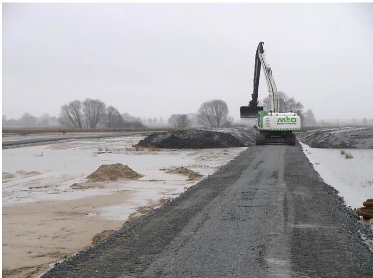
Hier wird angelieferter Aushubboden von der Schleuseninsel im Bodenlager eingebaut.
