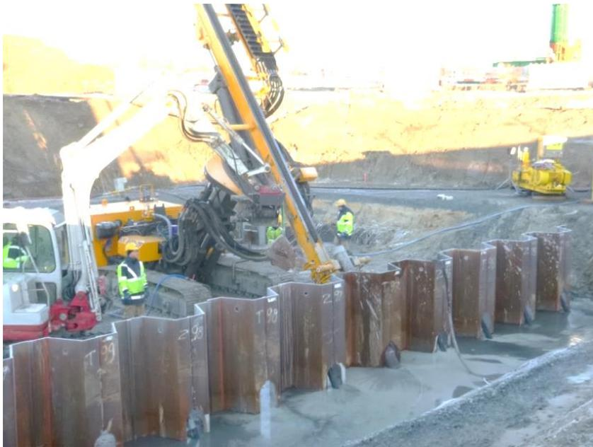
Mit diesem Bohrgerät werden die Bohrungen für die Mikropfähle auf Tiefe gebracht. Anschließend werden die Stahlzuglieder in die Bohrung eingebaut.
