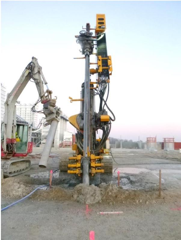
Für die zugbelasteten Düsenstrahlpfähle müssen zur Lastabtragung sogenannte Reaktionspfähle eingebaut werden. Hier werden diese Reaktionspfähle gebohrt.
