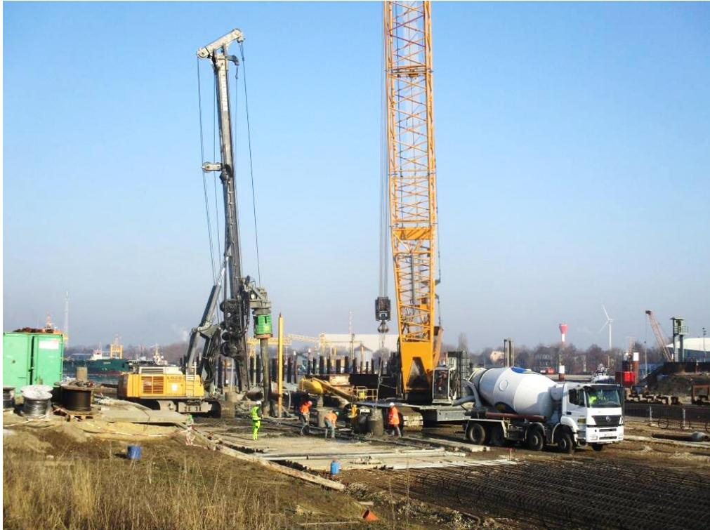
Nachdem der Bewehrungskorb eingebaut ist, erfolgt das Ausbetonieren des Bohrpfels mit Beton bei gleichzeitigem Ziehen der Verrohrung und dem Abpumpen der Betonitsuspension.
