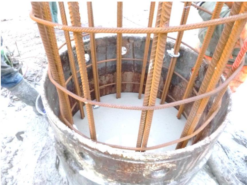
Die Bewehrung wird in die Stützflüssigkeit mit Bentonitsuspension eingestellt.
