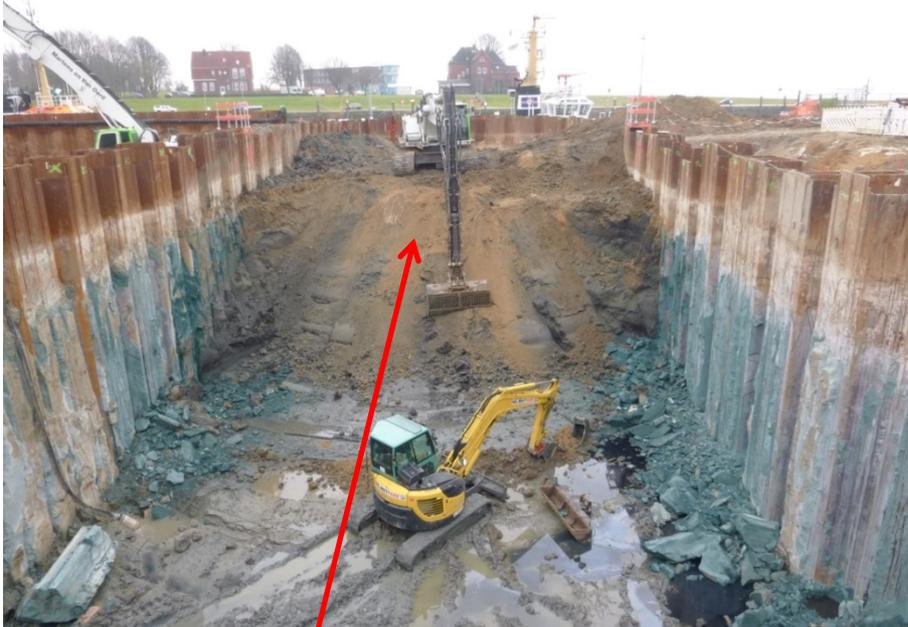
Mit einem sogenannten Langarmtieflöffelbagger wird der Boden ausgehoben. An der Sohle sammelt sich Grundwasser.
