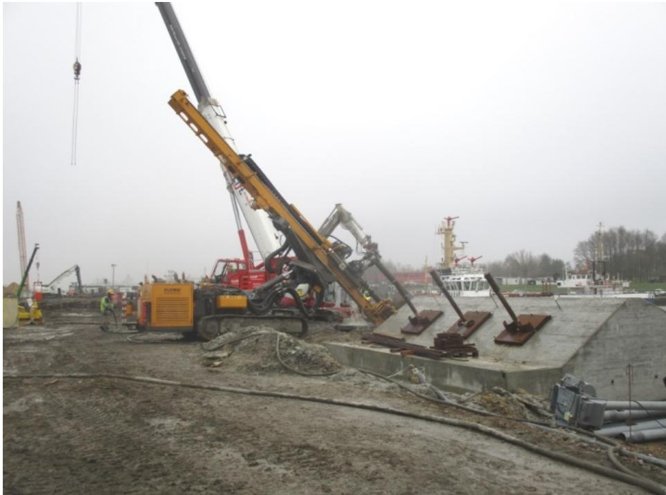
Hier werden weitere Probepfähle auf ihr Tragverhalten mittels statischer Probelastungen untersucht. Dabei werden in der Pfahlgruppe A sowohl Einzelpfähle als auch eine Pfahlgruppe von drei nebeneinander liegenden Düsenstrahlpfählen untersucht. Im Vordergrund die bereits geprüfte Pfahlgruppe B.
