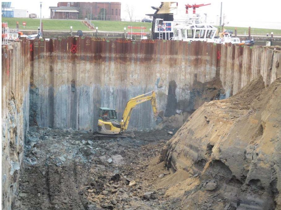
Die Trag- und Füllbohlen der Spundwände werden vom ausgehärteten Zement-Bentonit gereinigt.
