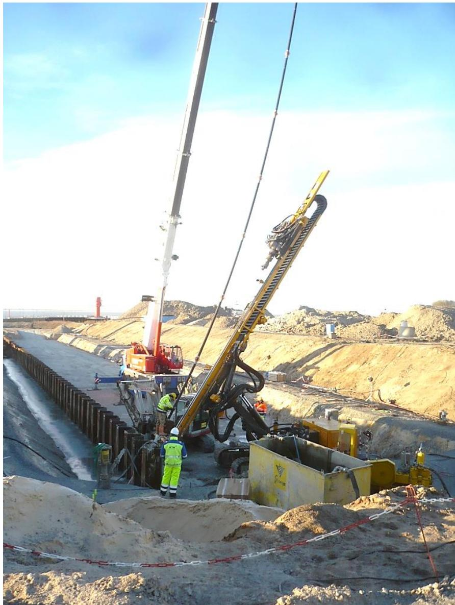
Hier wird das Stahlzuglied mit einem Kran in die Bohrung herab gelassen.
