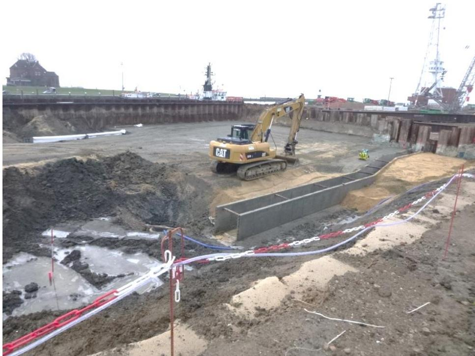
Die ersten Spundbohlen der südlichen Kammerwand wurden an das Außenhaupt angeschlossen. Die Kammerwand wird auch hier als Spundwand ausgebildet, die in einen Schlitz mit Zementbentonitstützung eingestellt wird.
