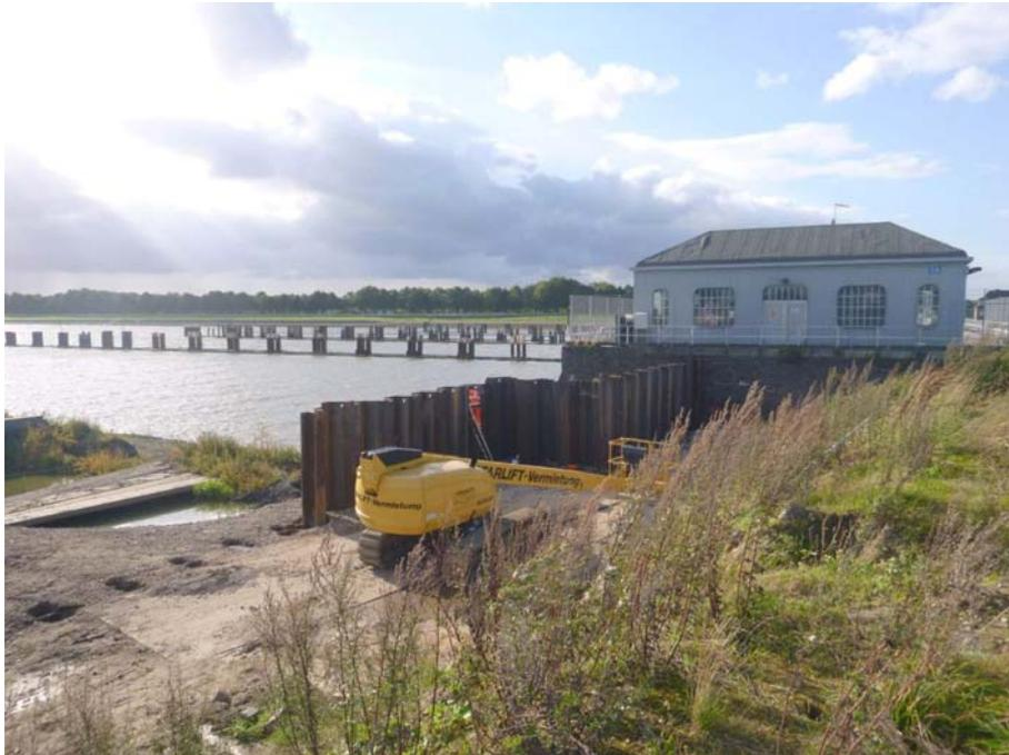
Für die Verlegung der Hochwasserschutzlinie werden Spundbohlen eingebracht.
