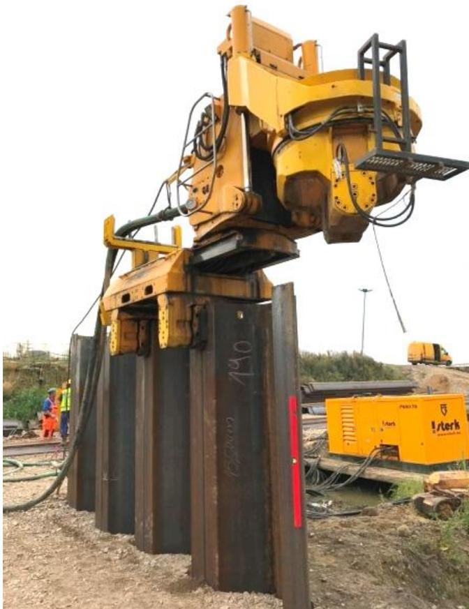
Damit die Torkammer 4 nicht durch Erschütterungen beschädigt wird, werden die Spundbohlen im unmittelbaren Bereich der Torkammer in den Boden gepresst. Weiter entfernt werden die Bohlen mittels eines erschütterungsarmen Vibrationsverfahrens einvibriert.
