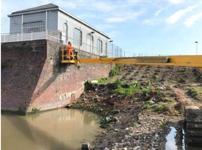
Die Spundwand für den Hochwasserschutz schließt unmittelbar an die Torkammer 4 (Außenhaupt der bestehenden Südkammer Große Schleuse) an. Um mögliche Setzungen und Lageveränderungen beim Einbringen der Spundbohlen sofort zu registrieren, werden an Torkammer 4 Schwingungsmessgeber angebracht.
