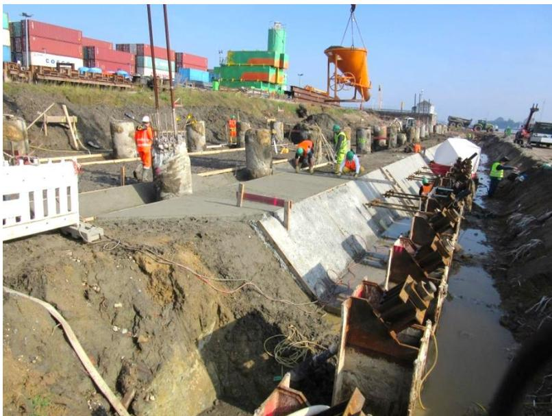
Sauberkeitsschicht zur Profilierung der Stahlbeton-Abschirmplatte
