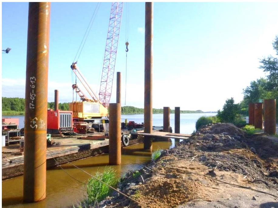
Hier wird die zweite von drei Reihen Stahlpfähle gerammt.
