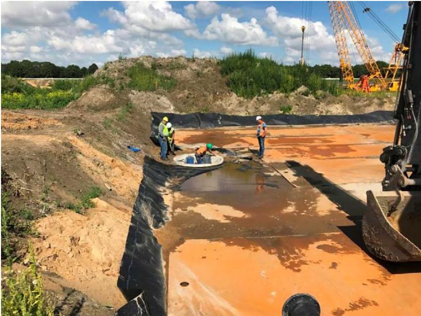
Das Folienabsetzbecken mit Pumpenschacht zur Entwässerung des ausgehobenen Baugrubenschlammes
