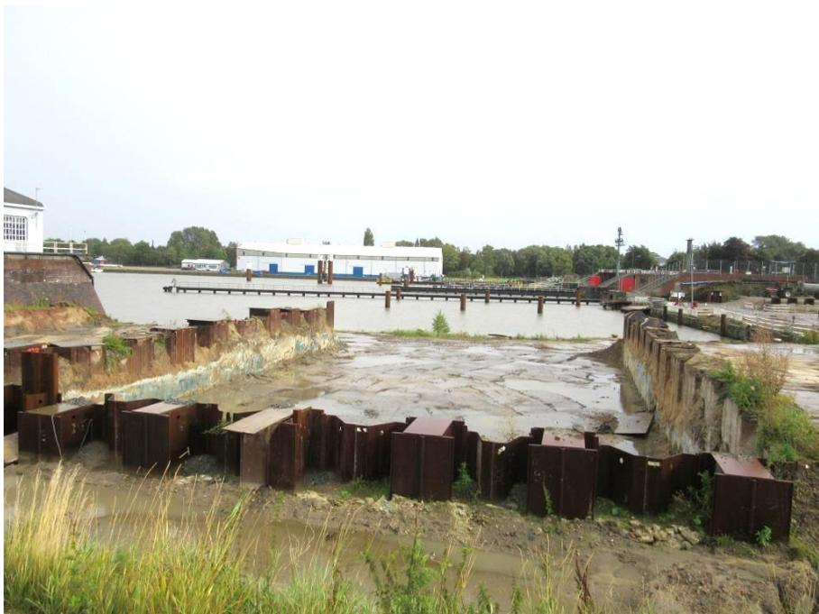
Als Vorbereitung zum Rückbau der alten Uferwand wurde in der Torkammerbaugrube eine sogenannte Entlastungsböschung hergestellt.
