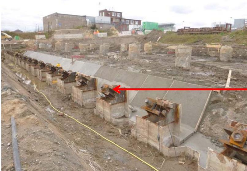
Anschluss der Düsenstrahlpfähle an die Spundwand: Diese Anschlusskonstruktion wird bei der Erstellung der Abschirmplatten mit einbetoniert.
