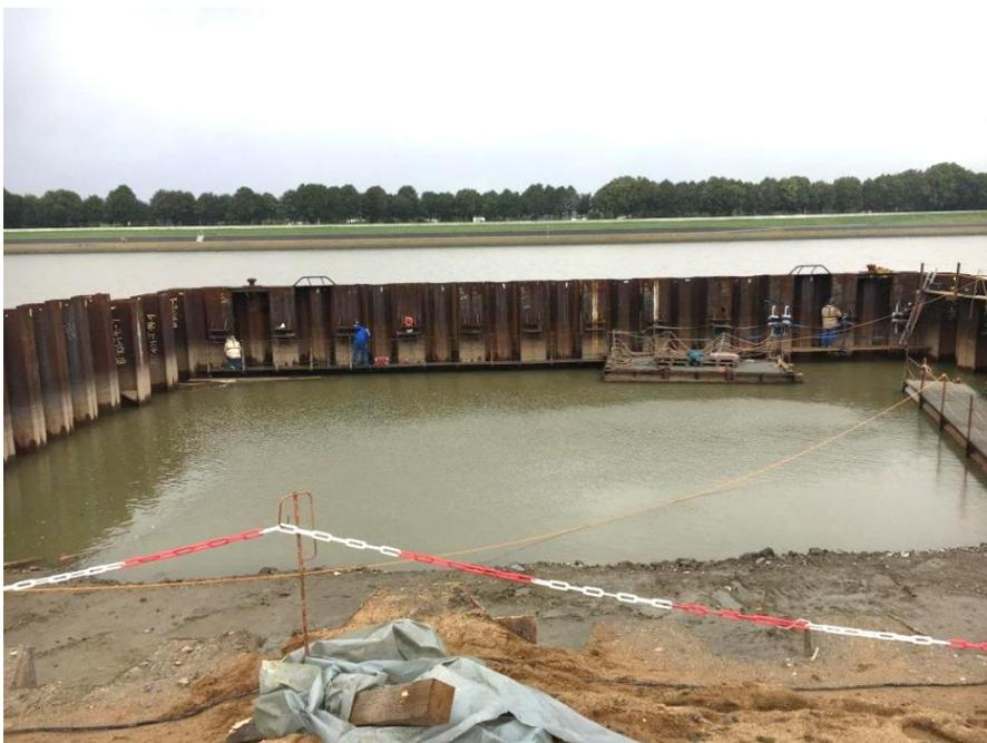
Hier finden Schweißarbeiten am Spundwandkasten zur Aufnahme der Verankerung statt. Nach dem Einbau der Horizontalanker kann die Verfüllung des Anlegers mit Sand erfolgen.
