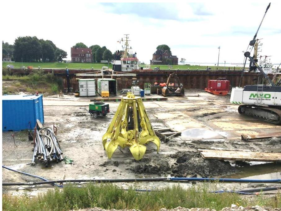
Gelöste Suspensionsreste, die beim Säubern der Spundwand auf die Sohle der Baugrube gefallen sind, werden mit einem Polypgreifer ausgehoben.
