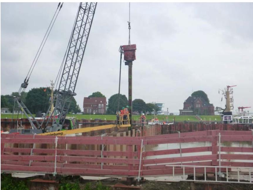
Reinigen der oberen Spundwand mit einem Hobel
