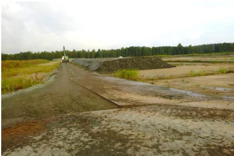
Im Bodenlager Süd wird weiterhin der Aushubboden von der Schleuseninsel und aus der Böschung vom Bau des zweiten Anlegers in Dyhrssenmoor eingebaut. Der Boden breiiger Konsistenz wird dabei zur Entwässerung in Mieten aufgesetzt.
