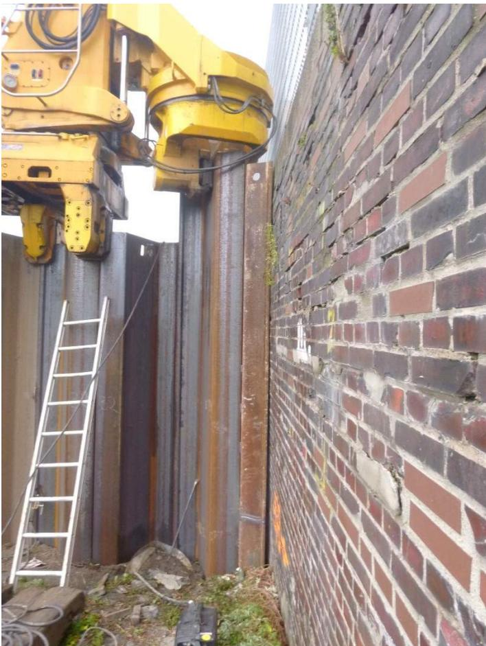
Anschluss der Hochwasser-Spundwand an Torkammer 4
