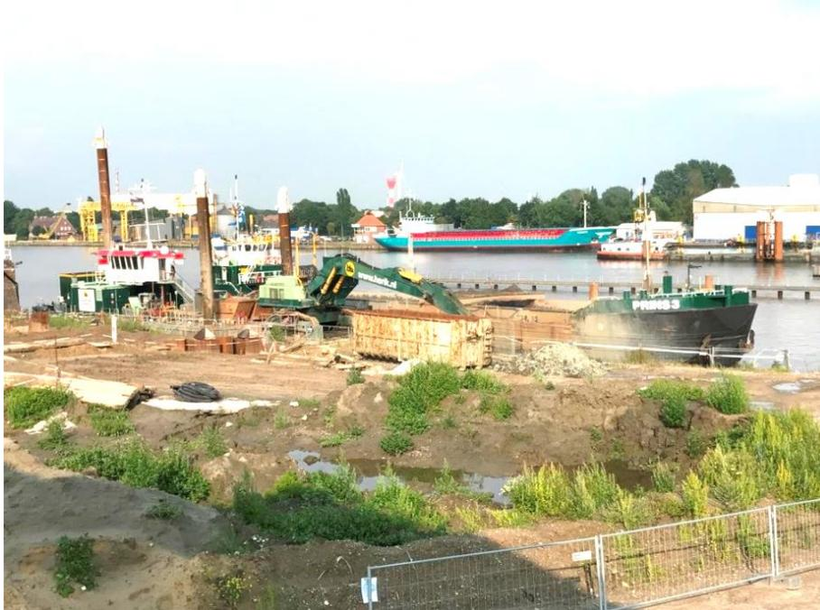
Hier wird die alte Spundwand mittels Nassbaggerarbeiten entfernt.
