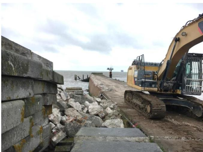
Auch Molenausüstung und Stahlbetonbrüstung sind entfernt.
