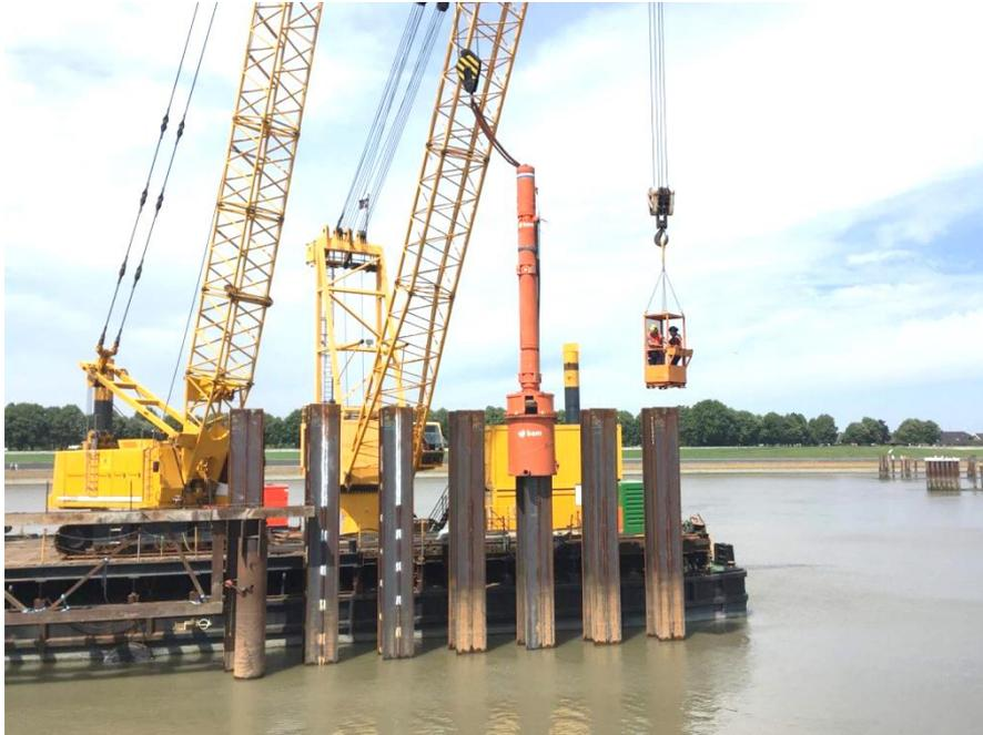
Hier werden die Tragbohlen frei reitend in die vorher ausgeführte Austauschbohrung gerammt, d.h., der Hammer wird auf die Bohlen „aufgesetzt“ und schlägt sie ein. Im Gegensatz zu diesem Verfahren wird beim mäklergeführten Rammen der Hammer direkt am Kran geführt.
