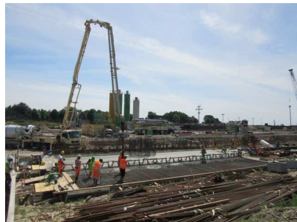
Das linke Foto zeigt das Verlegen der Bewehrung für die Abschirmplatte im Block 15 der nördlichen Kammerwand. Im rechten Bild ist das Betonieren derselben Platte zu sehen.
