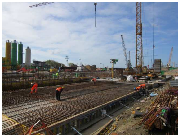
Das linke Foto zeigt das Verlegen der Bewehrung für die Abschirmplatte im Block 15 der nördlichen Kammerwand. Im rechten Bild ist das Betonieren derselben Platte zu sehen.
