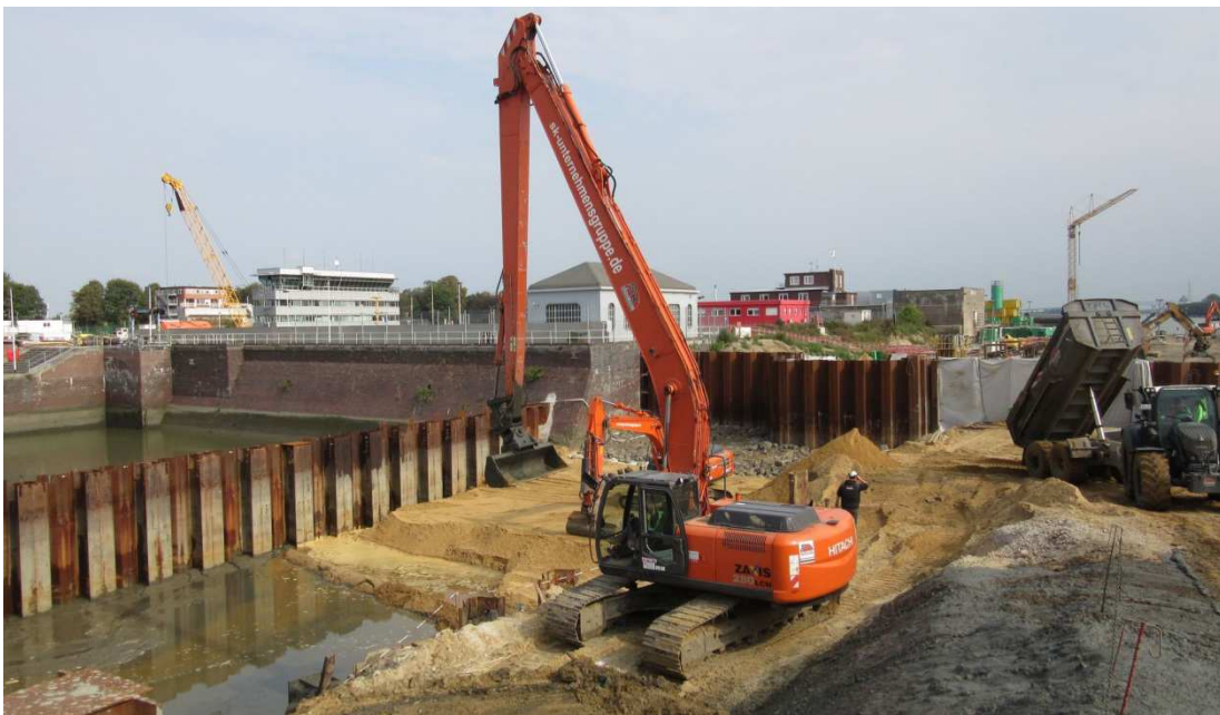
Der Spundwandkasten aus Trag- und Füllbohlen bekommt eine Sandfüllung. Links im Hintergrund ist der Leitstand der Großen Schleusen zu erkennen.
