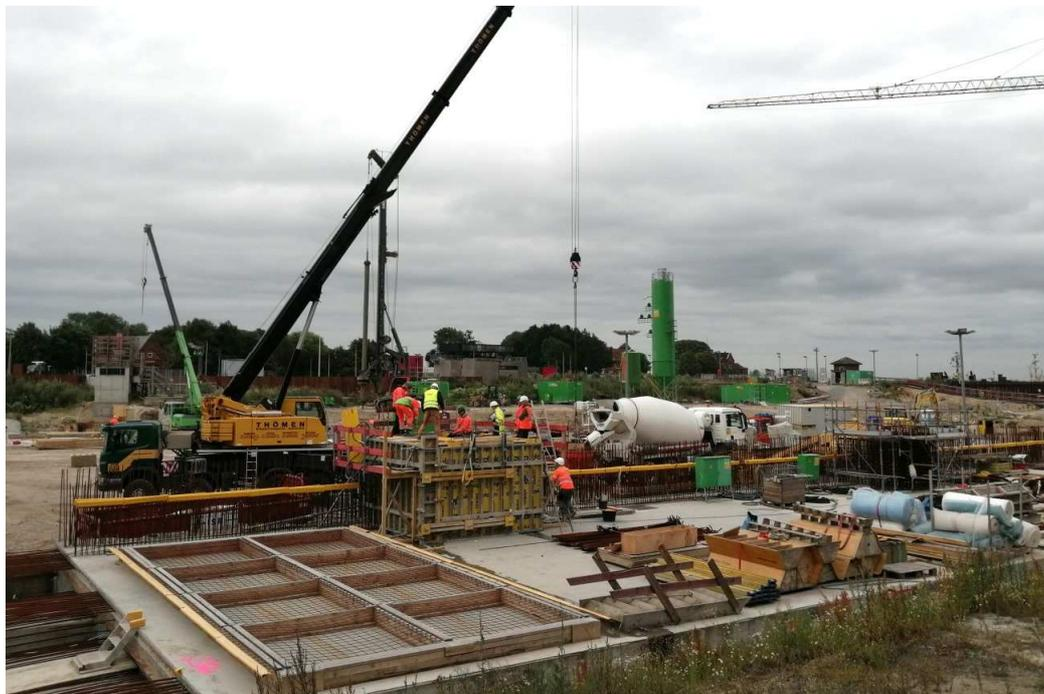
*Betonage eines Pollerfundaments auf einer fertiggestellten Abschirmplatte.*
