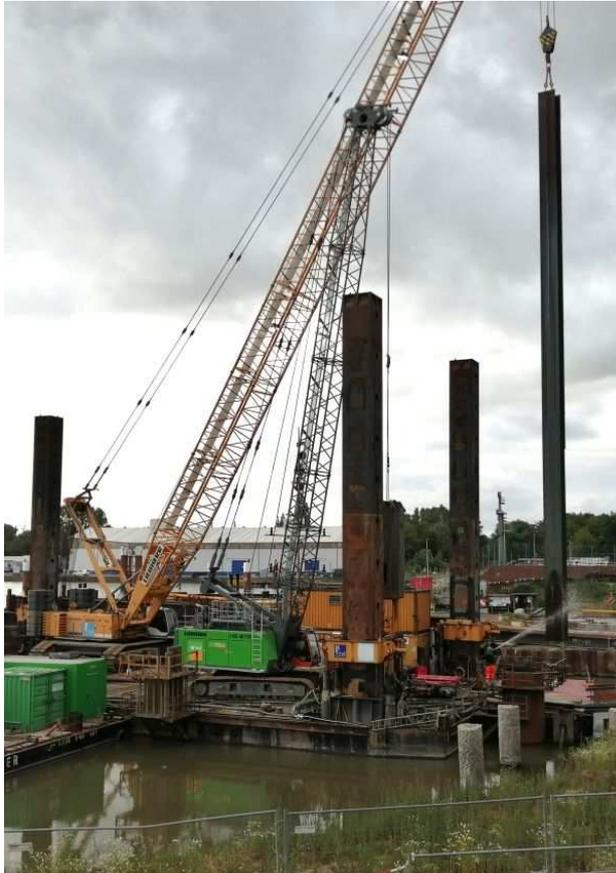
Am Binnenhaupt laufen die Arbeiten zur Fertigstellung der Baugrubenumschließung für die Torkammer. Die erforderliche Spundwand wird kombiniert aus Trag- und Füllbohlen eingebracht. Im kommenden Jahr soll die Baugrube zunächst mit einer Unterwasserbetonsohle versehen und anschließend schrittweise gelenzt werden. Analog zum Außenhaupt ist dafür eine mehrlagige Aussteifung vorgesehen.
