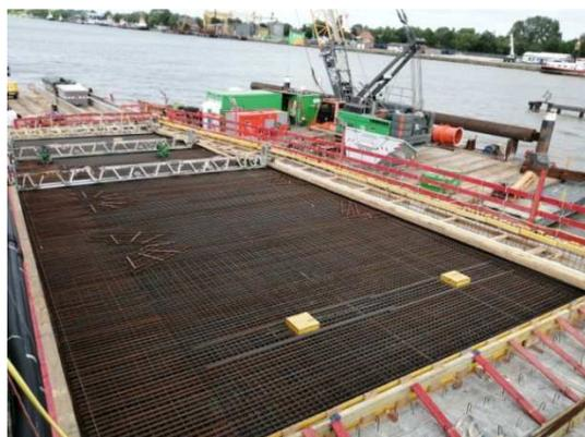
*...die als Untergrund für die folgenden Arbeiten diene. Im rechten Bild ist bereits die Bewehrung aus Armieisen zu erkennen,...*
