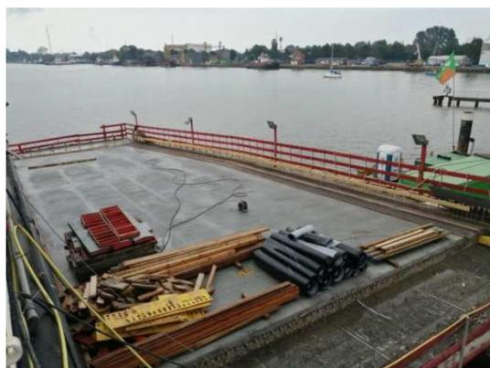
*...die dem Betonbelag eine erhöhte Tragfähigkeit verleiht. Links im Bild die Betonage, rechts der fertig betonierte erste Abschnitt.*
