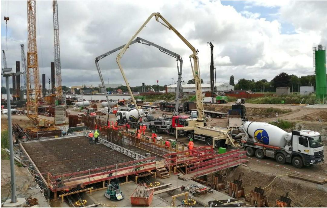
*Mit zwei Pumpen wird der Beton für eine Abschirmplatte der nördlichen Kammerwand bereitgestellt. Mittig ragt das Stahlgerüst eines Pollerfundaments aus der Platte heraus.*
