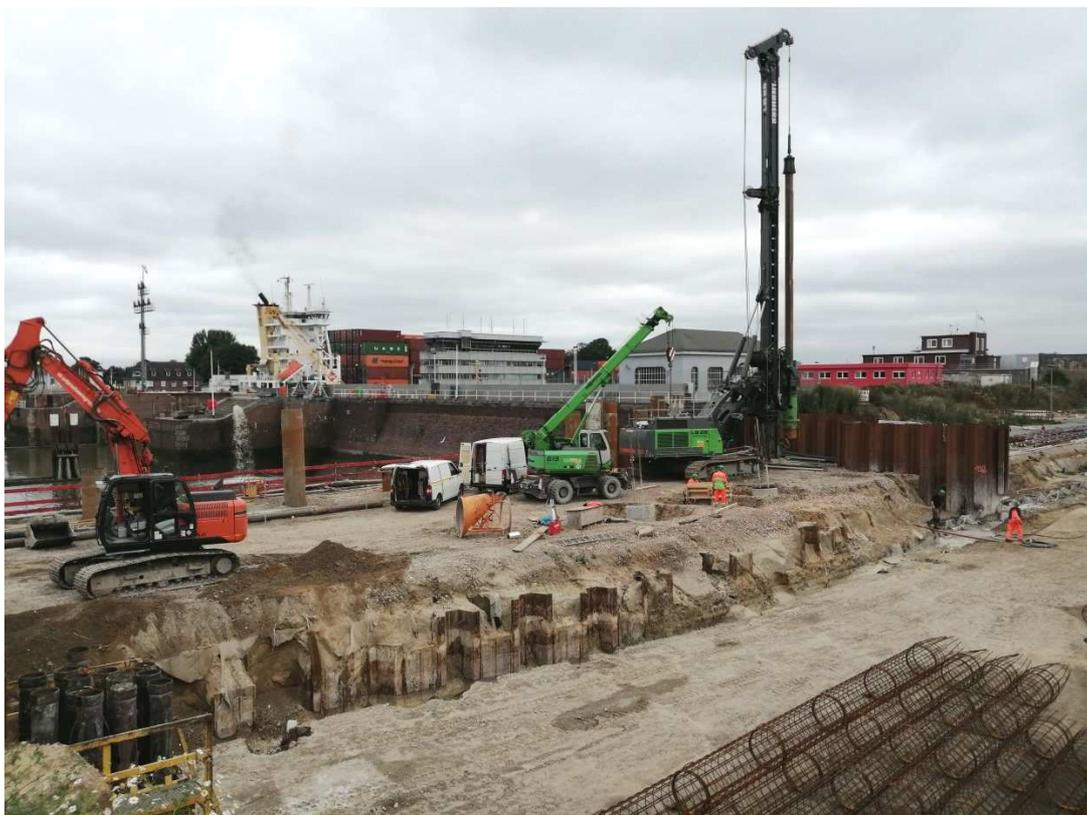
*Mit schwerem Gerät bringen Arbeiter die ersten Bohrpfähle in den Grund des Verbindungsbauwerks ein. Im Vordergrund ist der Kopf der nördlichen Kammer-Spundwand zu erkennen, im Hintergrund läuft der Schiffsverkehr durch die große Schleuse. Vorn rechts liegen Bewehrungskörbe für die Bohrpfähle bereit.*
