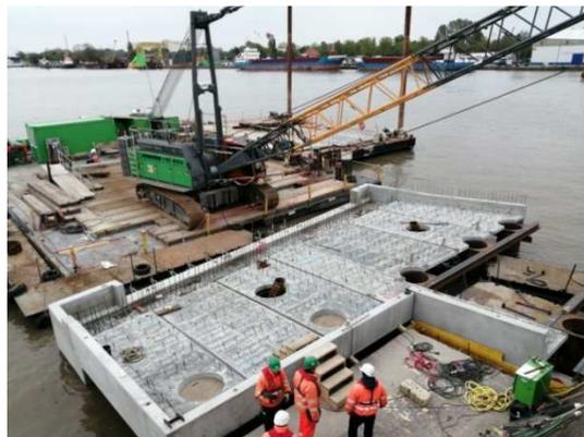
*Schritt für Schritt zum Fähranleger: Nach dem Einbringen der senkrechten Gründungspfähle und dem Aufbau des stählernen Traggerüsts (linkes Bild) wurde im ersten Teilabschnitt eine Bodenplatte aus Betonfertigteilen verlegt...*
