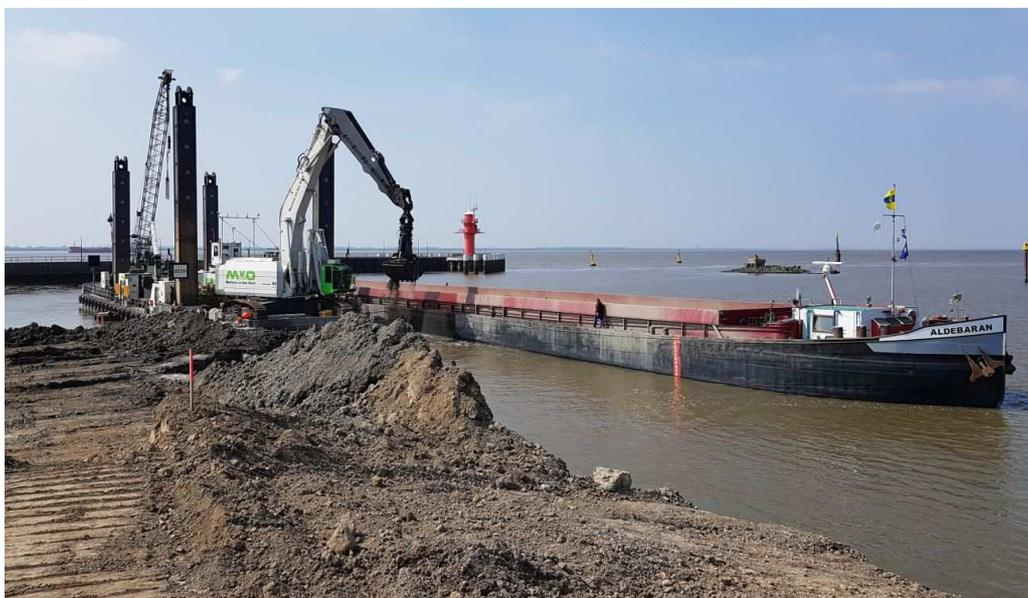
*Der Trockenaushub von der Schleuseninsel wird auf ein Binnenschiff verladen und zum Bodenlager Dyhrssenmoor gebracht.*
