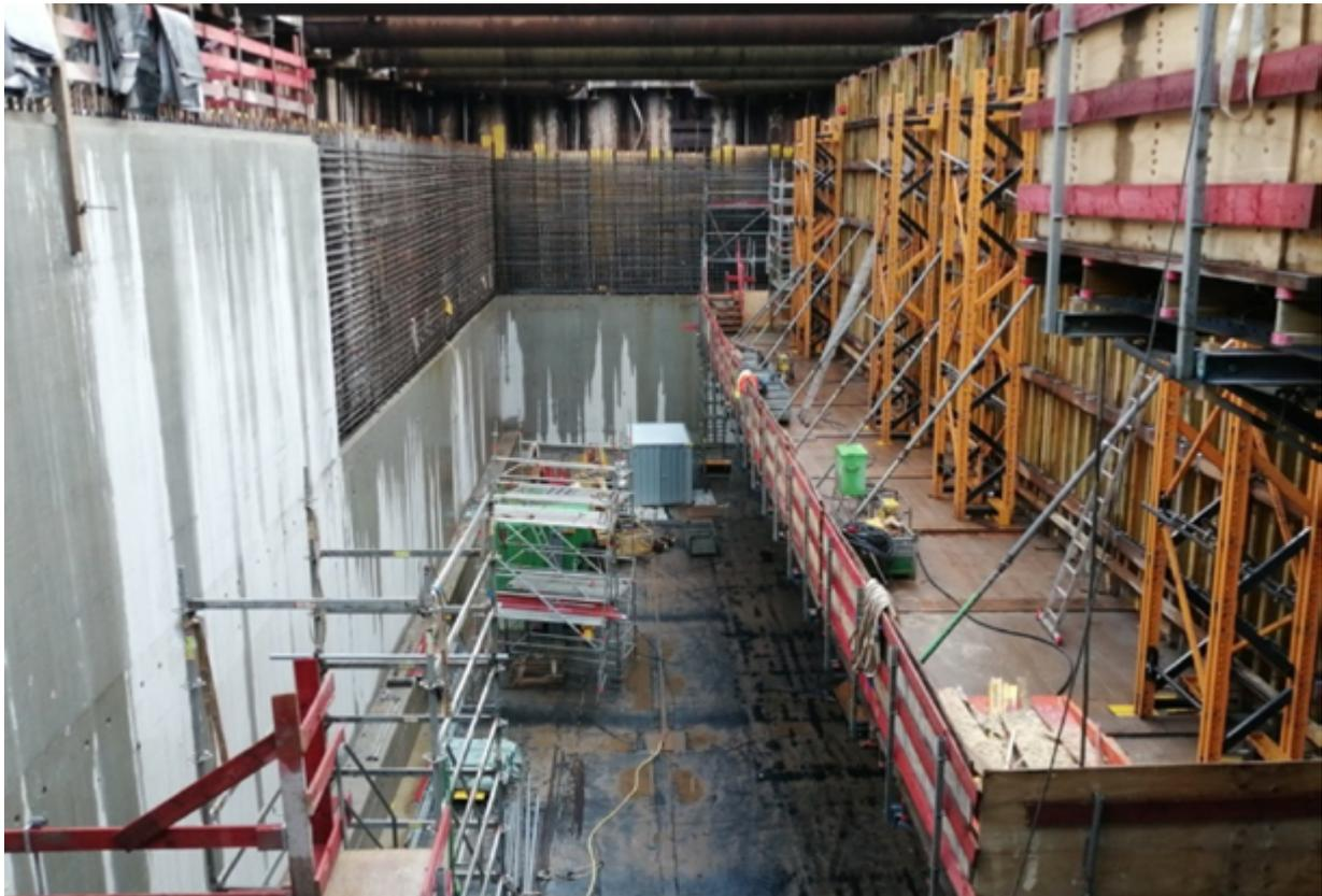
*Die Arbeiten im zweiten Wandabschnitt gehen zügig voran. Ein Abschnitt nach dem anderen wird bewehrt, eingeschalt und anschließend ausbetoniert. Ist der Beton ausreichend erhärtet kann die hier in Gelb erkennbare Schalung im nächsten Betonierabschnitt erneut zum Einsatz kommen.*
