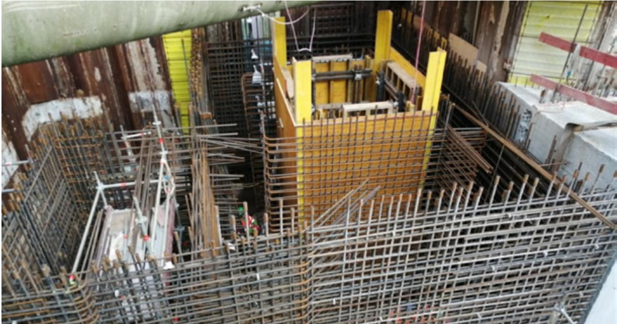
*Einbau der Bewehrung in einem der über Eck liegenden Betonierabschnitte der Torkammer. Die in Gelb erkennbare Holzschalung umschließt eine Öffnung im Beton, in der später ein Treppenturm eingebaut wird. Dieser führt bis unter den Drempel des Außenhauptes, in dem Versorgungsleitungen die Schleusenammer queren.*
