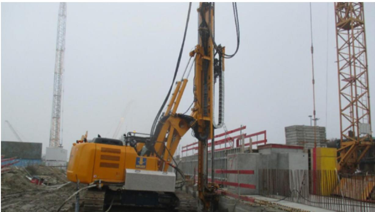
*Bevor der Bodenaushub beginnt, werden die angrenzenden Spundwände der Schleusenammer mit einem Spezialgerät per Wasserstrahl mit hohem Druck unterirdisch (-4 bis -15 m NHN) gesäubert und so unter anderem von Betonresten befreit. Im Hintergrund ist ein Pollerfundament sowie ein Abschnitt der Einstauwand zu sehen.*
