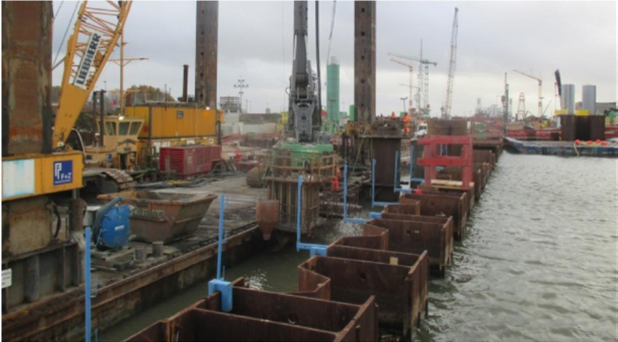
*Von der Hubinsel „Annegret“ aus werden die Tragbohlen im Mantelrohrverfahren eingebaut. Im Verbund mit den Zwischenbohlen stellen sie den äußeren Teil der Umschließung der Baugrube dar. Später werden nochmals gegenüberliegend Füllbohlen eingebaut und der Zwischenraum mit Beton verfüllt.*
