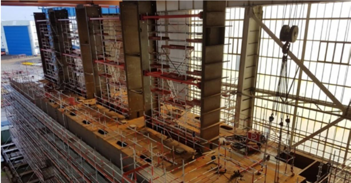
*Das dritte Schleusentor wird in der Werft in Emden gerade zusammengebaut. Die imposanten Schüttschächte ragen aus der bereits fertiggestellten unteren Torconstruction heraus. In ihnen werden später die Füllschütze zur Regulierung des Wasserstandes in der Schleusenammer auf und ab bewegt.*
