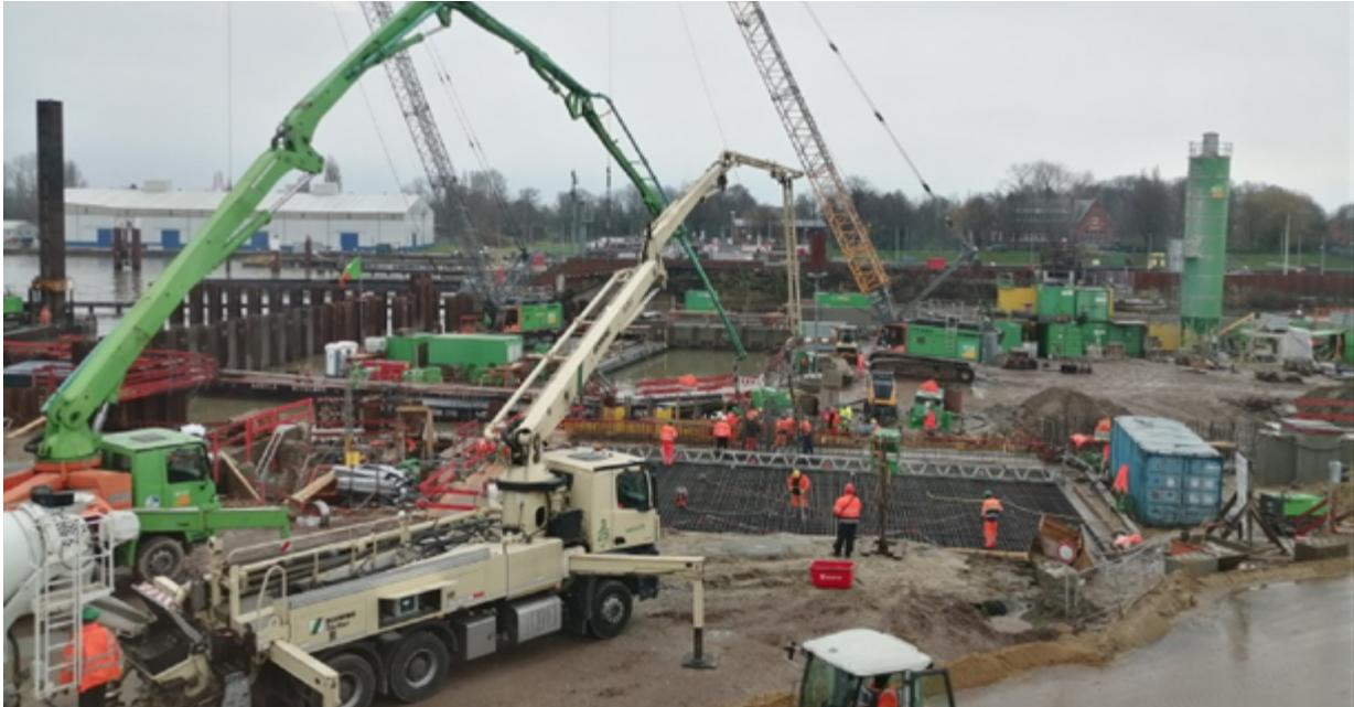
*Betonage der an das Binnenhaupt angrenzenden Abschirmplatte der nördlichen Kammerwand. Mithilfe von Betonpumpen wird der flüssige Beton an den jeweiligen Einbauort befördert.*
