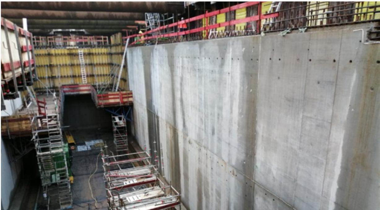
*Blick in die Torkammer des Außenhauptes: Es sind die beiden fertiggestellten Wandabschnitte zu sehen. Oben im Anschnitt die erste Gurt- und Steifenlage, die ausgebaut werden muss, bevor die Schalungs- und Bewehrungsarbeiten des dritten Wandabschnitts beginnen können.*
