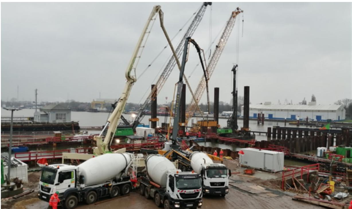
Fast acht Stunden dauert es, bis die etwa 600 m<sup>3</sup> Beton als Ausgleichsschicht mit Hilfe von Tauchern unter Wasser einbaut sind. Eine logistische Herausforderung für alle Beteiligten auf der Baustelle.
