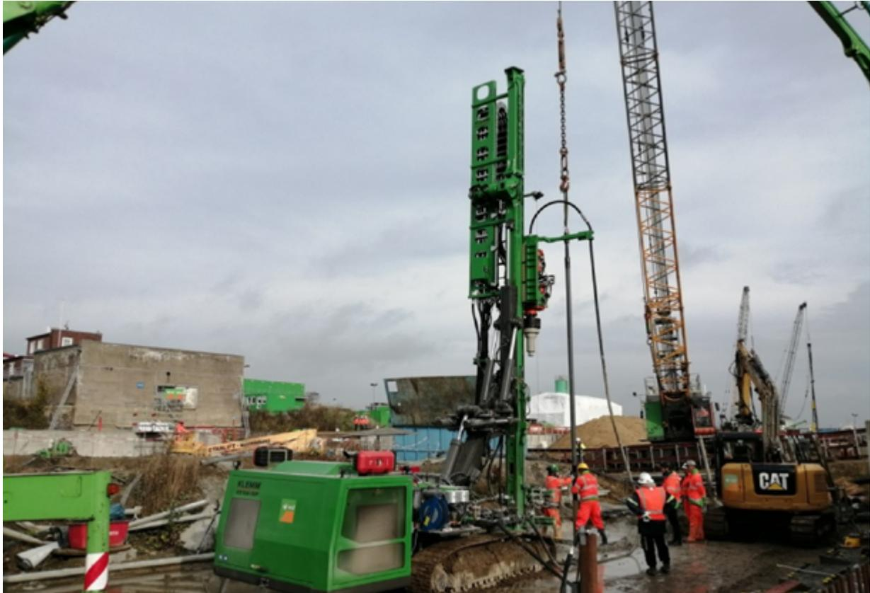
*Zur Vorbereitung der Sohlsicherung werden bereits Probe-Auftriebspfähle hergestellt, deren Tragverhalten durch Probelastungen überprüft wird.*
