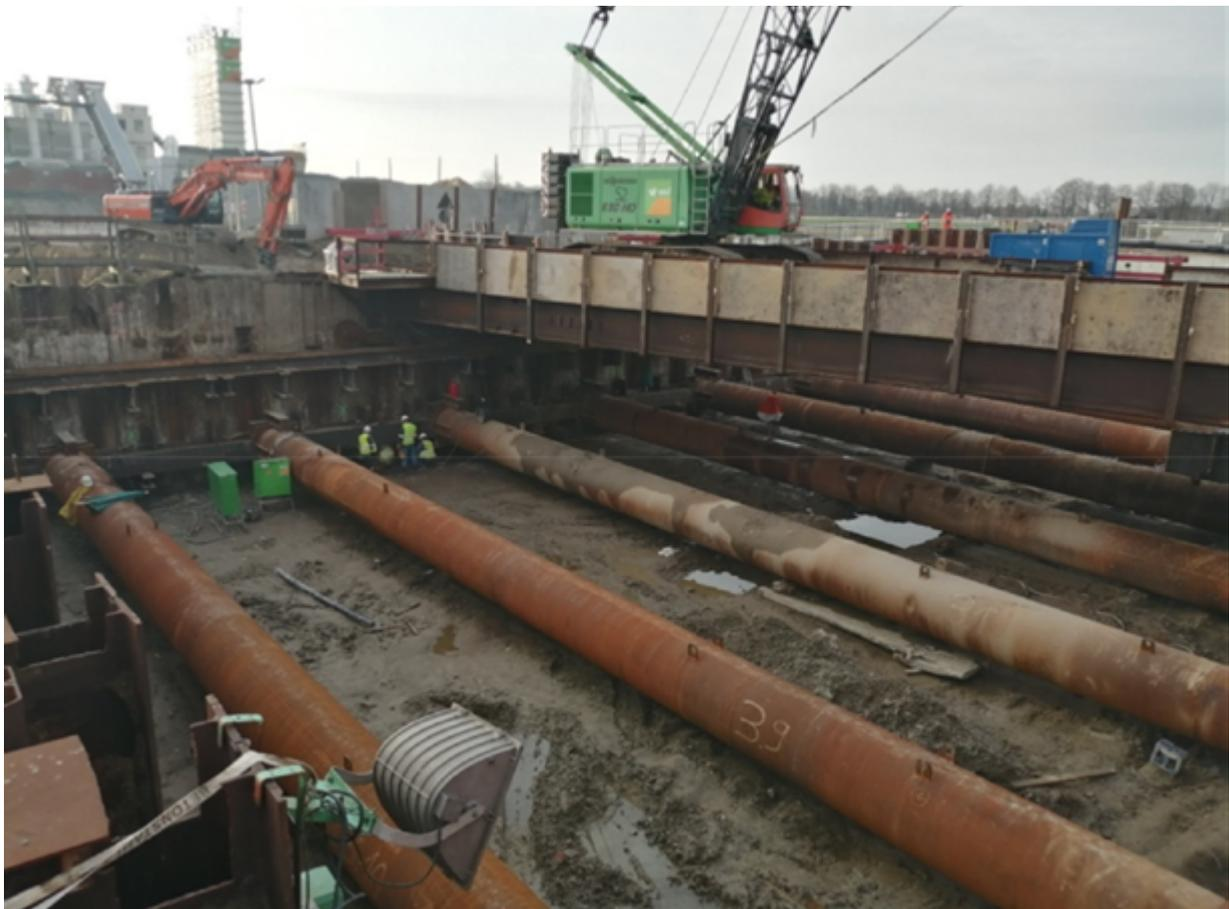
*In der Baugrube des Drepfels wurde die erste Gurt- und Steifenlage eingebaut und verschweißt. Anschließend kann mit dem weiteren Bodenaushub in der Baugrube fortgefahren werden.*
