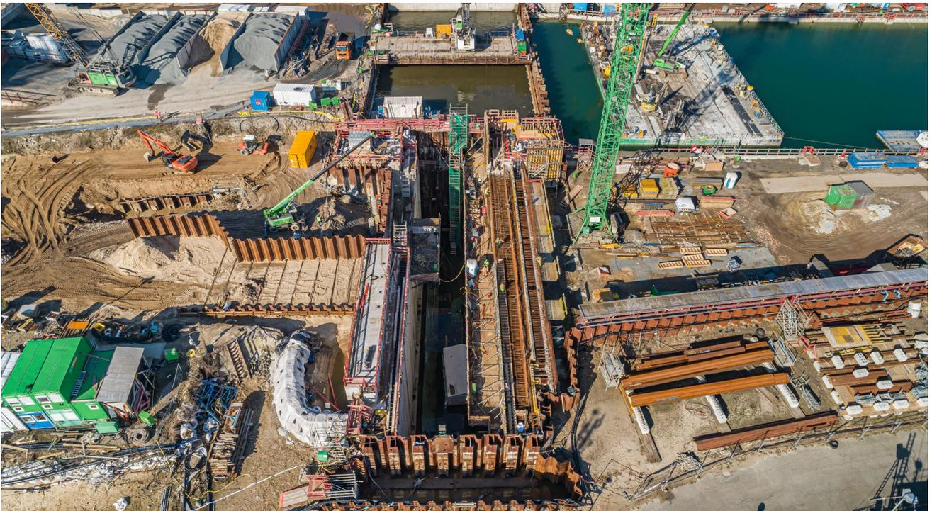
Die Wände der Torkammer des Außenhauptes wachsen weiter bis auf ihre planmäßige Höhe von 6,50 Meter NHN.
