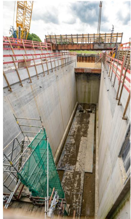
**Meilenstein erreicht: Die Torkammerwand des Außenhauptes ist fertig betoniert.**
