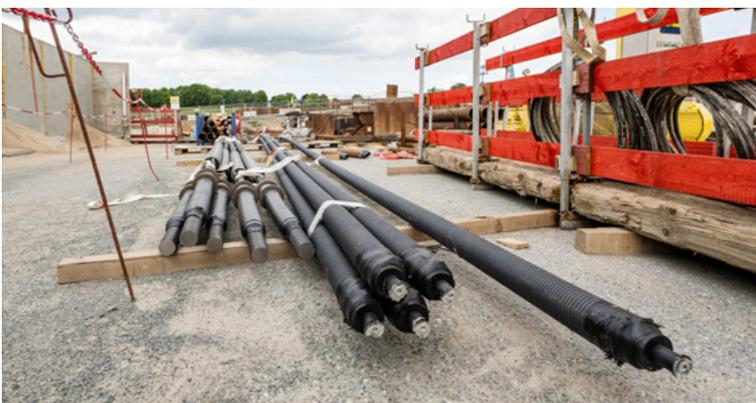
Die zwischen 11 Meter und 16 Meter langen Düsenstrahlauftriebspfähle der Schleusenammer bestehen aus einer Düsenstrahlsäule, in die ein Stahlzugglied eingestellt wird.
