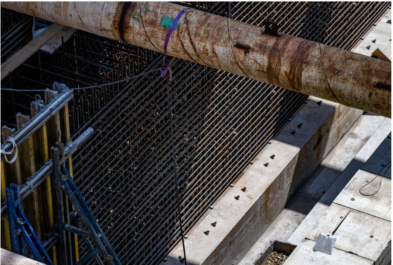
Mitte Juni fanden weitere Bewehrungsarbeiten für die Wände der Torkammer des Binnenhauptes statt.
