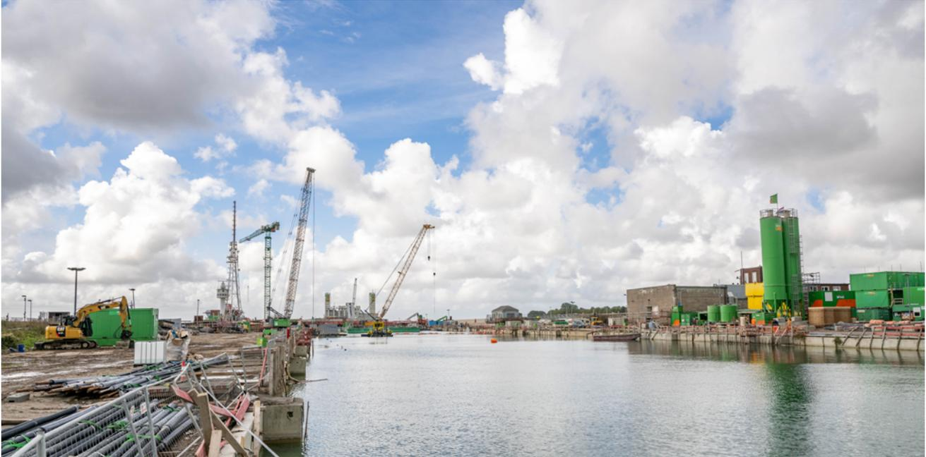
**Der Bau der 5. Schleusenammer in Brunsbüttel steht kurz vor einem weiteren Meilenstein: Die aufwändige Herstellung der knapp 1.700 Düsenstrahlauftriebspfähle für die Verankerung der späteren Schleusenammersohle ist nahezu abgeschlossen.**
