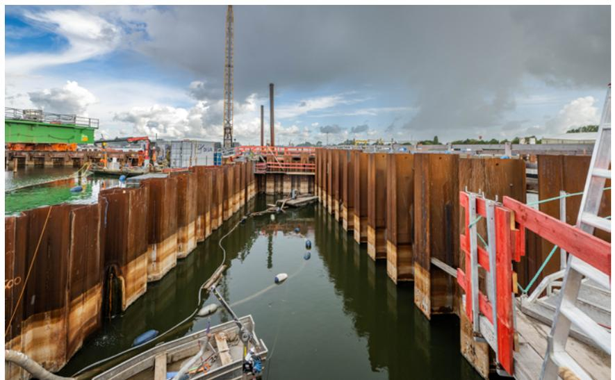
Taucherkolonnen legen in der noch unter Wasser stehenden Dremfelbaugrube des Binnenhauptes die Köpfe der Bohrpfähle frei. Zeitweise sind über 20 Taucherteams auf der Baustelle im Einsatz.
