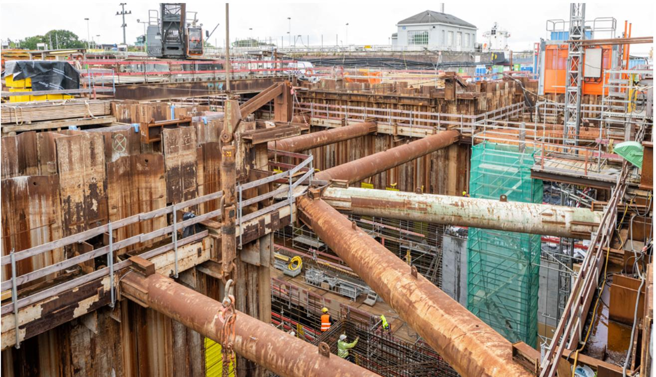
Die Betonage in der Torkammer erfolgt ringförmig. Zwei von fünf Ringen sind bereits fertig betoniert.
