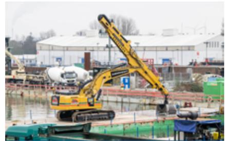
Der Teleskopbagger bewegt sich auf einem Ponton über der Schleusenammer.
