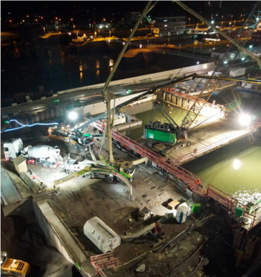
**Nächtliche Betonage: Über die flexiblen Leitungen zweier mobiler Pumpen wurde der Unterwasserbeton in die Drempebaugrube des Außenhaupts eingebracht.**
