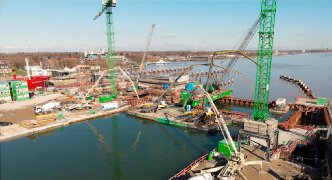
In die Drempeibaugrube wurden zur Betonage der 3,90 m dicken Unterwasserbetonsohle insgesamt 5.000 m<sup>3</sup> Beton eingebracht.
