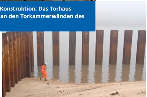
Spundwand-Skelett: Beim Rückbau des einseitigen Anlegers werden die Spundbohlen einzeln per Kran aus dem Boden gezogen.
