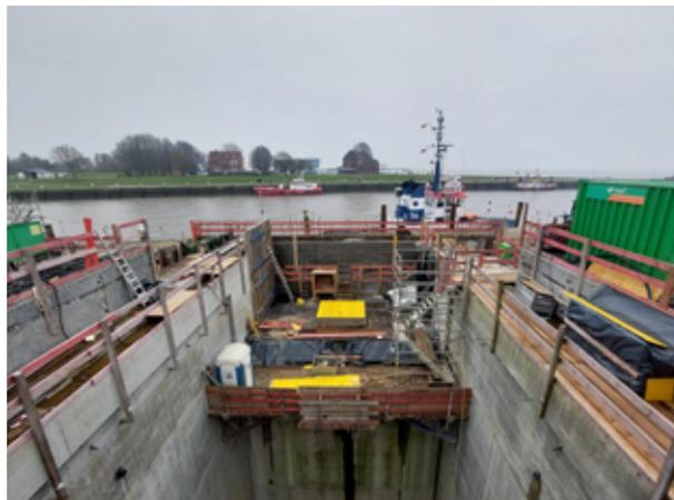
Anspruchsvolle Konstruktion: Das Torhaus „hängt“ später an den Torkammerwänden des Außenhauptes.
