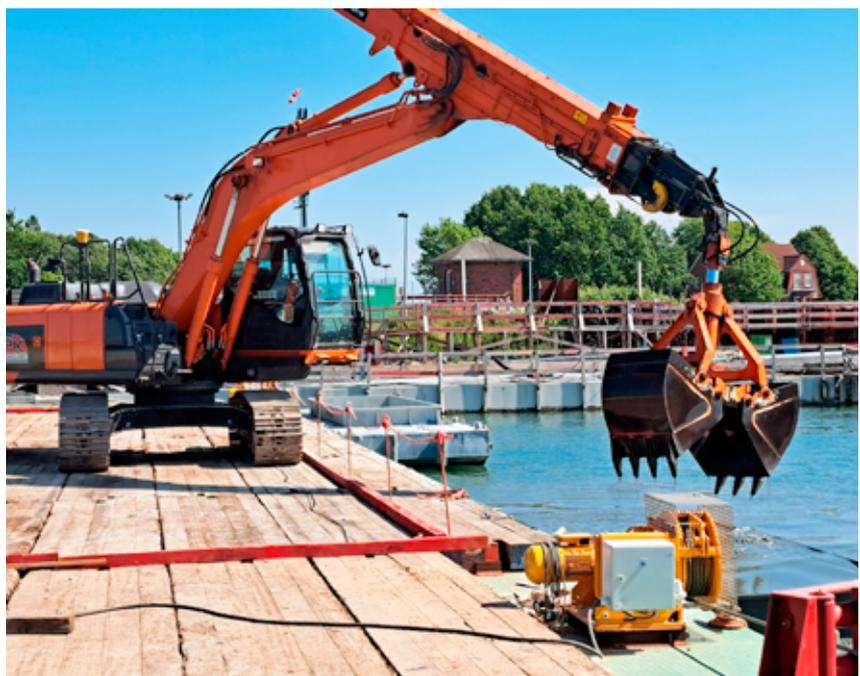
Im ersten von drei Reinigungsschritten werden die bis zu 1,80 m dicke Sedimentschicht zwischen den Pfahlköpfen ausgebaggert.
