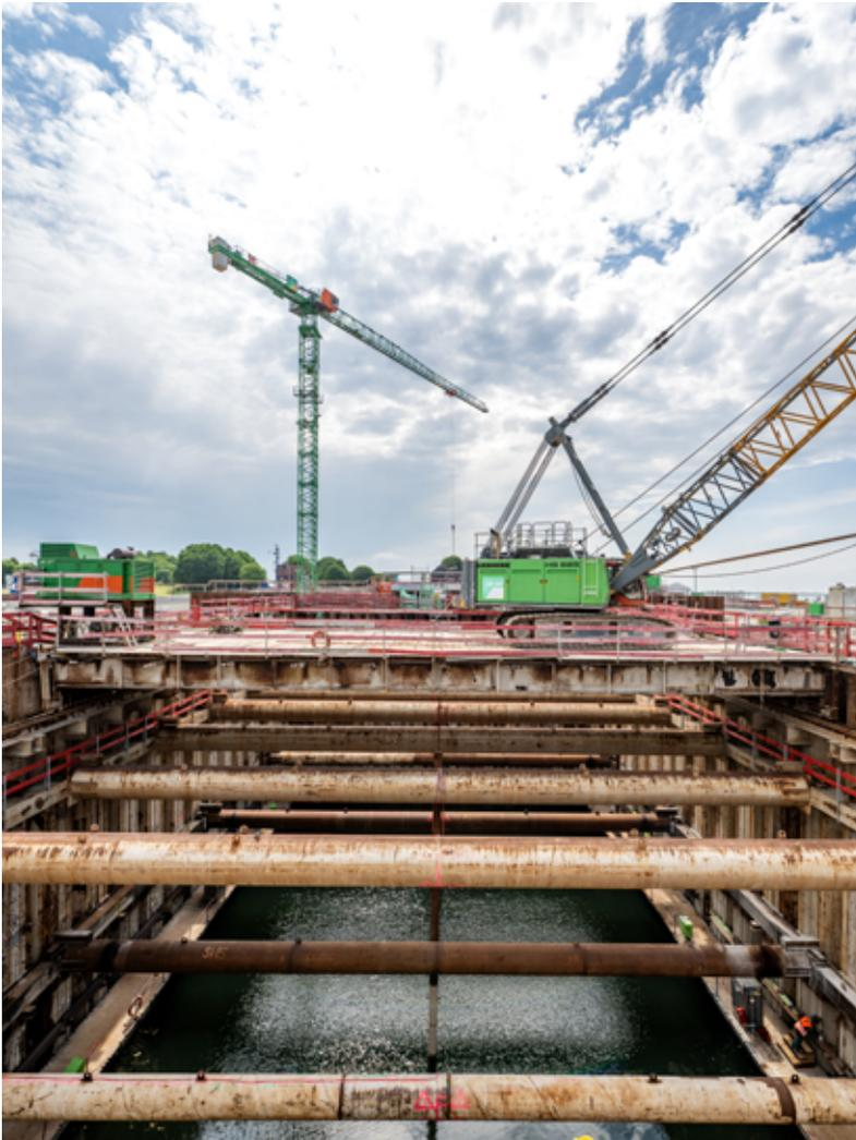
Stabilität für die Drempebaugrube: Nach dem Einbau der zweiten Steifenlage kann der Wasserstand weiter gesenkt werden.
