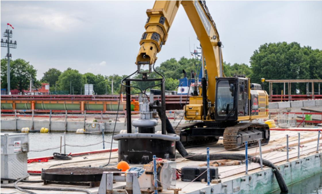
Mammutaufgabe: Zur Feinreinigung von rund 1.700 Pfahlköpfen muss die Saugglocke des Teleskopbaggers präzise über jeden einzelnen gestülpt werden.
