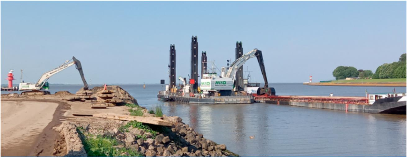
Die Baustellenfläche schrumpft: Im Rahmen der 5. Nassbaggerkampagne zur Aufweitung des Vorhafens werden insgesamt 200.000 m³ Boden abgetragen.
