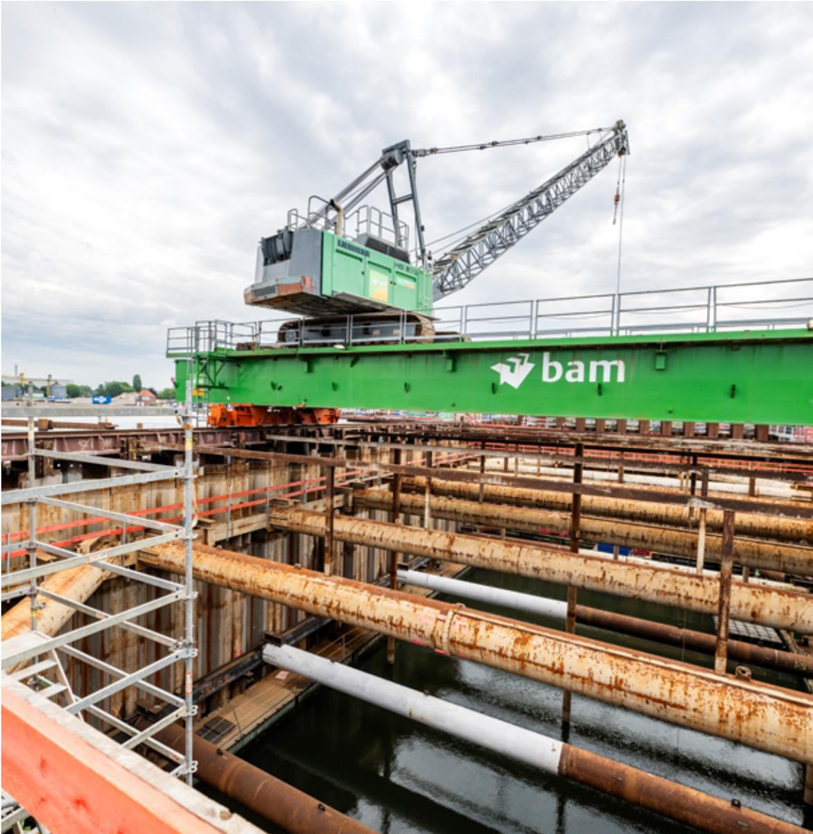
Blick in die Drempelbaugrube des Binnenhauptes: Die Steifenlagen stabilisieren die Kammerwände, sodass die Baugrube trocken gelegt werden kann.
