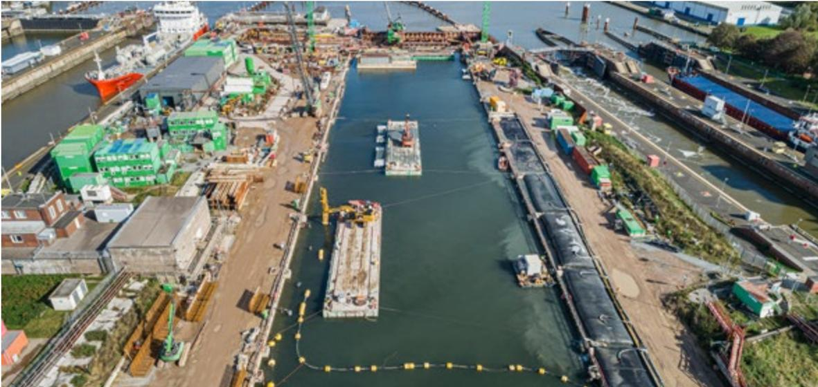
Schwimmende Bagger: Auf Pontons arbeiten sich die Reinigungsteams Richtung Binnenhaupt vor.
