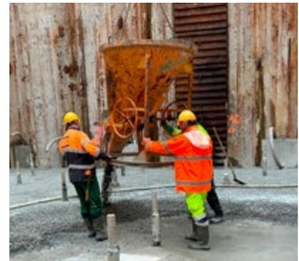
Arbeiter steuern das Einbringen des Drainbetons um die Gewinde-Pfahlköpfe.
