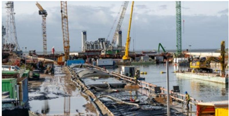
Entlang der Schleusenammer wird das abgesaugte Sediment in Spezialschläuchen getrocknet, den Geotubes.
