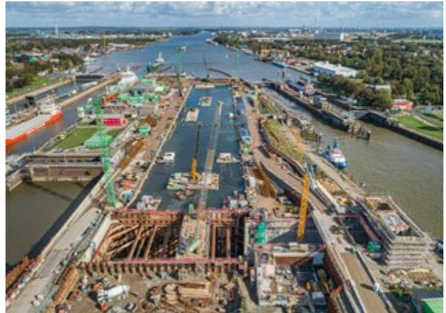
Die 5. Schleusenammer mit Blickrichtung NOK: im Vordergrund die Baugrube des Außenhaupts, rechts unten das zugehörige Torhaus.
