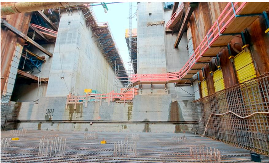
**Die Konstruktionsbetonsohle wird rund 4 Meter hoch. Orientie-
