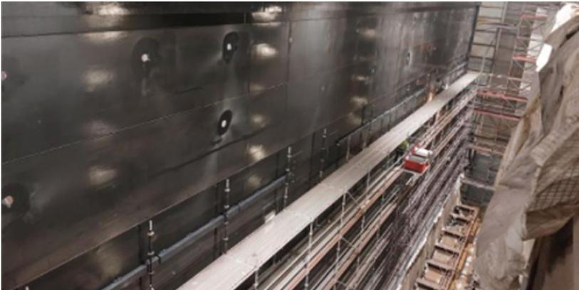
**Der letzte Schliff für Tor VII: Nach dem Gerüstabbau werden noch die Kontaktstellen gereinigt, geschliffen und grundiert.**
