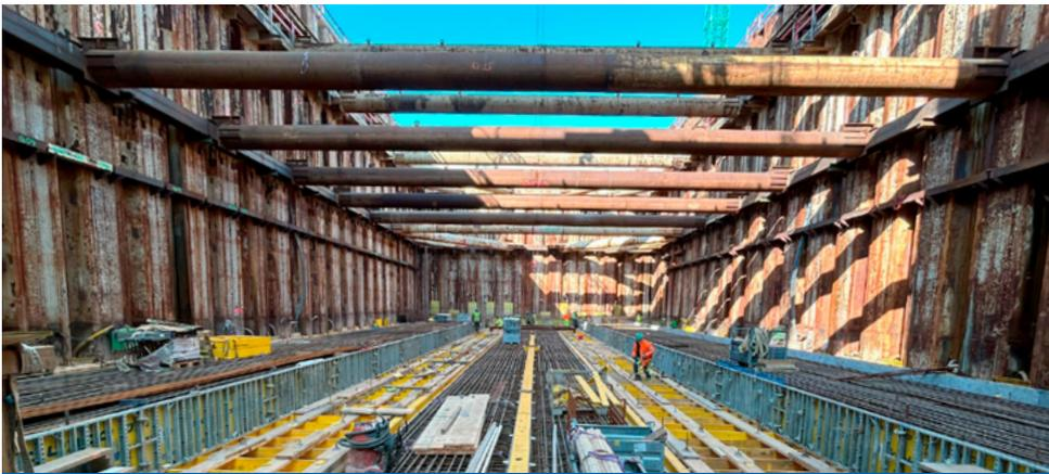
**Vorbereiten auf die Betonage: Bei Einschal- und Bewehrungsarbeiten am Außenhaupt haben die Teams alle Hände voll zu tun. Das Foto rechts oben zeigt das eingerüstete Torhaus.**
