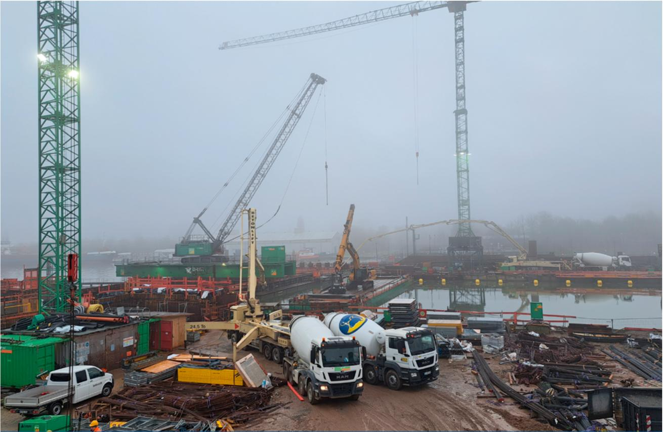
**Binnenhaupt im Nebel: Betonmischer versorgen die Pumpen bei der Betonage des Drepfels.**
