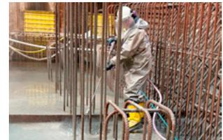
**Am Außenhaupt sind beide Abschnitte der rund vier Meter hohen Konstruktionsbetonsohle des Drempels fertiggestellt, sodass die Betonageteams jetzt mit der Konstruktion des Toranschlagpfeilers beginnen.** Der trägt als vertikaler Anschlag zur Dichtheit des Schleusentores in geschlossenem Zustand bei.
