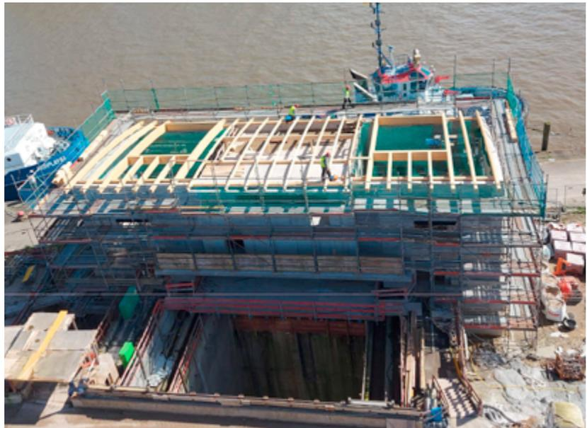
**Dachstuhl mit Montageöffnungen: Über sie wird später die Antriebstechnik per Kran ins Torhaus abgelassen.**
