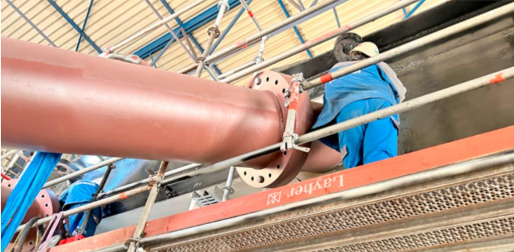
**Endmontage: In Emden werden die Oberwagen-Anschlüsse an die fertiggestellten Schleusentore montiert – hier an Tor VII.**
