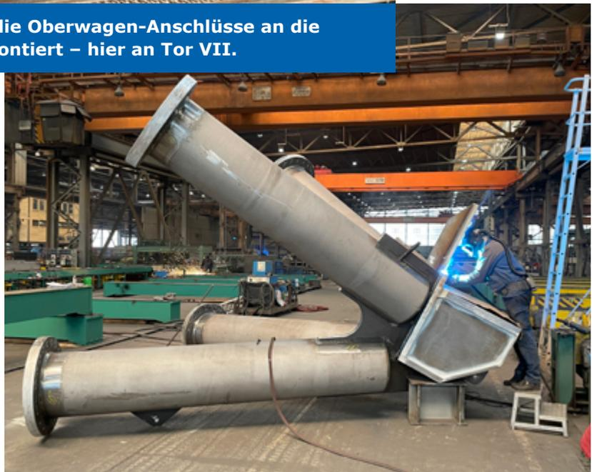
**Die vier Arme des Oberwagen-Anschlusses werden später mit dem Schleusentor verbunden.**
