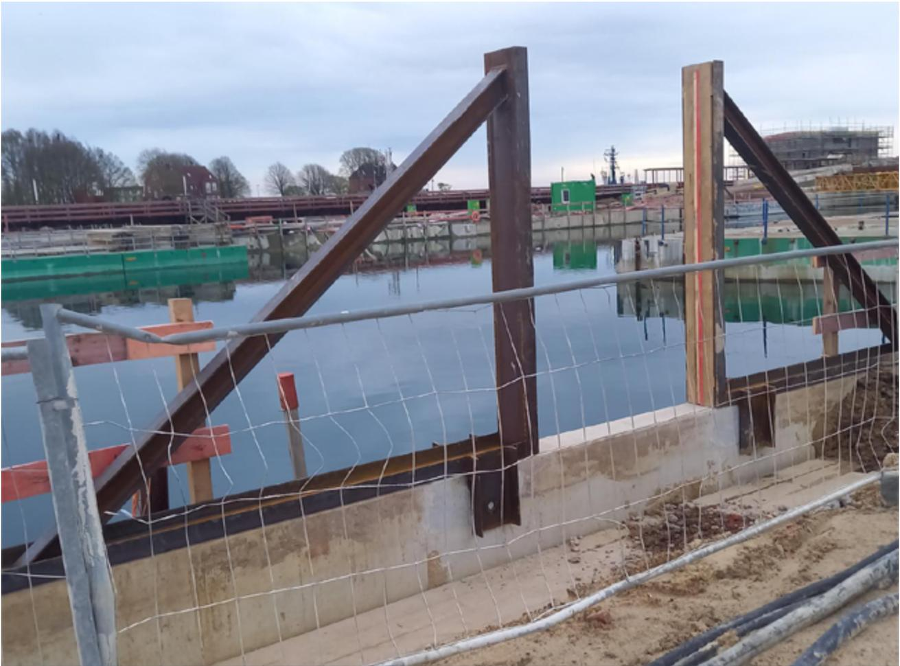
**Trägermedium: Insgesamt 14 dieser Vorrichtungen fixieren die sieben Stahlträger, an denen insgesamt 35 Hebungspegel befestigt werden.**
