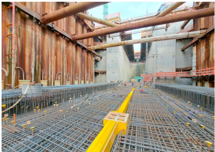
**Dicht geflochtene Bewehrung: Blick über den Drepfel des Binnenhaupts in Richtung Torkammer.**
