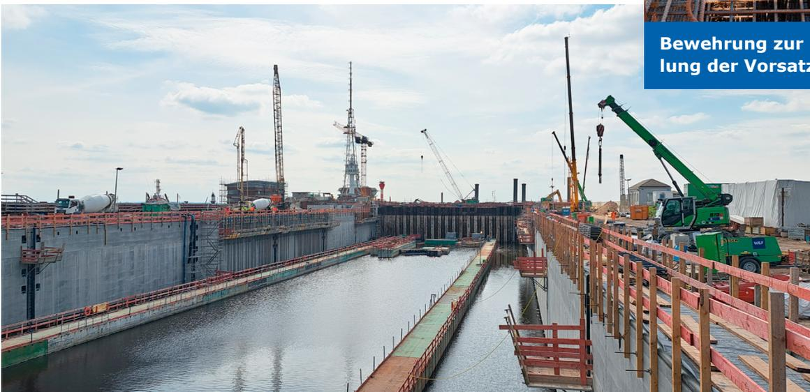
**Nach 18 Bauabschnitten haben die Betonageteams die Arbeiten an den zweiseitigen Vorsatzschalen erfolgreich abgeschlossen.**
