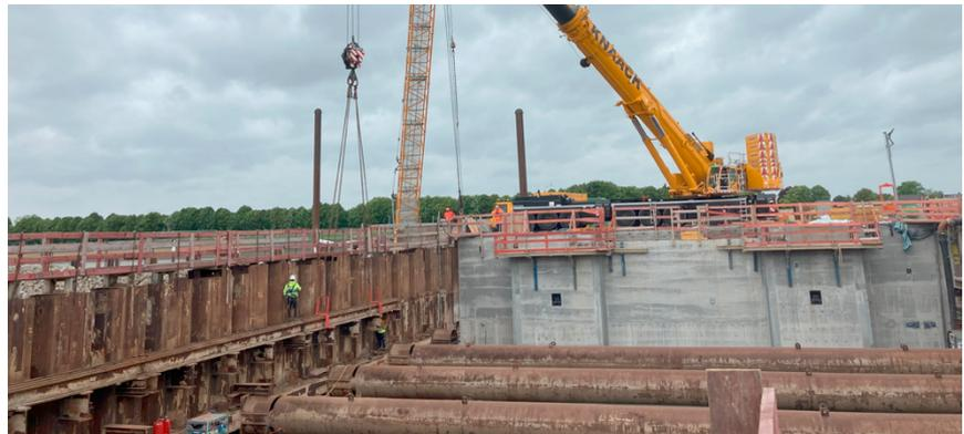
**Flutung mit System: Gurtungs- und Steifenlagen des Außenhauts wurden stufenweise zurückgebaut.**
