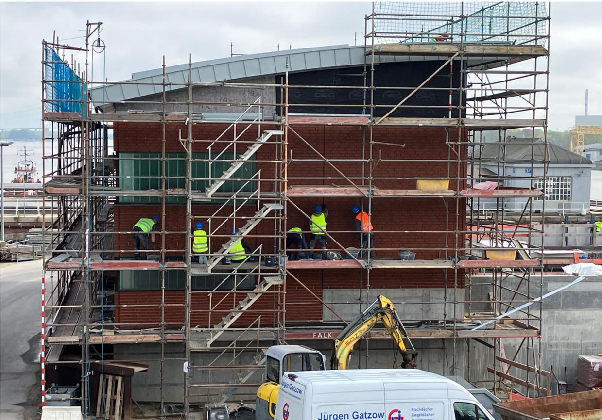
**Endspurt: Teams der ARGE bearbeiten die letzten Fugen am Verblendmauerwerk des Torhauses.**
