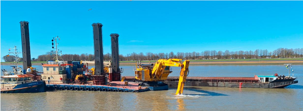
Zur Gestaltung des Vorhafens werden rund 230.000 Kubikmeter Nass- und 150.000 Kubikmeter Trockenaushub bewegt.
