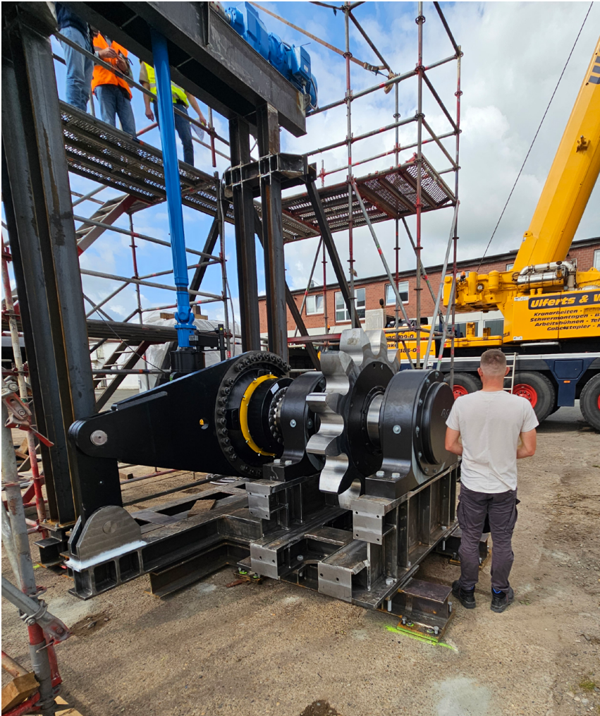
Auch die Zahnkränze, über die später die Antriebsketten laufen, werden ausgiebig getestet.
