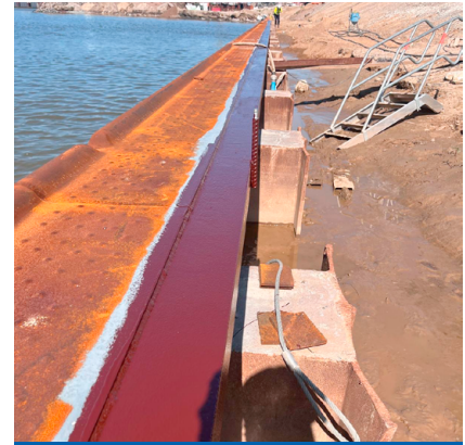
Korrosionsschutz für die Ufersicherung des Vorhafens.
