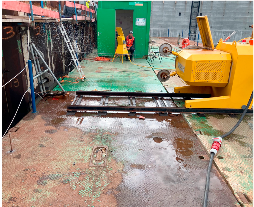
Aus sicherem Abstand steuert ein Spezialist das Durchtrennen der Bohlen per Seilsäge.
