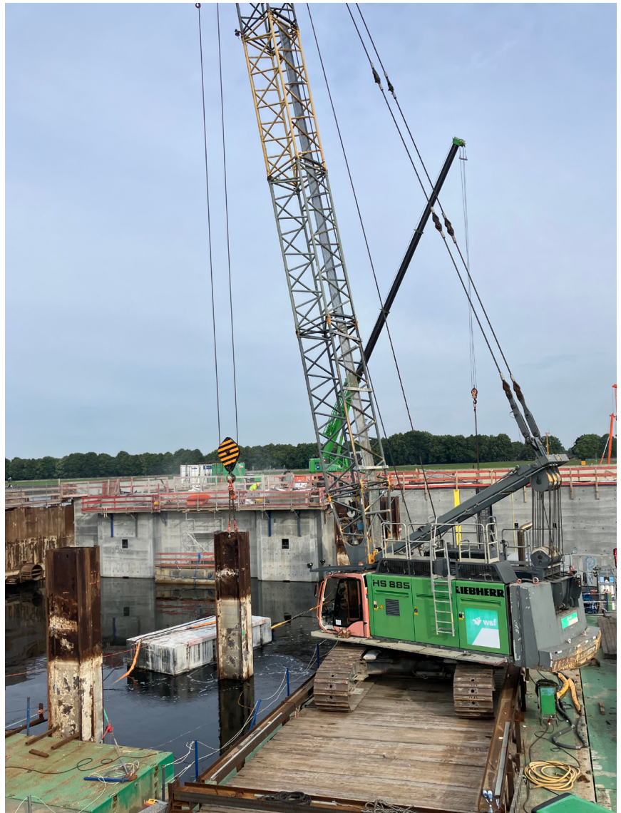
Von einem Ponton aus zieht ein Kran die letzten Tragbohlen der ehemaligen Baugrubenwand.
