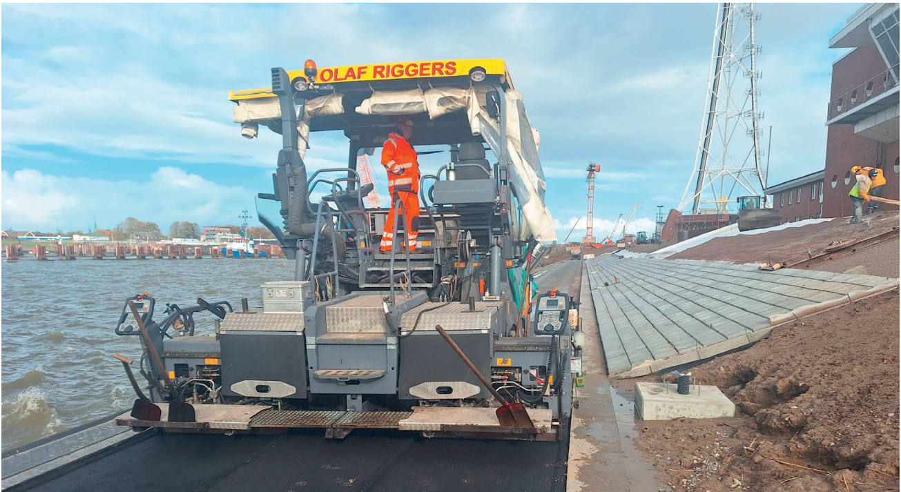
Moderner Asphaltfertiger bei der Arbeit: Hier entsteht der befahrbare Treibselweg entlang des neuen Vorhafens. Rechts die angrenzende Böschung mit gepflastertem Deckwerk.
