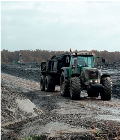
Traktoren transportieren den einbaufähigen Aushub.
