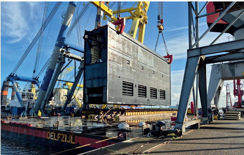
Getragen von zwei Schwerlastkränen schwebt das rund 2.350 Tonnen schwere Schleusentor ins Hafenbecken.
