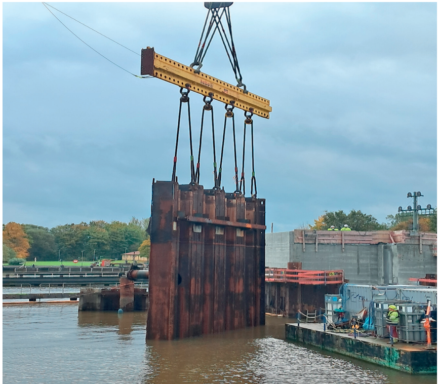
Ehemalige Baugrubenwand: Ein Schwimmkran zieht die vorgeschnittenen Spundwand-Elemente aus dem Boden.
