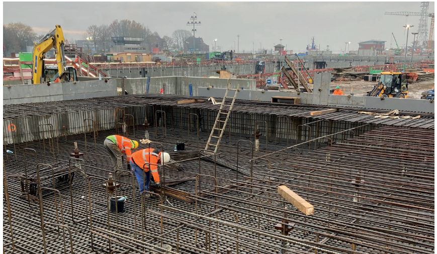
Schalung und Bewehrung der Kranaufstellfläche 9 auf der Nordseite des Binnenhauptes neben der Torkammer.
