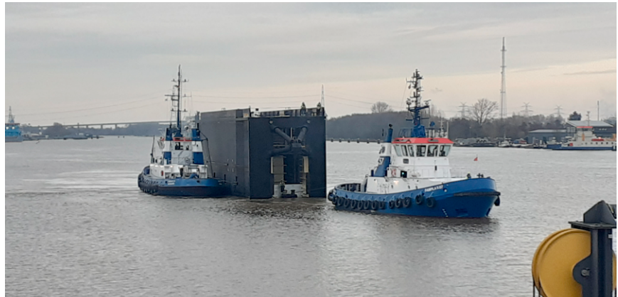
Zwei Schlepper transportieren das neue Schleusentor zum Binnenhaupt.
