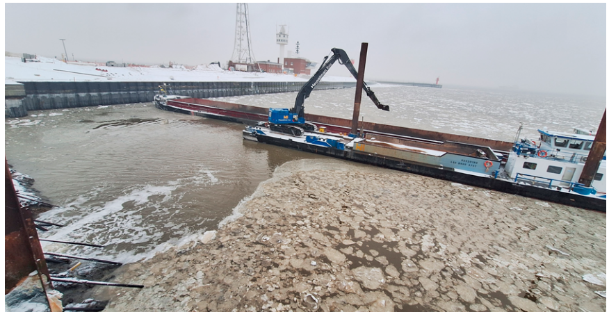
Seltenes Bild: Nassbaggerarbeiten am Außenhaupt bei Eisgang.
