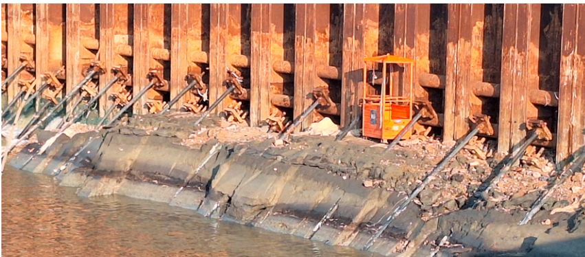
Freigelegte Schrägpfähle vor der südwestlichen Spundwand des Außenhauptes.
