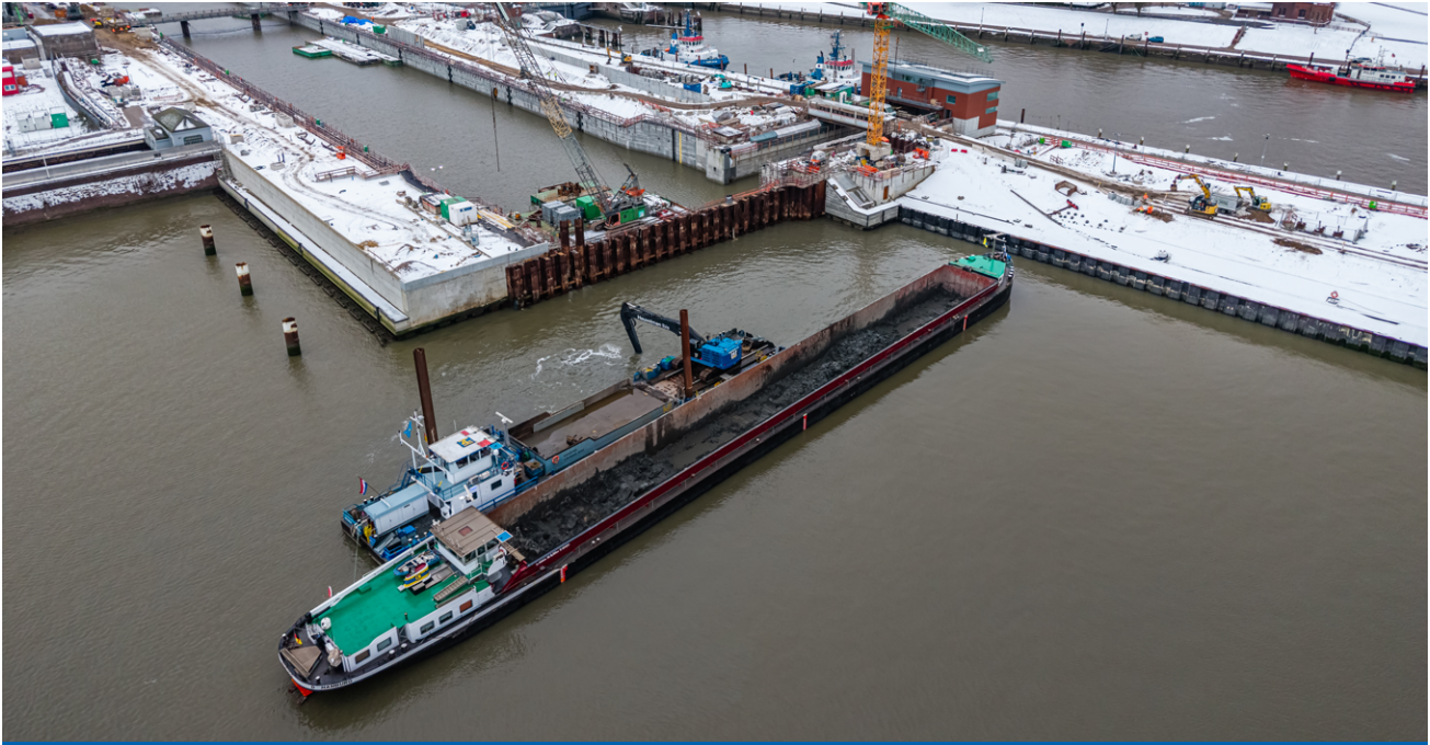
Der Nassaushub wird auf ein längsseits liegendes Binnenschiff verladen, das ihn später über den NOK ins Bodenlager transportiert.
