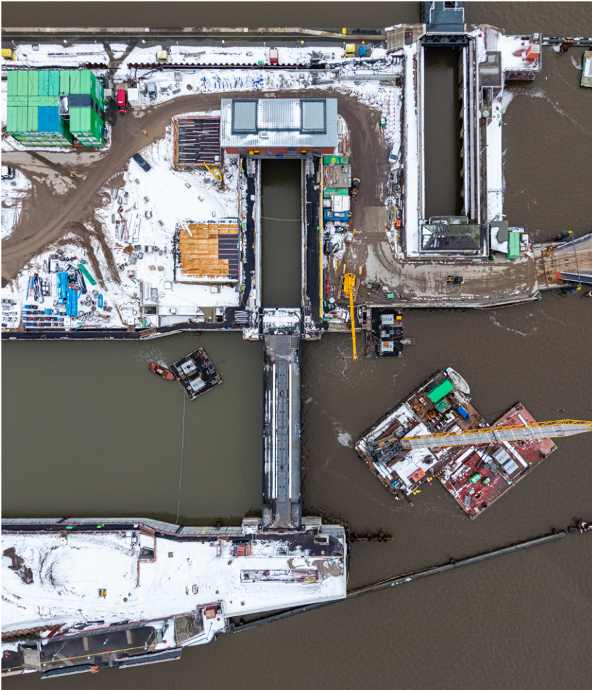
Geschlossenes Tor VII am Binnenhaupt: Oberhalb des Tores ist die Torkammer mit Torhaus zu sehen.
