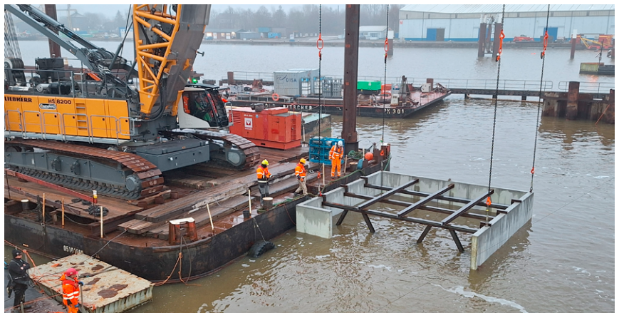
Spezialteams platzieren die Rahmenkonstruktion für einen der Torabstellpunkte.
