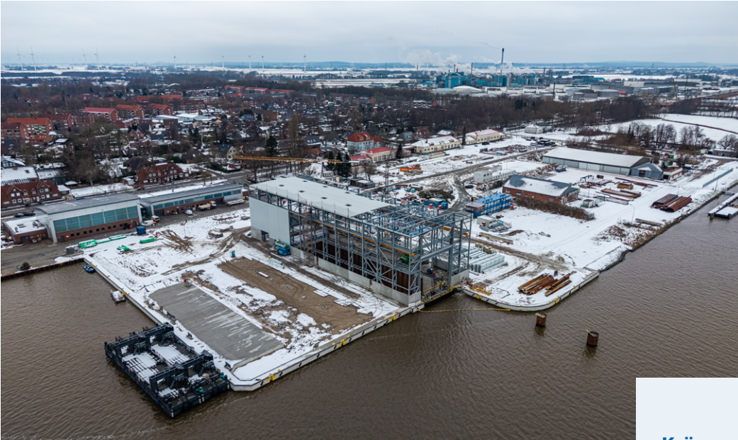
Torinstandsetzungsdock im Bau: Links warten die beiden Hebeponsen für den Wassertransport der Tore auf ihren Einsatz.
