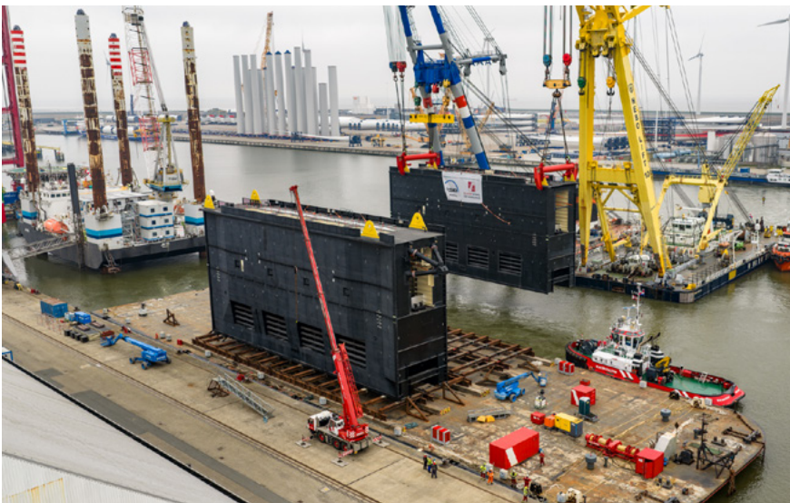
Teamwork: Die beiden Schwimmkräne HEBO Lift 10 und Matador 3 heben die neuen Schiebetore ins Hafenbecken von Eemshaven.
