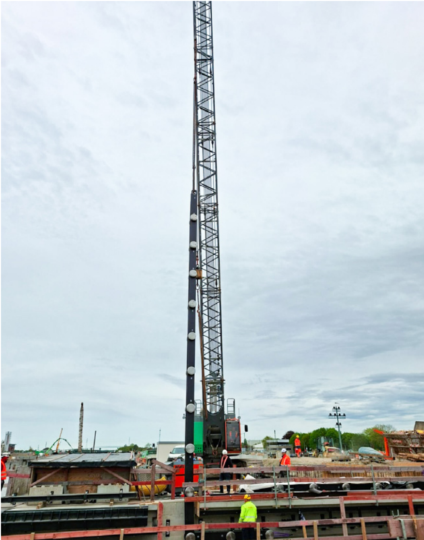
Maßarbeit: Die Elemente der Antriebskette werden per Kran in die Kettenführung eingebaut.
