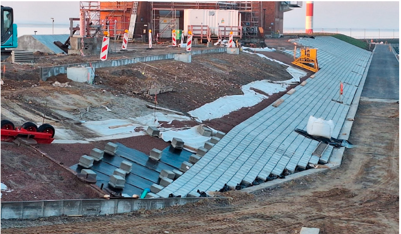
Hochstabiles Deckwerk: Eine Spezialfirma hat die Böschung im Bereich des Vorhafens mit speziellen Steinen im Nut- und Federsystem gepflastert.
