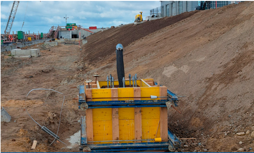
Beleuchtungsvorbereitung: Verschalung für ein Lichtmastfundament nahe der nördlichen Kammerwand.
