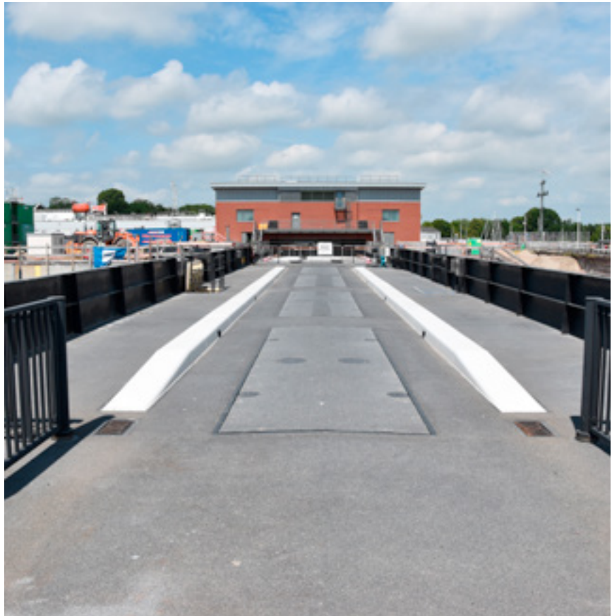
Die neuen Schleusentore können von Lastwagen überfahren werden.
