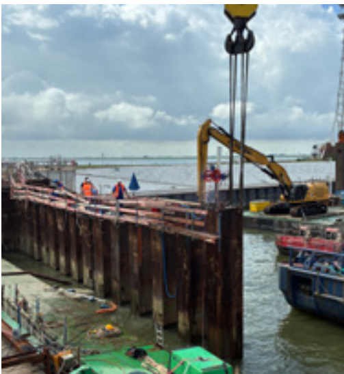
Rückbau der Baugrubenwand am Außenhaupt.
