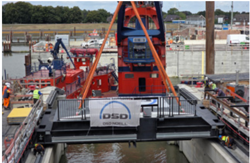
Einheben des Oberwagens am Außenhaupt mit TK 10.
