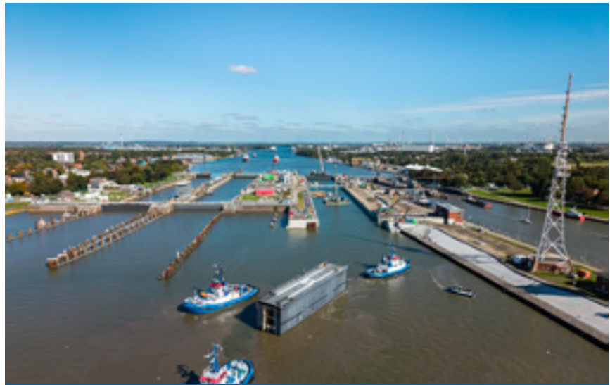
Mit Schleppern wird das neue Schleusentor zum Außenhaupt gebracht.
