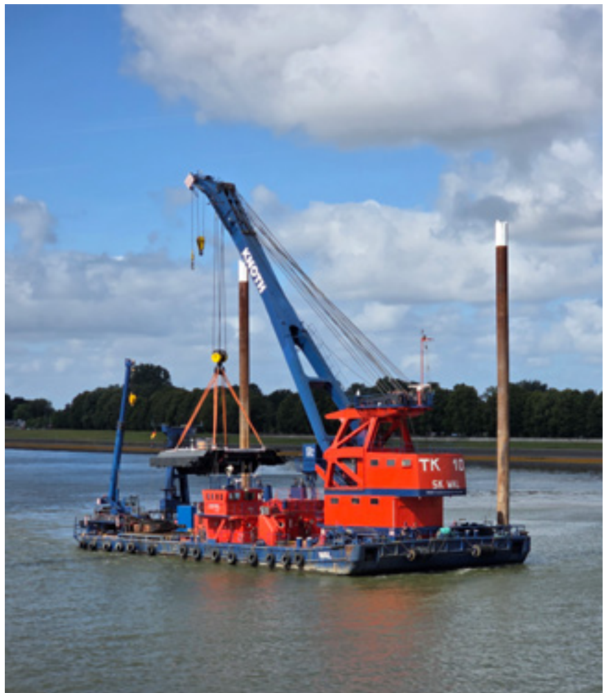
Mit dem Oberwagen am Haken fährt der Schwimmkran TK 10 zum Außenhaupt.
