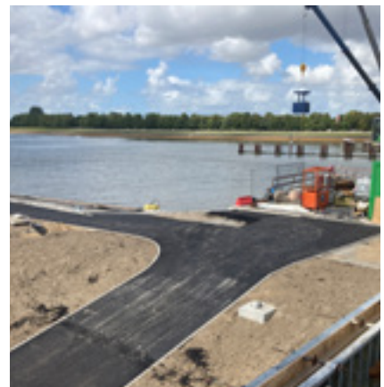
Fertig asphaltierter Betriebsweg am Außenhaupt.
