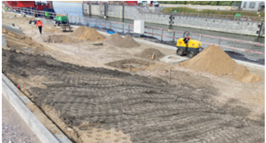
Blick auf die künftige Planie der neuen Schleusenkammer.
