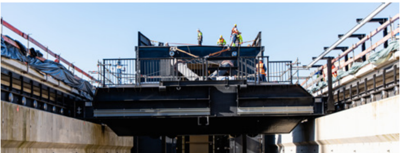
Bevor das Tor mit dem Oberwagen (vorn im Bild) verbunden werden konnte, musste es abgesenkt werden.
