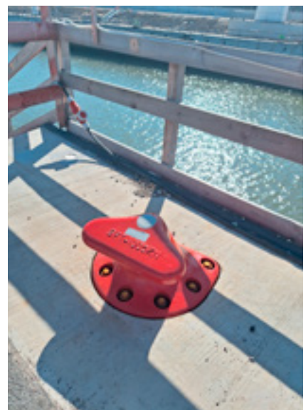
Die Poller zum Festmachen der Schiffe sind montiert.
