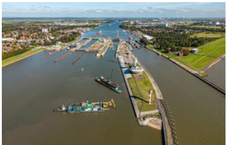
Schwimmendes Gerät beim Einbau des Deckwerks im elbseitigen Vorhafen.
