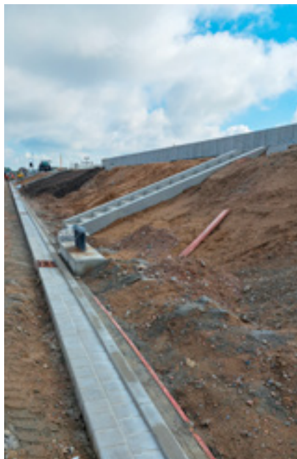
Bordsteine und Treppen lassen die künftige Geländestruktur erkennen.
