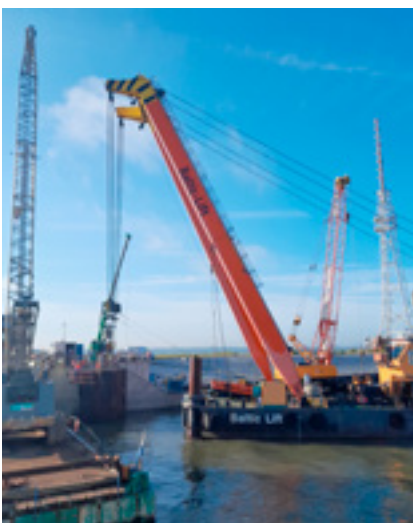
Baltic Lift im Einsatz am Außenhaupt.
