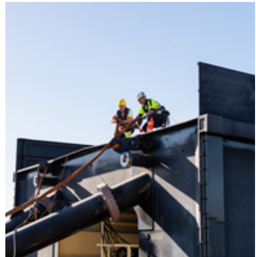
Starke Gurte halfen beim Einschwimmen des Tores.
