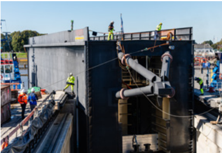
Der Einbau des neuen Schleusentores war Zentimeterarbeit.
