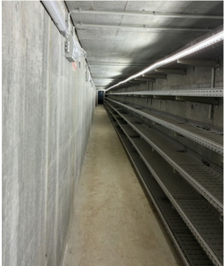
Blick in den Tunnel am Außenhaupt, rechts die Kabeltrassen.
