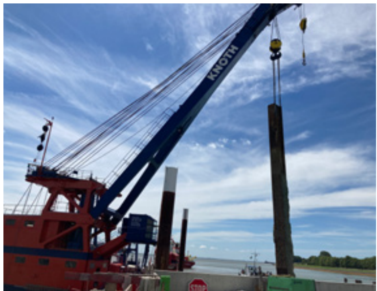
Schwimmkran TK 10 hebt eine Bohle der Baugrubenwand aus.
