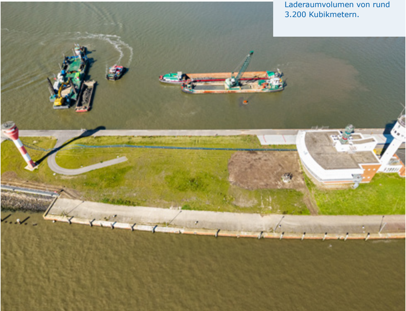
Im elbseitigen Vorhafen laufen die Arbeiten am Deckwerk.
