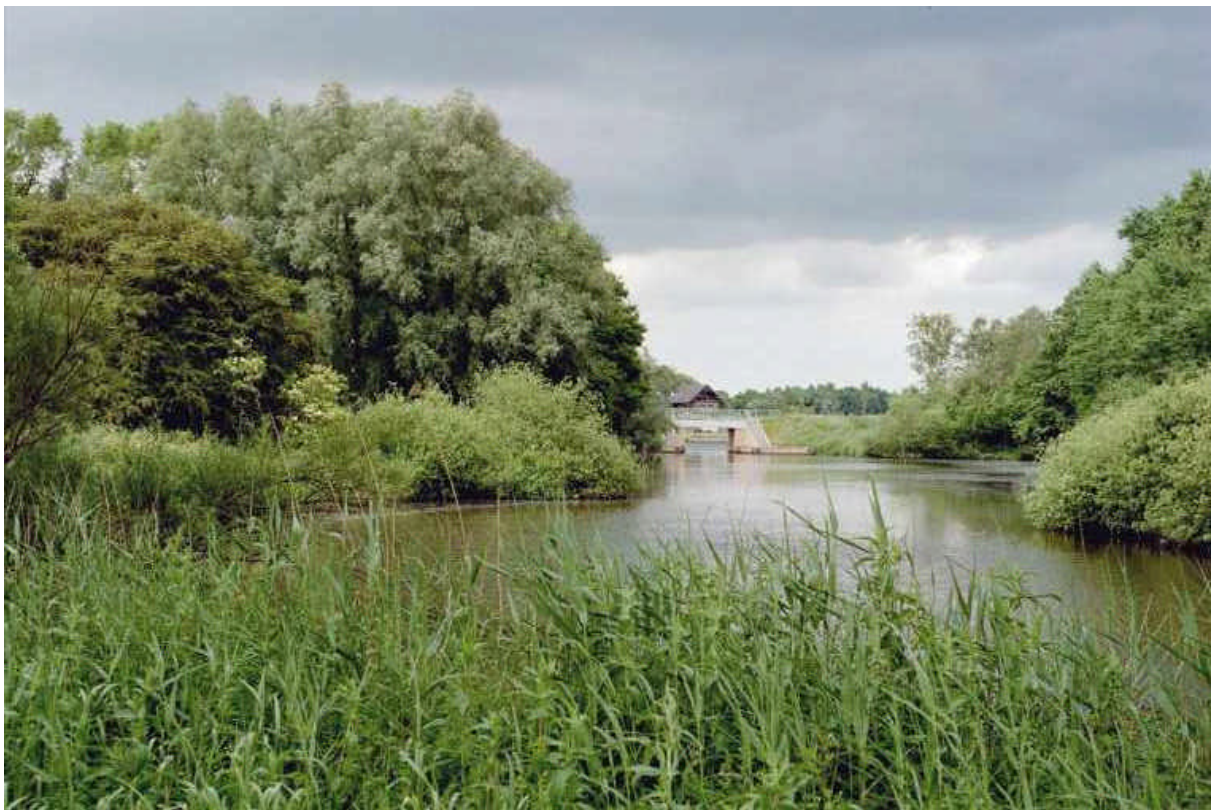
Abbildung 3-1: Blick von der Haaler Au über den Durchlass in den NOK (Quelle: http://www.meerforelle-sh.de/angelplaetze-meerforelle-seatROUT/Meerforelle_Seatrout_Fliessgew/Page22956/Haaler_Au/body_haaler_au.html ).
