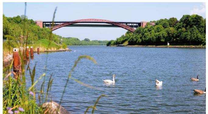
Bild 6. Hochbrücke Levensau nach Umbau 1955 – heute; Rückbau der Turmaufbauten, Fahrbahnverbreiterung (Foto: WSV)
