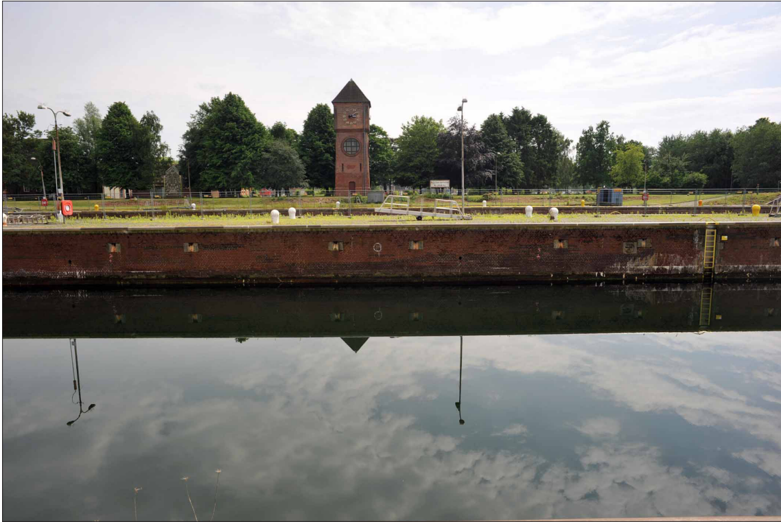
Bild 04 Ansicht von Norden. Blick von der Mittelmauer der Schleuse auf das Südufer
