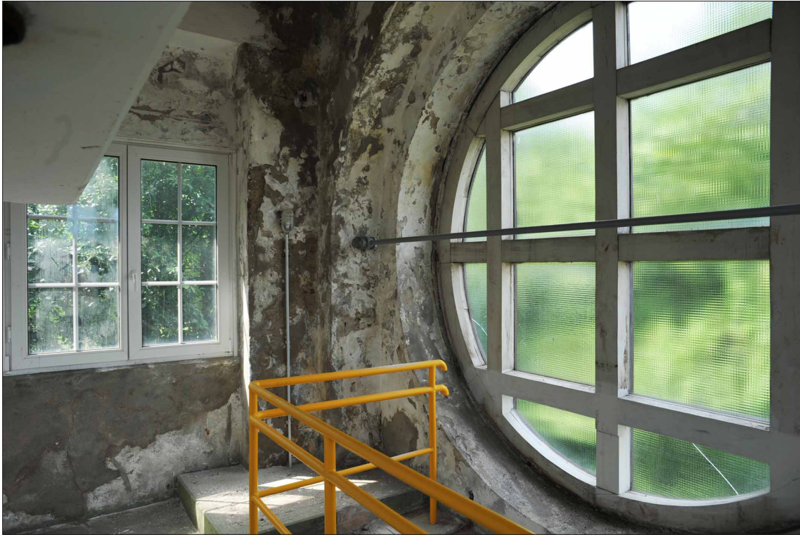
Bild 13 Die Pegelanzeigen wurden ersetzt durch Fenster (rechteckig – Rollbandpegel, rund – Zifferblattpegel)
