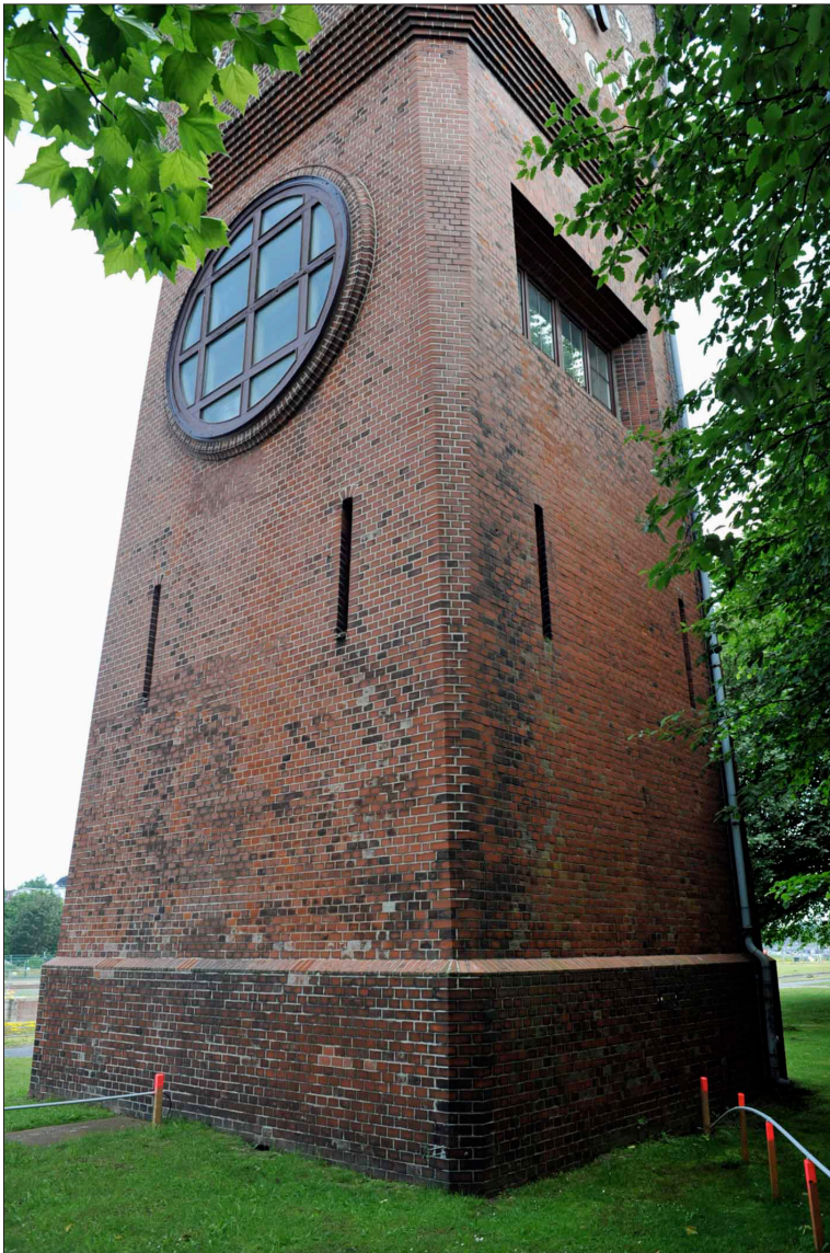
Bild 08 Ansicht von Südwesten
