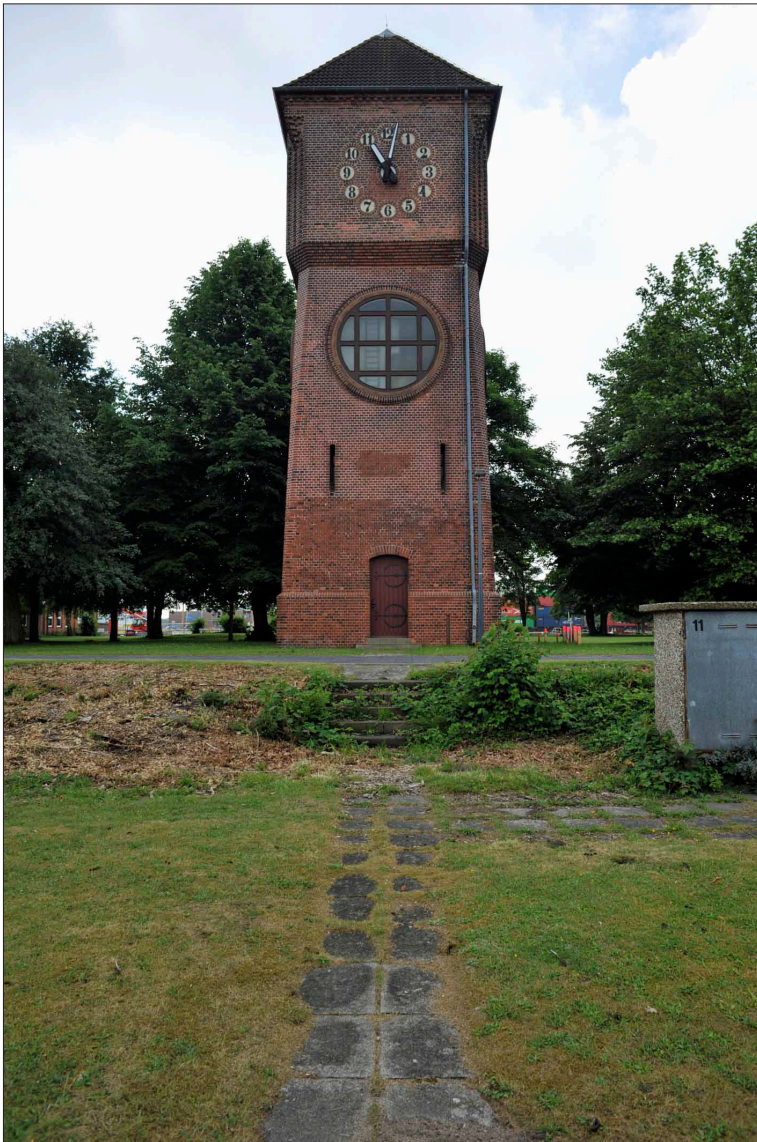
Bild 06 Ansicht von Norden
