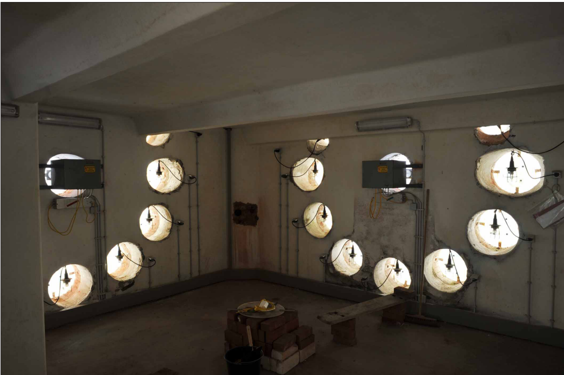
Bild 12 Uhr. Jede Stundenziffer verfügt über eine Mauerwerksöffnung mit transparentem Zifferblatt und Lampe.
