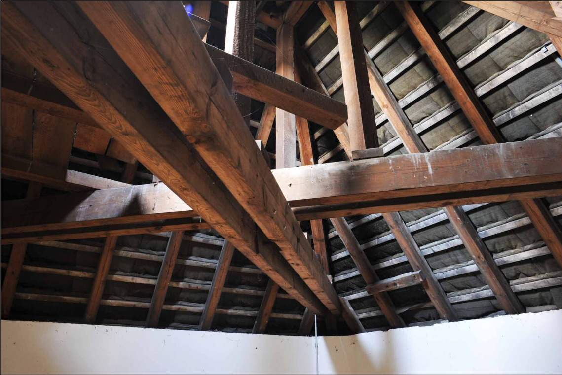
Bild 11 Blick in den Dachstuhl
