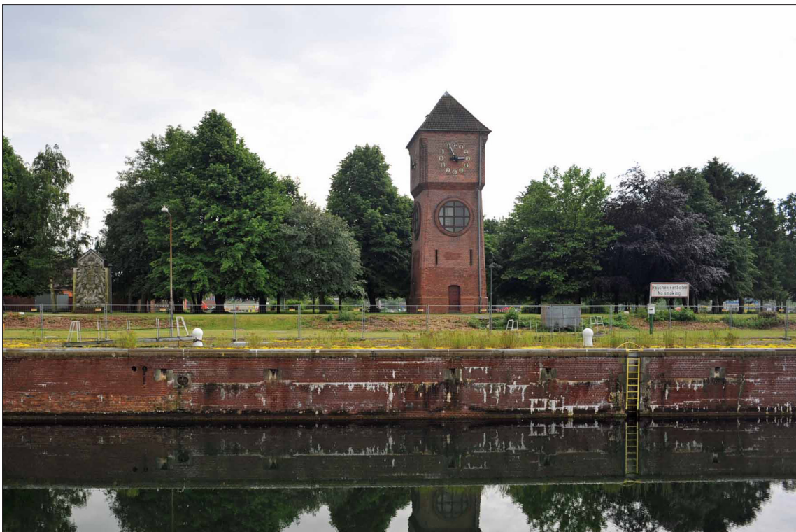
Bild 05 Ansicht von Norden. Blick von der Mittelmauer der Schleuse auf das Südufer
