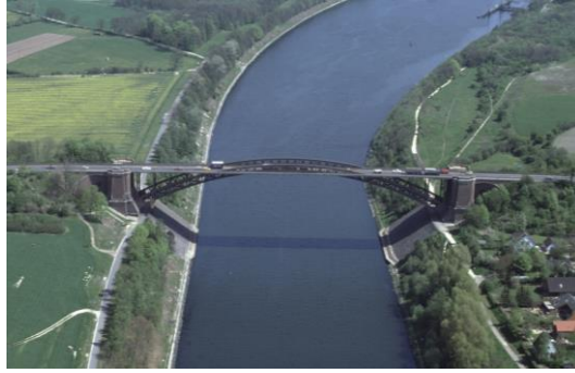
Abb. 6: HB Lev 1 1975 mit Böschungssicherungen 1914 und Fahrbahnumbau 1955
