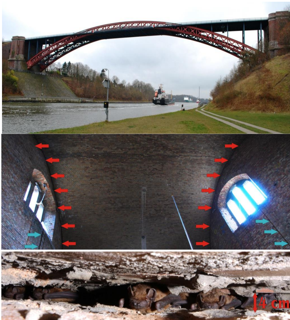
Abb. 1: Die Levensauer Hochbrücke überspannt den Nord-Ostsee-Kanal. In Deckenspalten der Gewölbewiderlager überwintern u.a. Große Abendsegler (unten) (Fotos: Dietz, Kugelschafter).
