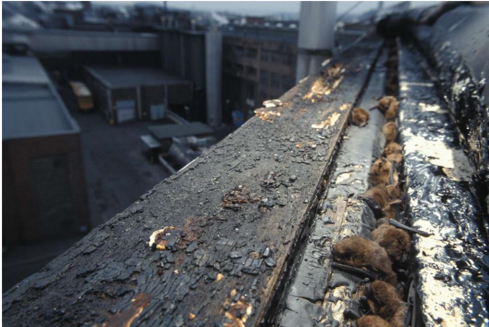
Abb. 6: Zwergfledermäuse Pipistrellus pipistrellus , im Winter in einer Gebäudespalte bei Dachsanierungsarbeiten entdeckt (Foto: Thomas Stephan).
