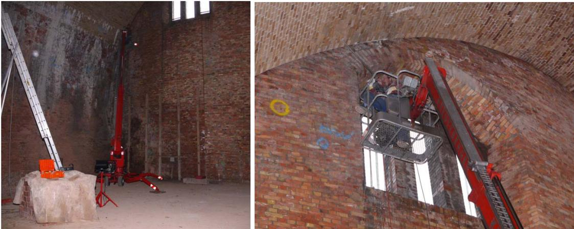
Abb. 51: Für die Einbauarbeiten wurde von der Fa. Kreuzberger ein Hubsteiger gemietet. Die Bohrarbeiten wurden von Fa. Schwalbe durchgeführt. Das rechte Foto zeigt einen Arbeiter beim Bohren eines Deckenloches, in das anschließend eine sogenannte Sensorlanze eingeführt wurde.
