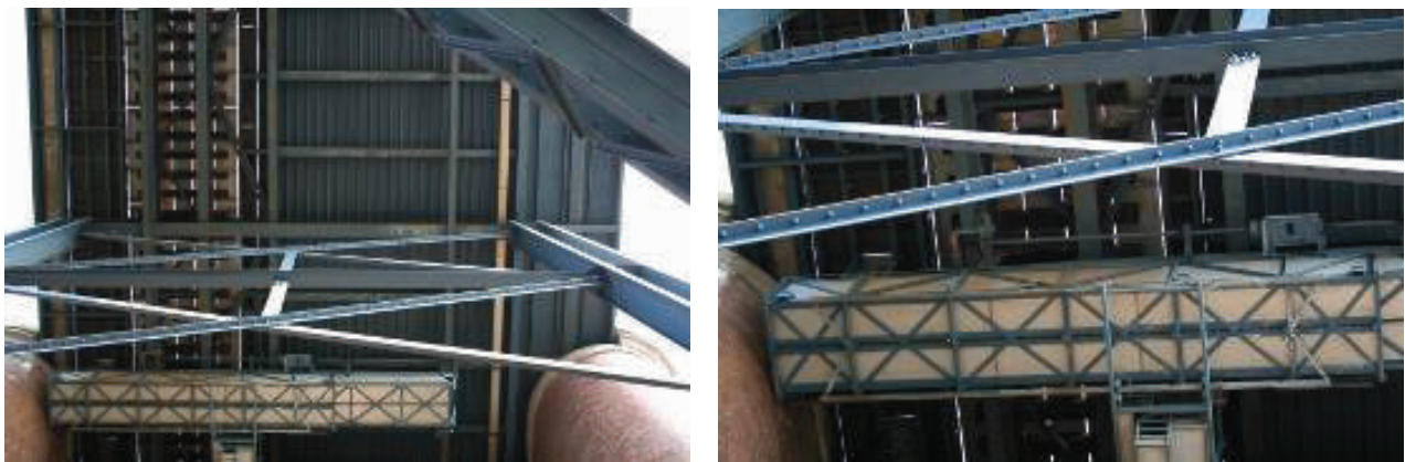
Abbildung 3: Blick unter die Brücke am Widerlager Nord auf den Fahrbahnbereich (linkes Bild) und den Gleisbereich einschl. Wartungskasten Nord (rechtes Bild)
