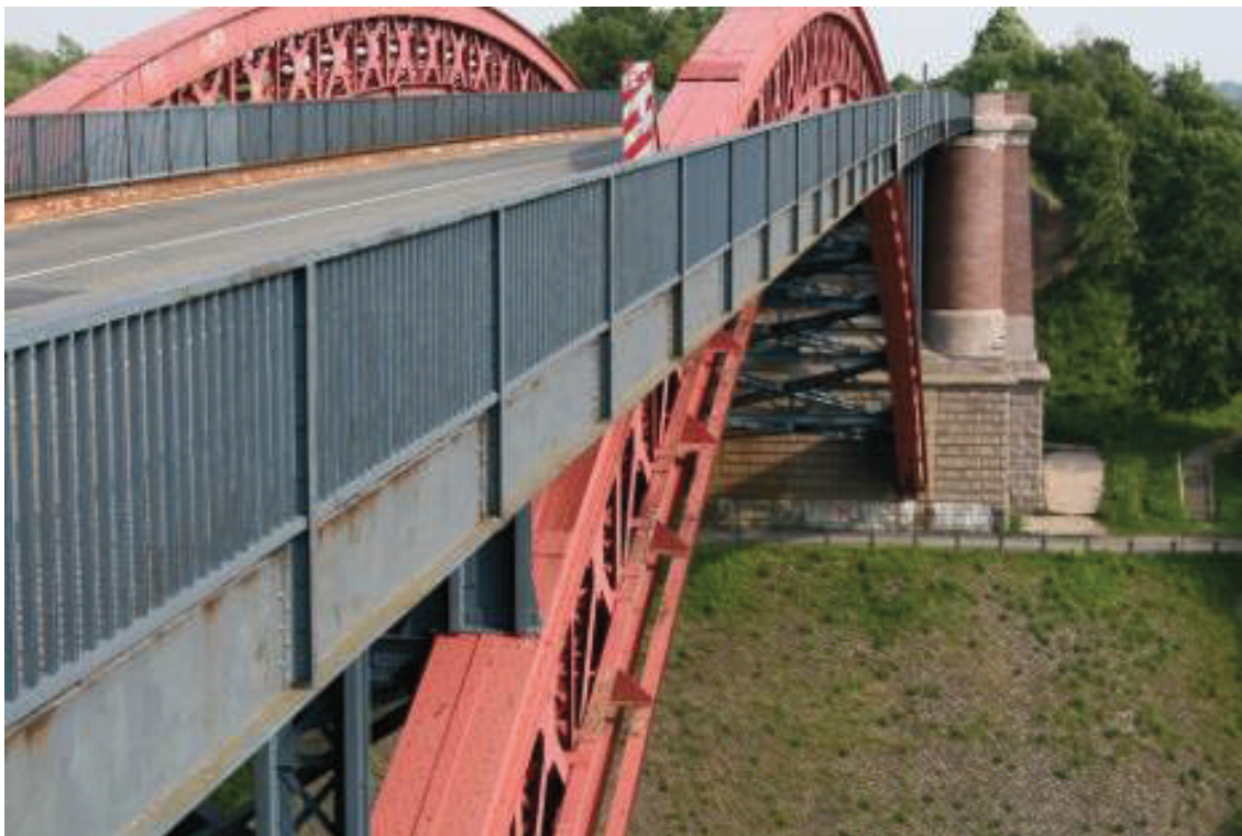
Abbildung 1: Blick vom Widerlager Nord auf die Levensauer Hochbrücke
