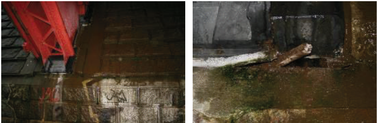
Abbildung 5: Auflager des Bogens am Widerlager Süd (links) mit Dichtungsmaterialien
