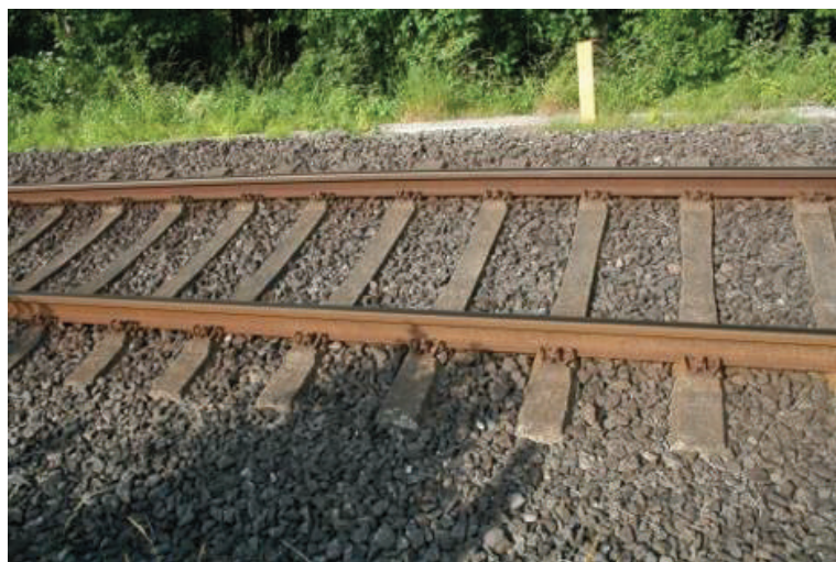
Abbildung 8: Gleise mit Gleisbett im Rampenbereich
