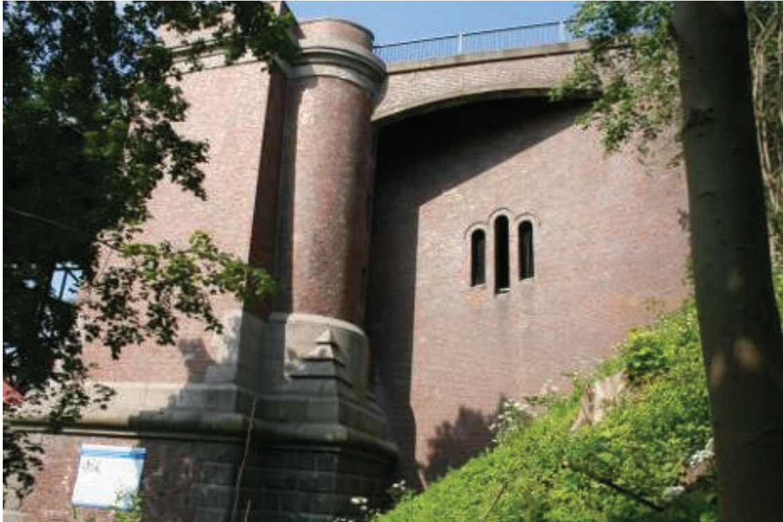
Abbildung 2: Blick auf das südliche Widerlager-Gebäude mit Brückenansatz (links) und Aussichtsplattform links oben
