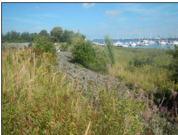
Abbildung 29: Ufersicherung mit Steinschüttung
