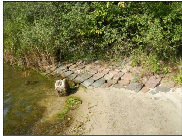
Abbildung 10: Böschungssicherung mit Blocksteinen
