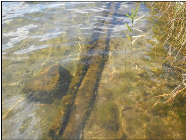
Abbildung 9: Ufersicherung unterhalb der Wasseroberfläche (Palisaden)
