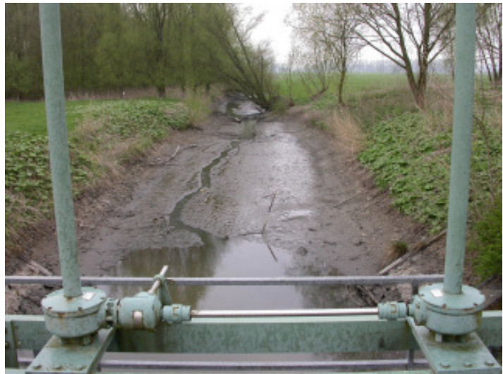
Foto 16: Haseldorfer Binnenelbe – Uferbereich mit Mündungs- trichter
