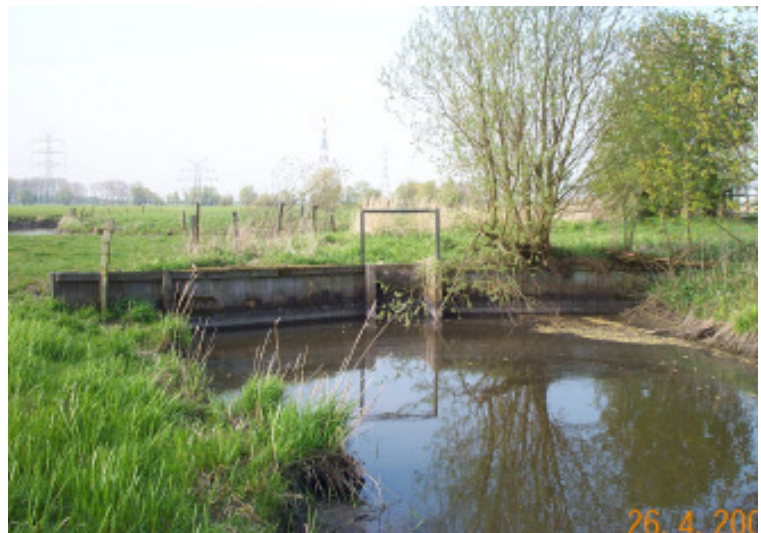
Foto 10: Anschluss Entwässerungs- graben an den Kiebitzritt
