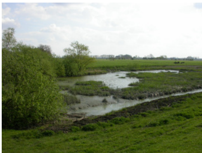
Foto 28: Grabenaushub am Bullenfluss
