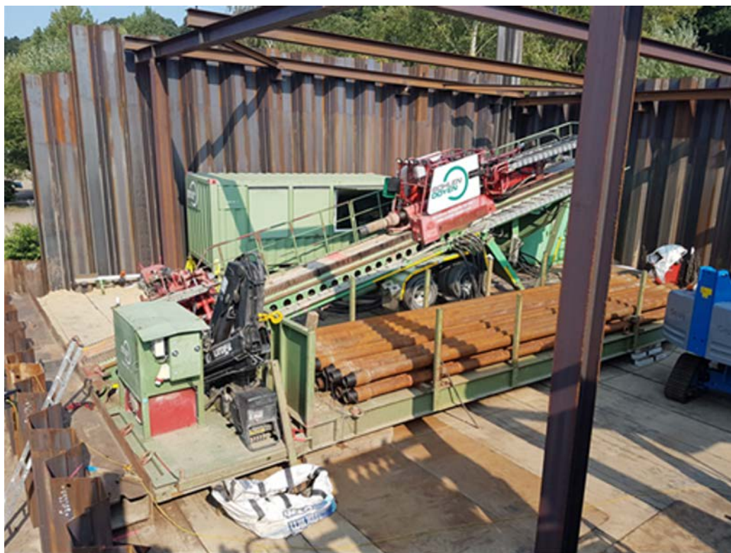
Abbildung 3-23: HDD-Rig für Pilotbohrung und Einzug des neuen Dükers Neßsand mit Lärmschutzeinhausung
