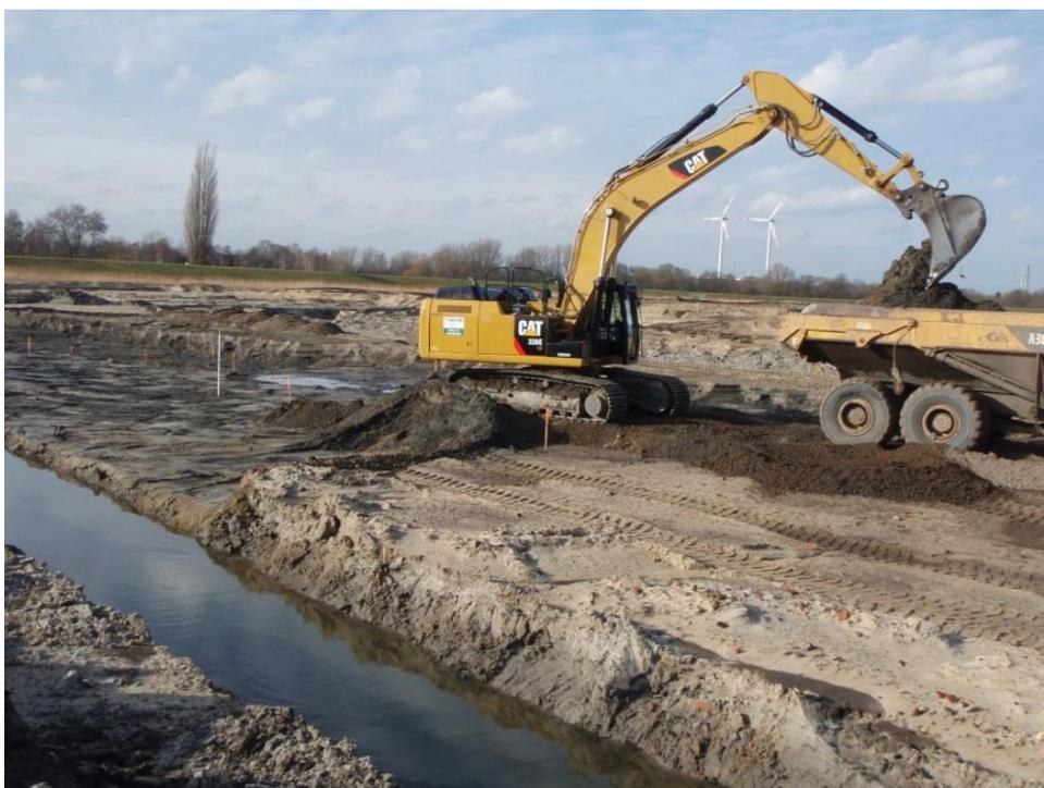
Abb. 6: Trennscharfer Bodenaushub
