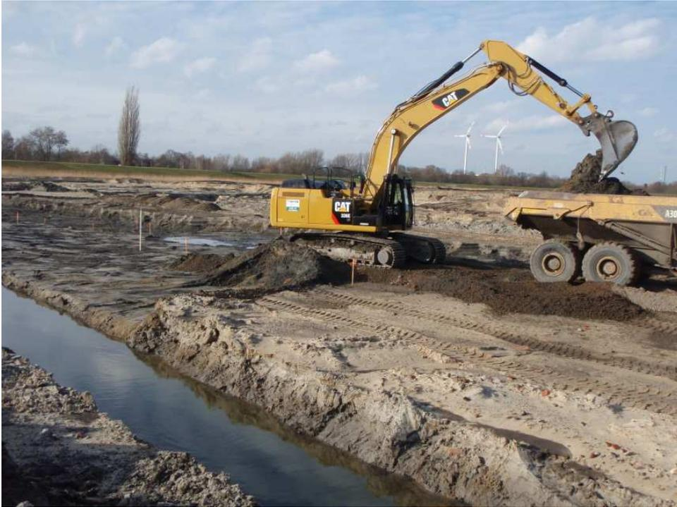
Abb. 2: Trennscharfer Bodenaushub
