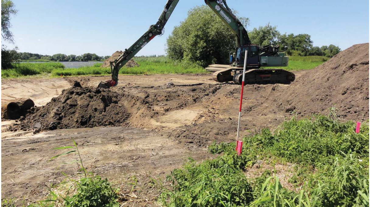
Abb. 3-2: Langarmbagger bei der Profilierung des Priels
