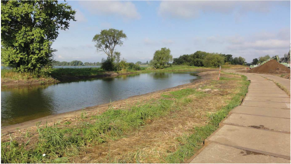
Abb. 3-4: Fertiggestellter Priel bei auflaufendem Wasser
