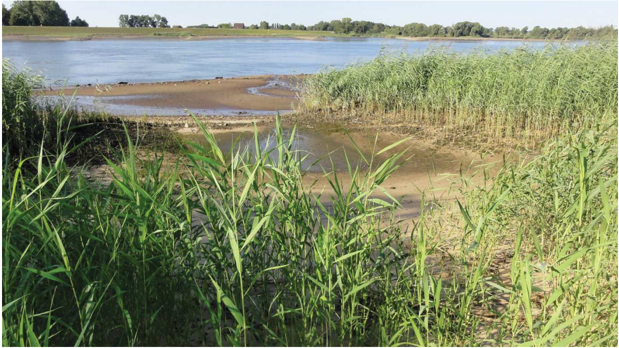
Abb. 3-6: Uferschlenze unmittelbar nach der Herstellung
