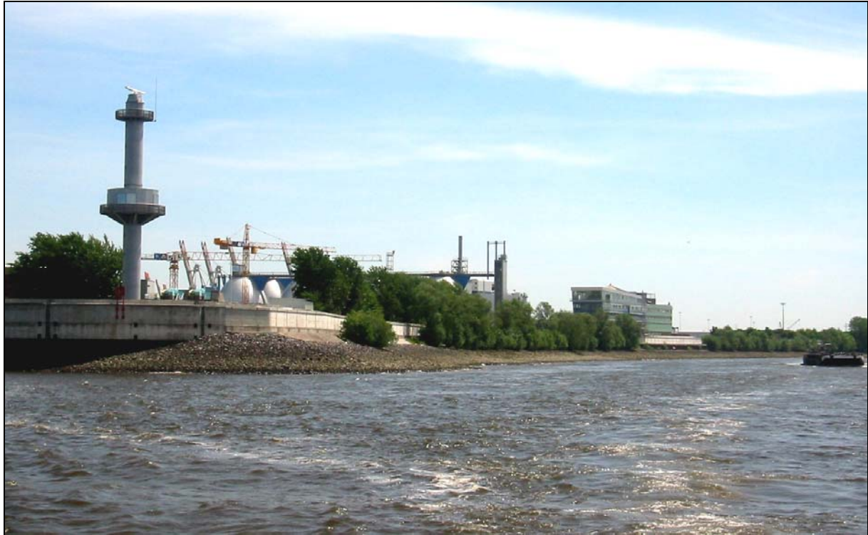
Abb. 5.3-1: Blick von Norden auf die Ostseite der Köhlbrandkurve
