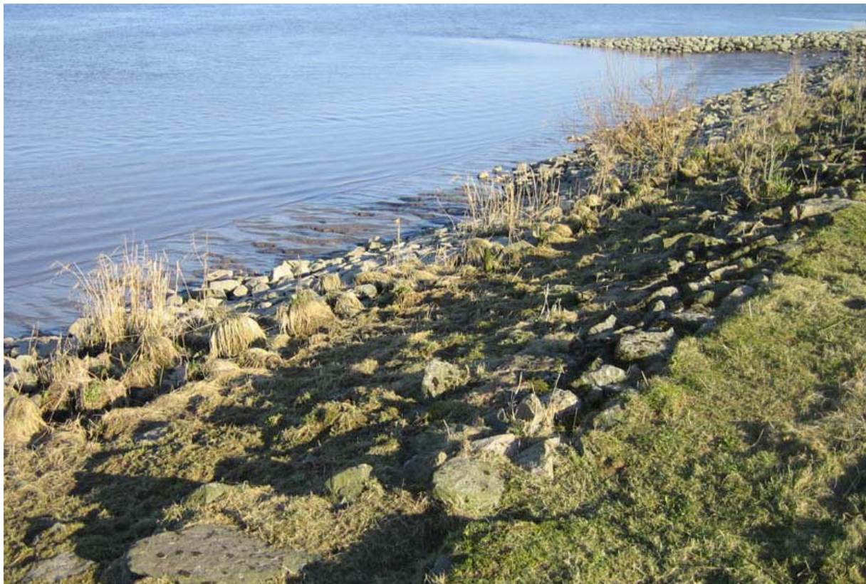
Foto: Deckwerk am Asseler Sand
