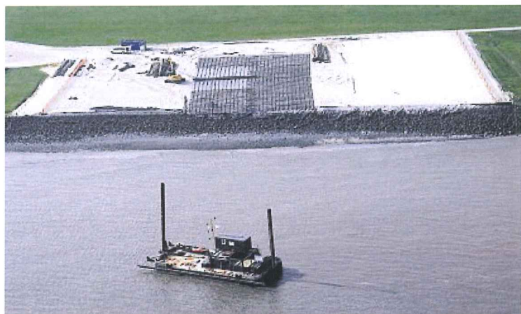
Mehrere solcher großen Sinkstücke werden im Deichvorland bei Wehldorf vorgefertigt und dann mit dem Schiff an Ort und Stelle geschleppt. Dort wird das Sinkstück positioniert und dann mit Steinen beschwert, so dass es absinkt.
