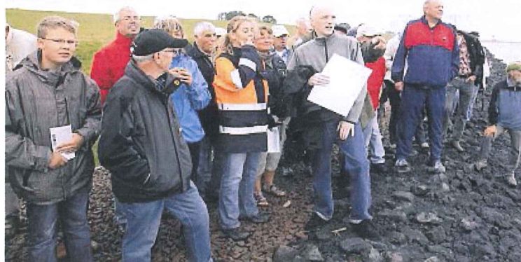
Ralf Elfering (mit dem Papier in der Hand) und Melanie Wiegmann erläutern den Bürgern die Vorgehensweise beim Buhnenbau. Knapp 40 Einheimische nahmen an der jüngsten Baustellenbesichtigung teil. Fotos: WSA/Sassen
