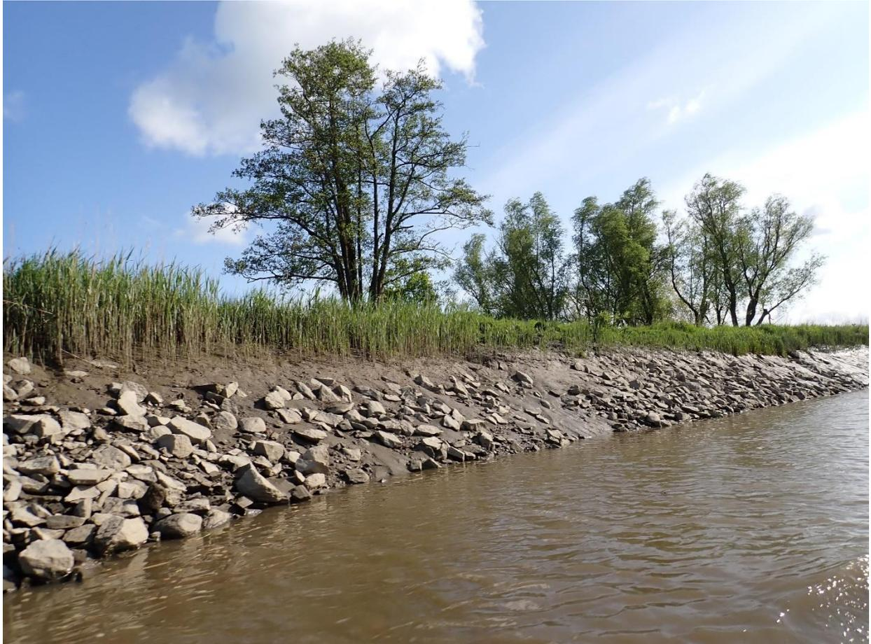
Abbildung 4-2: Steinschüttung an einem Prallhang am rechten Ufer in Neuendorf bei Km 7,62 (16.05.2023)
