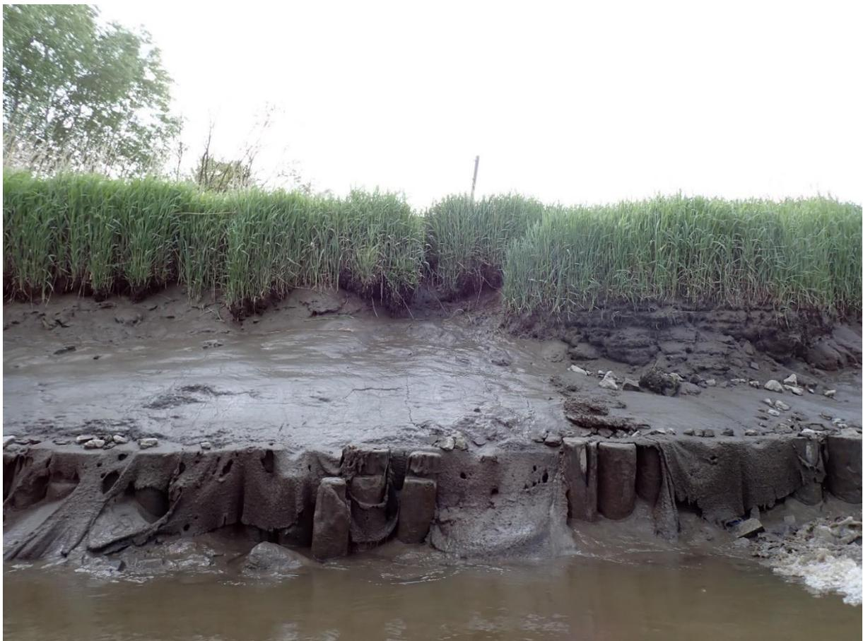
Foto 10-28: Steinschüttung und vorgelagerte Pfahlreihe am linken Ufer in Seester bei Km 6,24 (16.05.2023)
