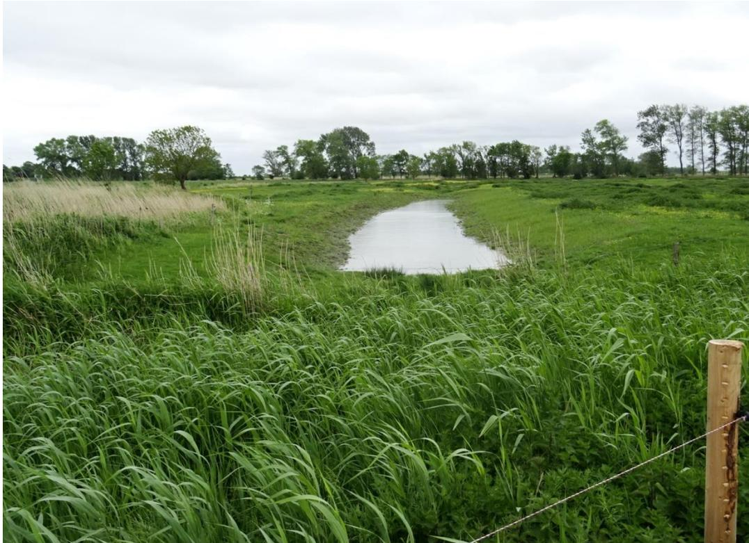
Foto 11-14: Aufgeweitete Grüpe am linken Ufer der Stör bei Km 46,11 als Beispiel für die Anlage von Auengewässern zur Entwicklung von Feucht- und Nassgrünländern (25.05.2020)
