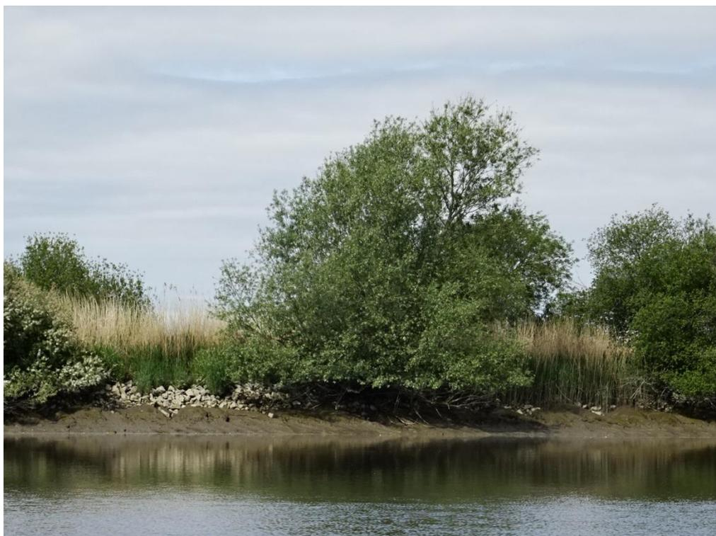
Foto 11-2: Zulassen von Schäden und Lücken in der Ufersicherung (geschüttete Wasserbausteine) am linken Ufer der Stör bei Km 46,33 (20.05.2020)
